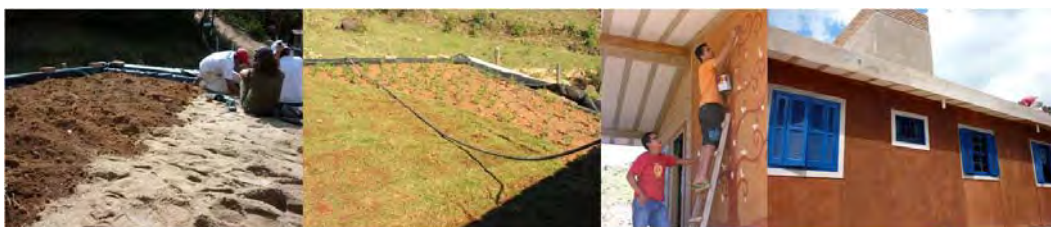
Figura 5 – Início do teto verde e sua conclusão, assim como a finalização da pintura à base de terra (GEAHAS, 2009)
