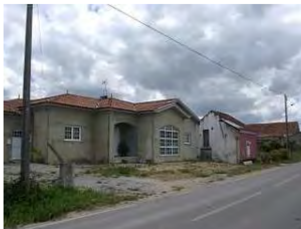
Fig.5 – Casa parcialmente destruída em Corticeiros de Cima (Cantanhede-Coimbra), (Créditos: Maria Fernandes, 2006)
