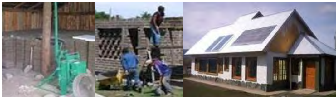
Fig. 5 – Vivienda Maituyén (Crédito: Mele, De Benito, Garzón; 2005-2007).
