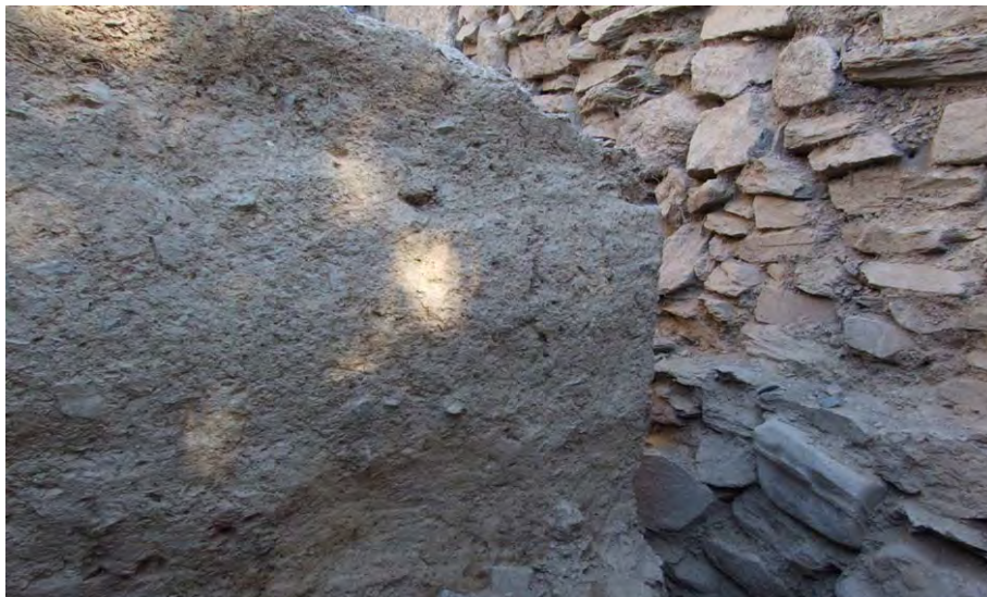
Fig. 8 – Parede em taipa cortada por um dos pórticos do fórum (créditos: Pedro Carvalho).
