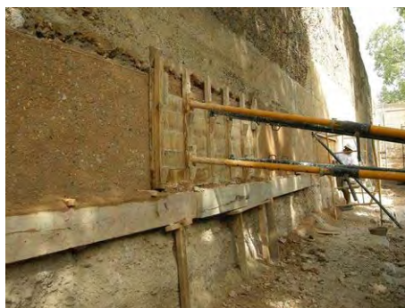
Fig. 4- Restitución de cajones a una cara en la Muralla de Sevilla (créditos: J. Canivell, 2007)
