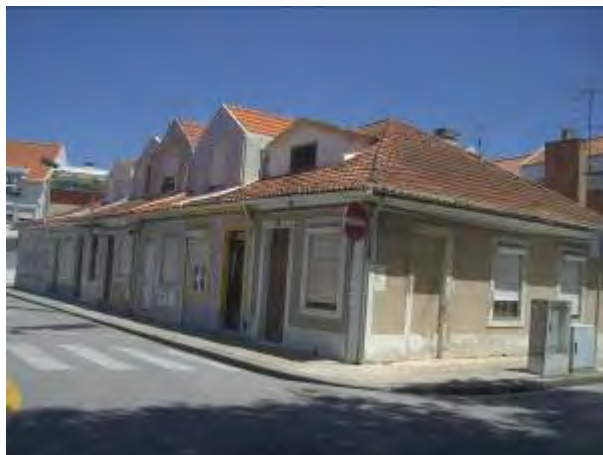
Fig.6 – Várias alterações e patologias em casas intervencionadas no bairro Alboim em Aveiro, (Créditos: Maria Fernandes, 2009)
