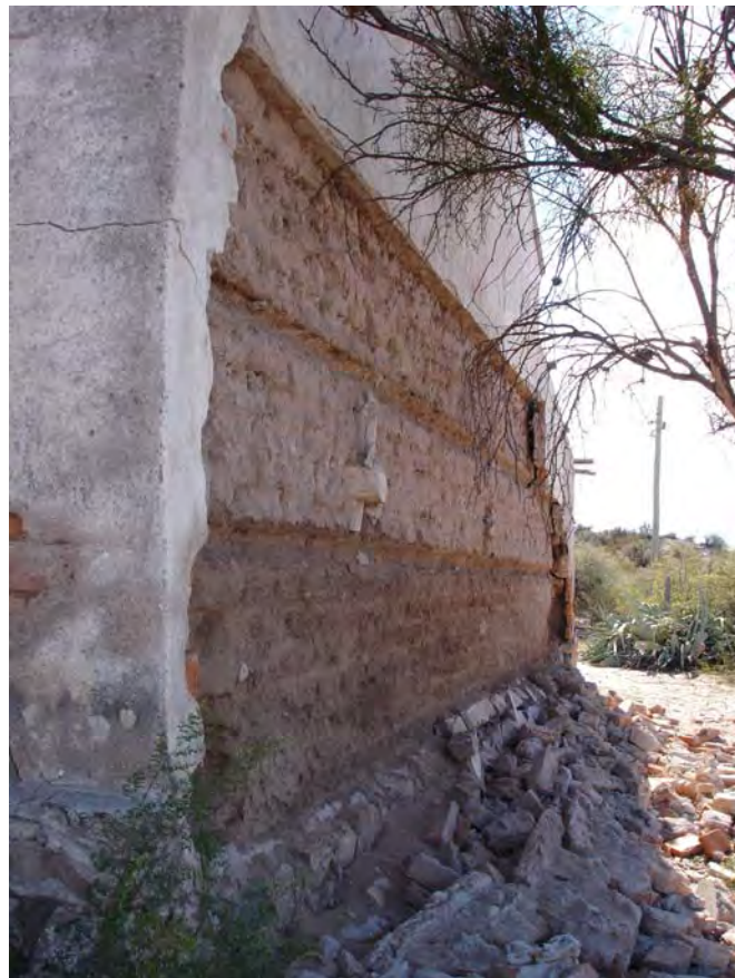
Fig. 4. Sucesivos arreglos erróneos de revoques en Chepes Viejo, La Rioja, Argentina (crédito autora, 2006)
