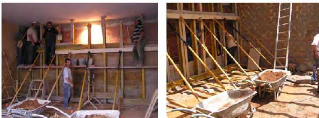
Fig.5 - Execução das paredes de taipa (Vera Schmidberger – 2008)
