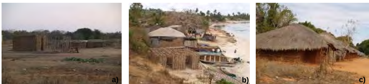
Fig. 2 a) Construção rudimentar de pau-a-pique com revestimento de terra, Boane, zona de Maputo; b) Construção (inacabada) de pau-a-pique em Pemba; c) palhotas com revestimento de barro, Pemba (créditos: Margarida Donas Botto, 2009)
