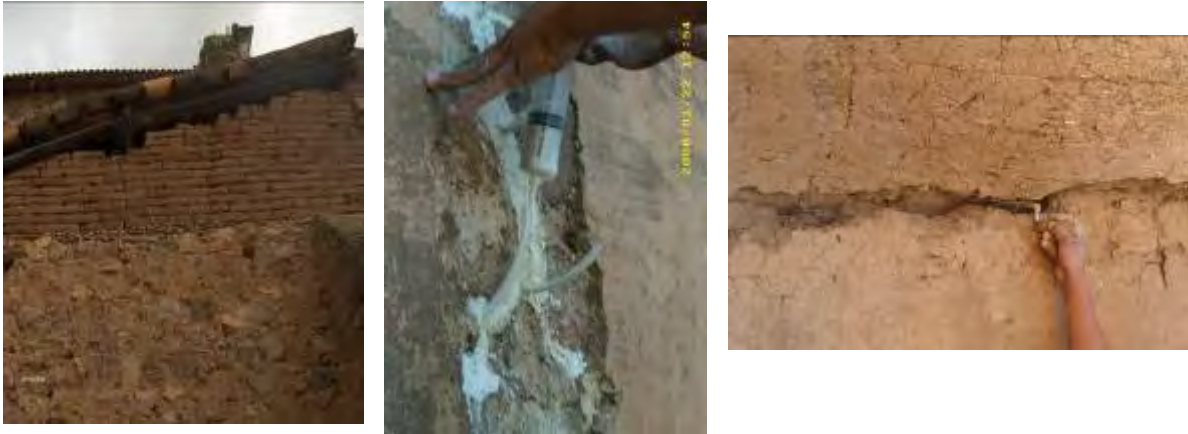
Figura 1 - muro de adobe desplantado sobre mampostería pétrea para impedir humedad capilar y dar pendiente a techumbres ligeras; Ucareo, Michoacán, México, (crédito W. Martínez Molina).
