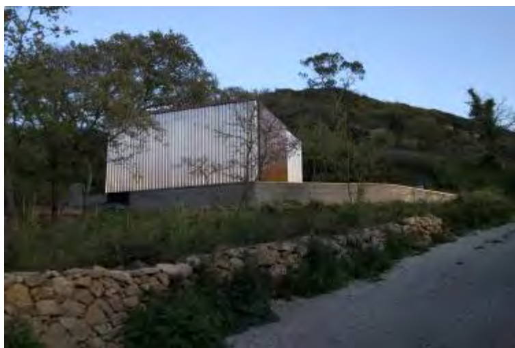
Fig.2 – Casa em Arruda dos Vinhos, Arruda dos Vinhos. (Créditos: Sandra Pereira, 2008).
