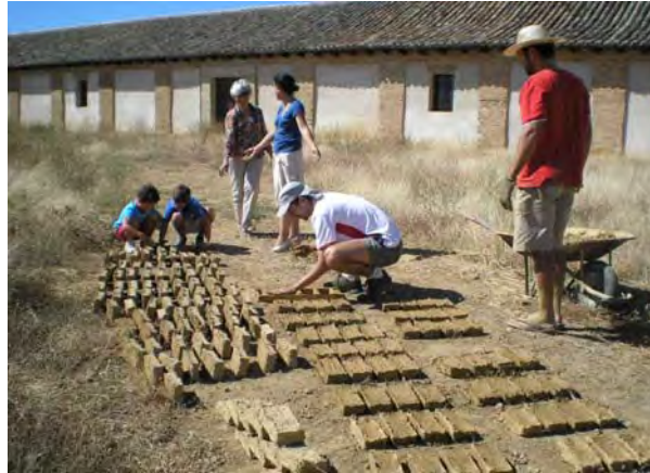
Fig.4 - Varias generaciones tendiendo adobes para la bóveda a orillas del canal de Castilla (créditos: estepa, 2009).
