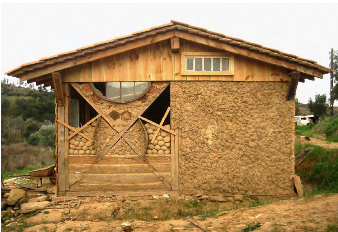
Fig.3 – Casa em construção no 'Centro Ambiental de Cabaços (CAC) – Terra, Vento, Fogo e Água', em Cabaços, Odemira, Portugal. (Crédito: Ricardo Pires, 2009).
