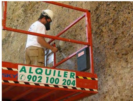
Fig. 3- Aplicación de consolidante en la Muralla de Sevilla (crédito: J. Canivell, 2007)
