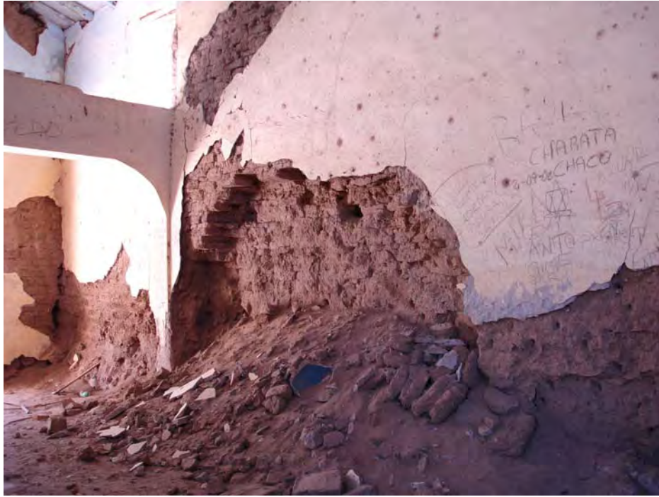
Fig. 3. Resultados de la inclusión de viga de hormigón en Chepes Viejo, La Rioja, Argentina (crédito autora, 2006)
