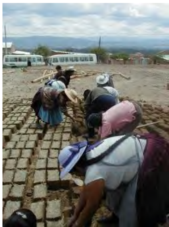
Fig.1 – Fabricación de adobe, Cochabamba, Bolivia. (Crédito: Shinichiro Takahashi, 2001)
