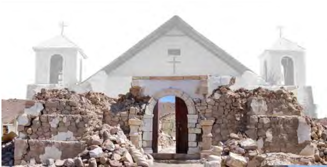
Fig. 3 - Iglesia de Limaxiña, ortofotografías levantamiento crítico, estado derrumbada. Limaxiña, Iquique, Chile. (Créditos: Surtierra, 2009)
