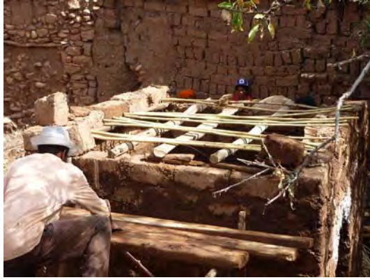
Fig. 8 - Preparación de la cubierta (créditos: autora).
