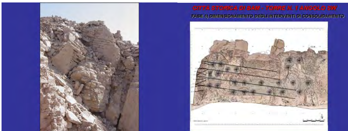
Fig. 5 – Vista del estado del daño en la torre y plan de perforaciones ortogonales e inclinadas, para refuerzos de fibra de vidrio. Ciudadela de Bam, Irán. (Crédito: Ing. Valter Santoro, 2008).
