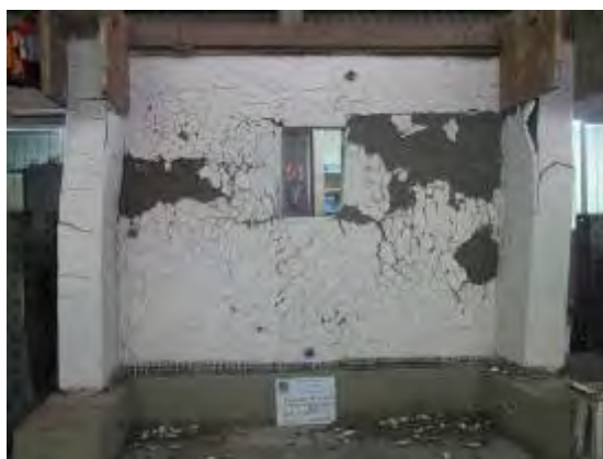
Figura 6 – Aspecto de muro reforzado tras haber sido ensayado bajo carga cortante cíclica
