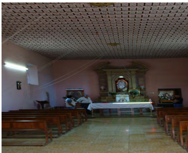
Fig. 3 Vista interior mostrando la utilización de materiales tradicionales como el tejamanil decorado en el plafón (Crédito: F. Méndez, 2009).
