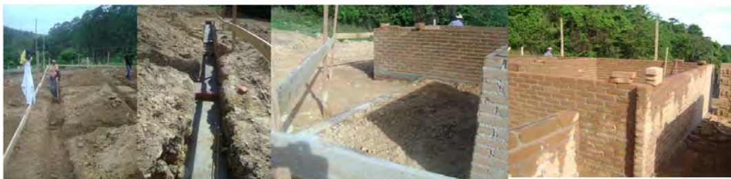
Figura 1 – A Casa de Apoio do Projeto CRESCER começa a tomar forma: a locação, a fundação (sapata corrida em concreto) e a alvenaria de BTC (Crédito: Rosana Parisi, setembro/outubro de 2008)
