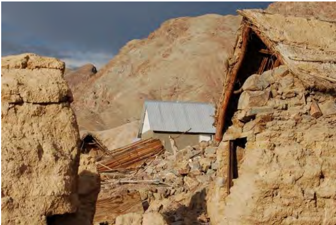
Fig. 2 - Pueblo de mocha que muestra las nuevas edificaciones que reemplazan a las antiguas viviendas del pueblo construidas con tierra y piedra, destruidas por el terremoto del año 2005
