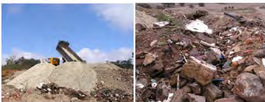
Fig. 3 - Demolições (Vera Schmidberger - 2008)
