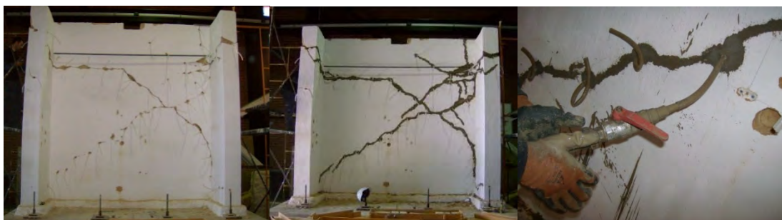
Fig. 15 – Mangueiras de injeção; Fig. 16 – Selagem das fissuras; Fig. 17 – Injeção da goma de cal hidráulica sob pressão (créditos: autores 2009).
