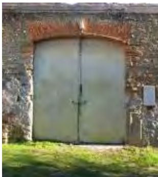
Figura 6. Arco em lamelas de cerâmica
