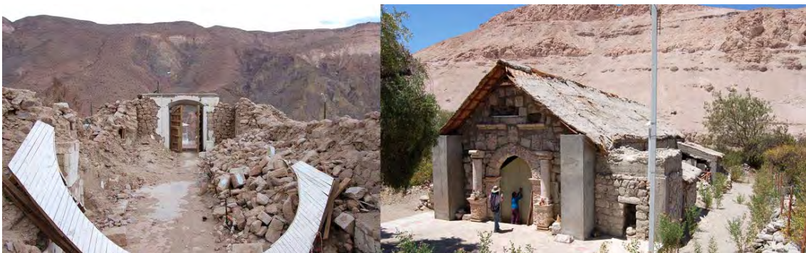
Fig. 5- Iglesia de Limacsiña en total colapso estructural, e iglesia de Huasquiña con graves daños producto de la implantación de una estructura de hormigón. (Créditos: Surtierra Arquitectura, 2009)
