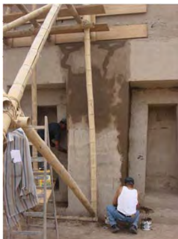
Fig. 4 – Aplicaciones de reparación de fisuras por inyección de barro líquido en el Acllawasi. Soluciones amigables. Crédito: Sofía Rodríguez Larraín, 2008
