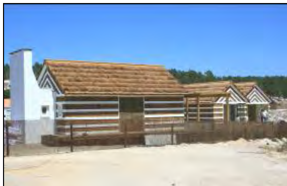
Fig. 6 – Casas de férias, com estrutura de betão armado, em construção (Praia do Pego, Carvalhal) (Crédito: Patrícia Bruno, 2009)
