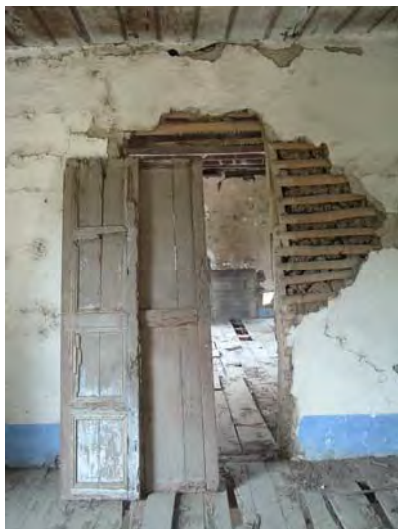
Fig. 5 – Casa de Jorge Isaacs: muro en bahareque y piso en madera (Crédito: Olimpia Niglio, 2007)
