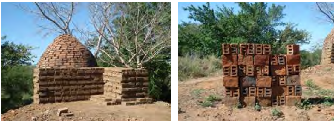
Fig. 6 Tijolos secos preparados para serem cozidos no forno e depois de cozidos, prontos para venda (créditos: Margarida Donas Botto, 2009)
