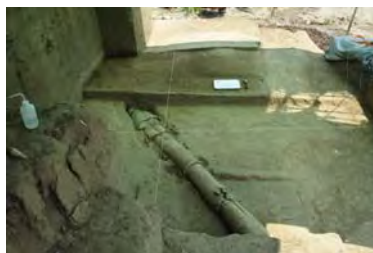
Fig. 3. Tubería de drenaje pluvial de barro cocido. (Crédito: Annick Daneels, 2008)
