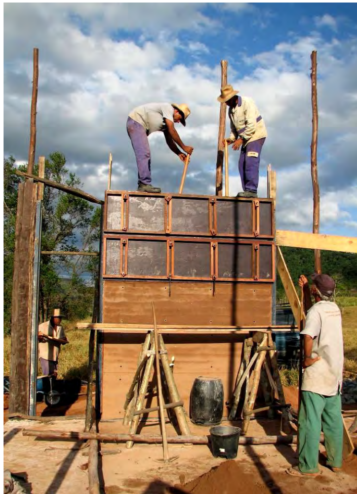
Figura 4 – Construção de parede de taipa de solo-cimento. (Crédito: José Euzébio, 2009)
