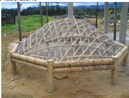
Figura 5. Prototipo de domo caña realizado en guadua, técnica desarrollada en Perú; transferencia del taller realizado por la Ing. Raquel Barrionuevo /Perú. (Crédito: Lucia Esperanza Garzón, 2009)
