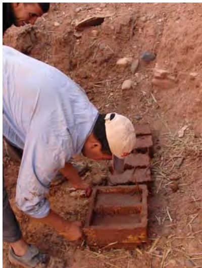
Fig. 4 - Ejecución de ladrillos de adobe (créditos: autora).
