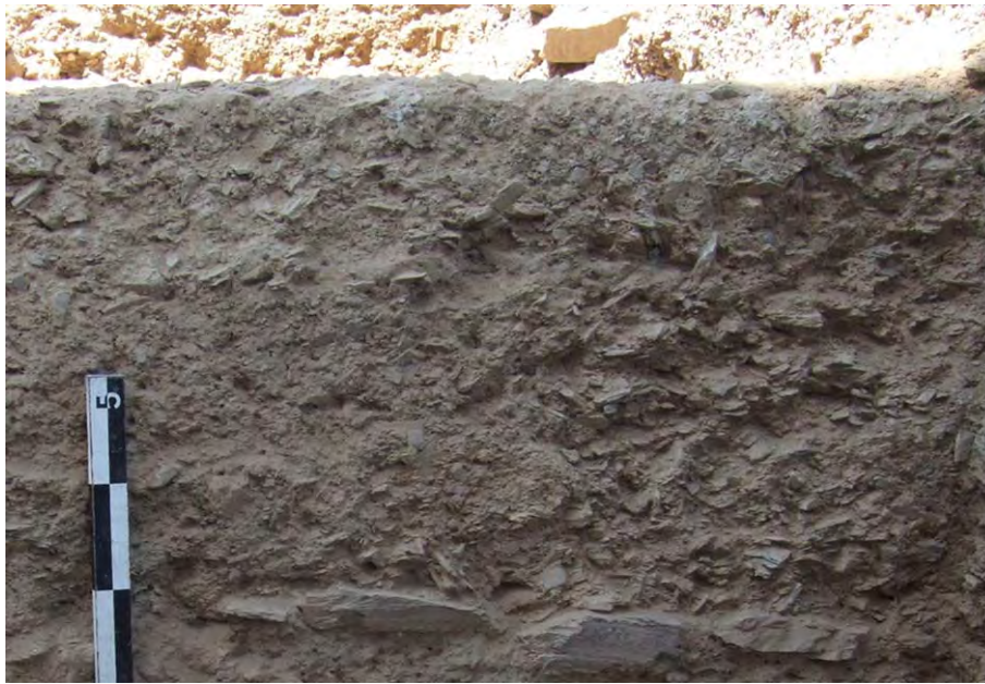
Fig. 7 – Fiada de estreitas lajes de xisto a marcar a linha de contacto da parede em taipa com o chão térreo (créditos: Pedro Carvalho)
