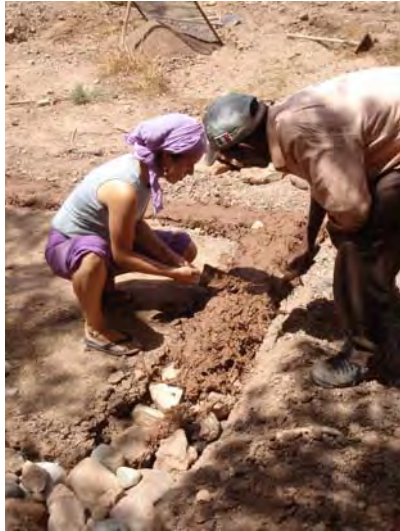
Fig. 2 - Cimentación (créditos: autora).
