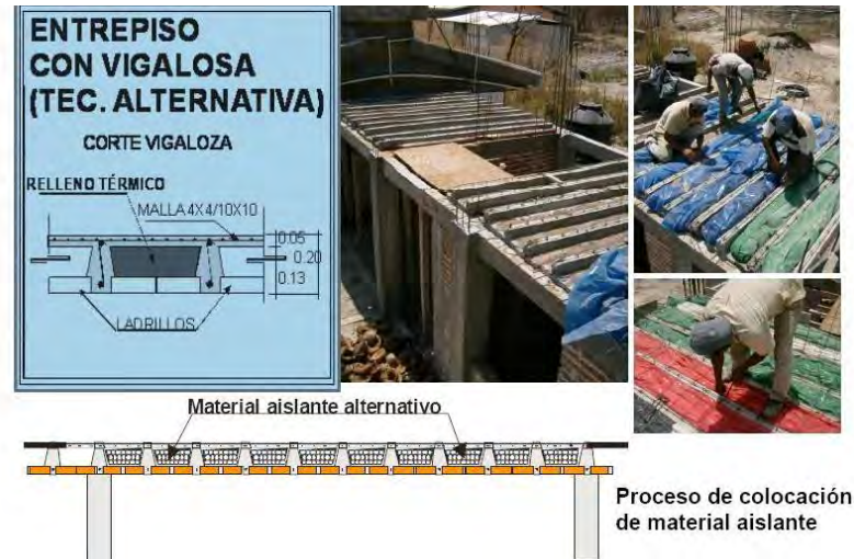
Figura 3 – Esquema da laje leve mexicana que emprega como enchimento leve casca de coco, serragem, ou resíduo de PET. Protótipo instalado no campus da Universidad Autónoma de Chiapas, México (Crédito: Gabriel Castañeda, 2008)
