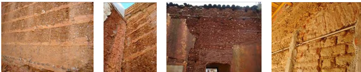
Fig.5 – Exemplos de taipa na aldeia da Trindade, fotografias do levantamento (Crédito: Eleonora Silva)
