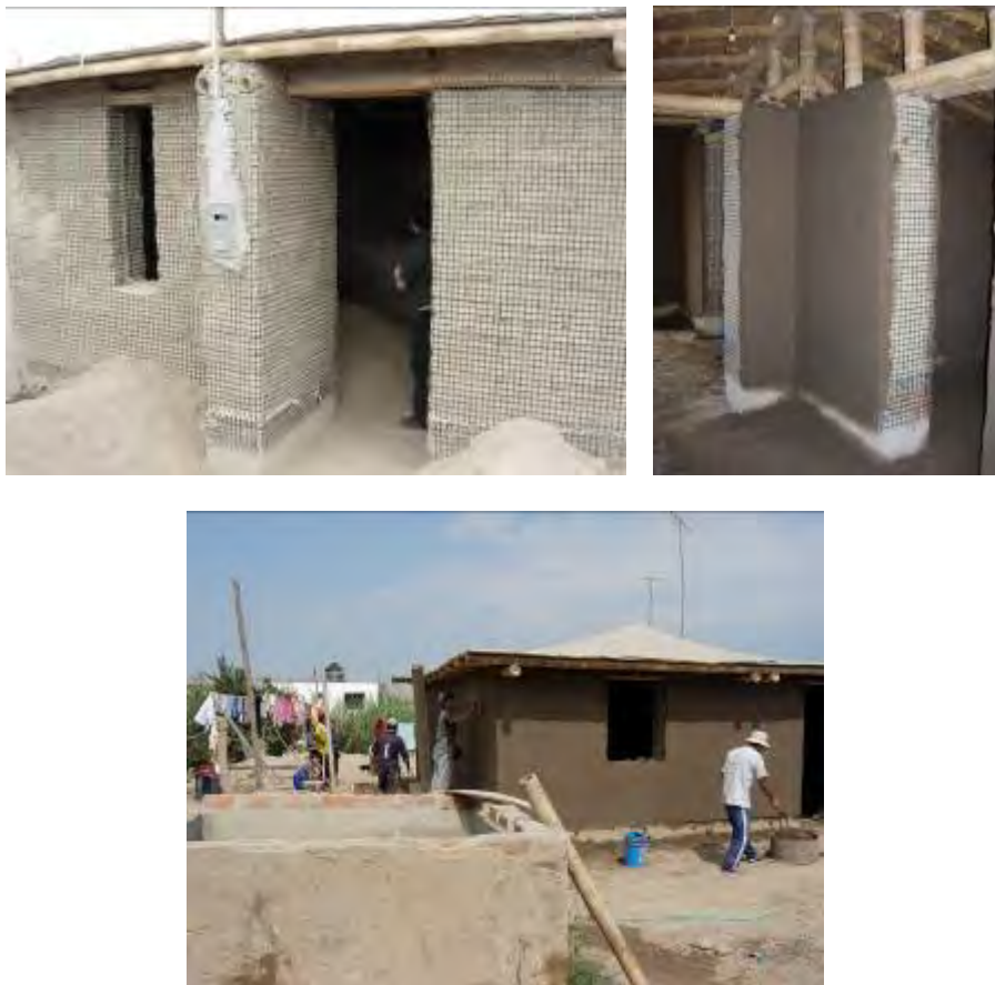
Figura 2 – Algunas de las viviendas de adobe reforzado construidas en el poblado de La Garita (distrito El Carmen, Chincha) con la asistencia técnica de la PUCP
