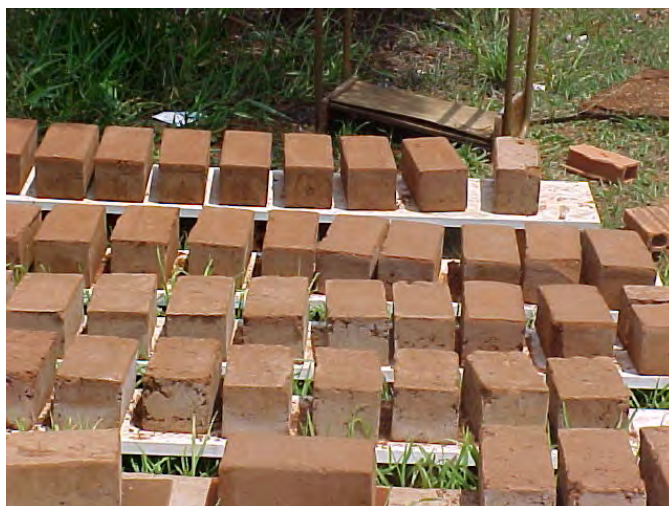
Fig. 2 – Produção de adobes e duas fases da construção de um protótipo de habitação de interesse social, na UNESP-Bauru (FARIA, 2007).
