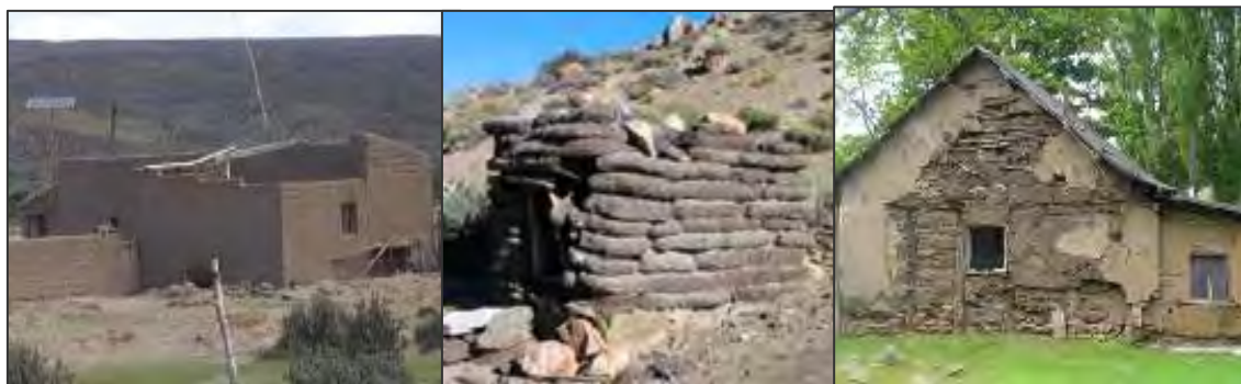
Fig. 2 – Mampostería de adobe, mampostería de champa y entramado de ramas y barro, con torta de barro y cubierta de chapa de zinc (Créditos: Mele, De Benito, Garzón; 2004-2007)
