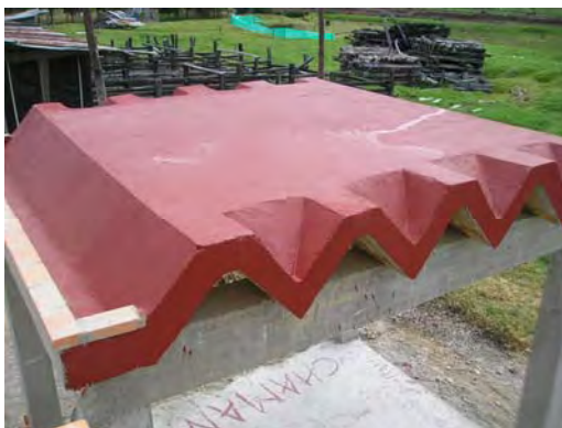
Figura 4 – Prototipo de bovedillas construidas con bloque tierra cemento – BTC. Sistema innovador que funciona como entrepiso y como cubierta. Taller dirigido por la Arq. Clara Ángel (Colombia) (Crédito: Lucia Esperanza Garzón, 2009)
