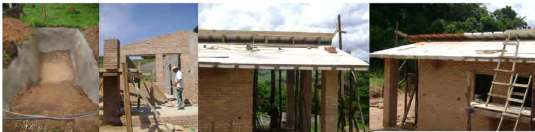
Figura 4 – Construção do tanque de evapotranspiração para o tratamento do esgoto, alvenaria e lajes cerâmica e com EPS concretadas (GEAHAS,2009)
