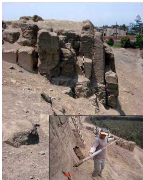
Fig. 3 – Muro de sostenimiento debilitado, que se inyecta para multiplicar su resistencia frente a los empujes laterales del relleno. (Crédito: Mirna Soto, 2008).
