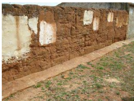
Fig. 1- Protección mediante recreado de piedra en la base (crédito: J. Canivell, 2009)
