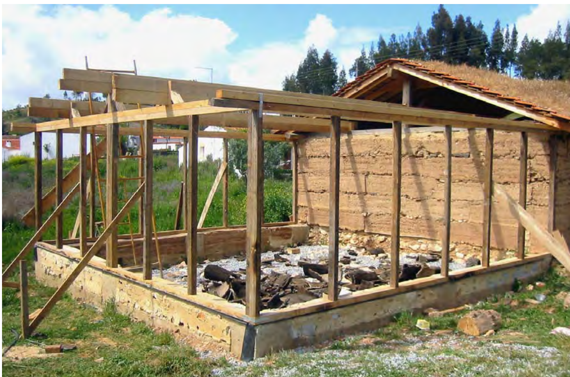
Fig.2 – Casa em taipa e estrutura anexa em construção: madeira sobre fundações à base de cal hidráulica, areia e pedra calcária, no 'Centro Ambiental de Cabaços (CAC) – Terra, Vento, Fogo e Água', em Cabaços, Odemira, Portugal. (Crédito: Ricardo Pires, 2009).
