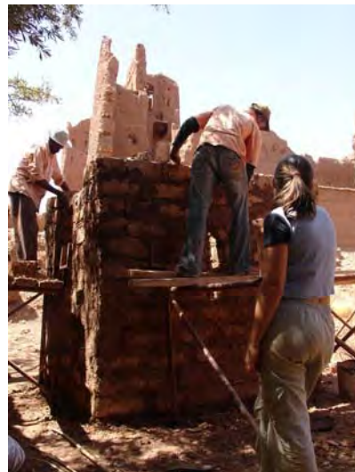
Fig. 5 - Levantamiento del muro (créditos: autora).
