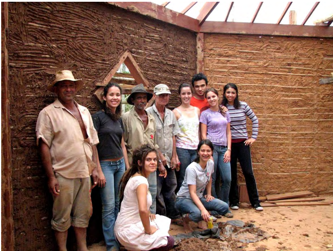
Figura 5 – Equipe de alunos com os trabalhadores locais após construção do pau-a-pique. (Crédito: José Euzébio, 2009)
