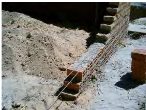
Fig. 2 – Barra de aço estendida entre o baldrame (feito com blocos cerâmicos) e a parede de adobe (Crédito: Sandra Saraiva, 2006)
