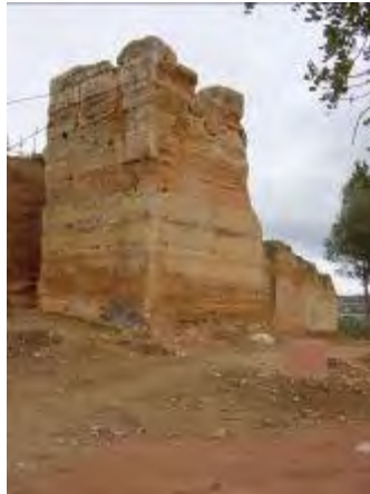
Fig. 1 – Construção em taipa de pilão em Paderne, Portugal. (Crédito: Luis F. Guerrero, 2005)
