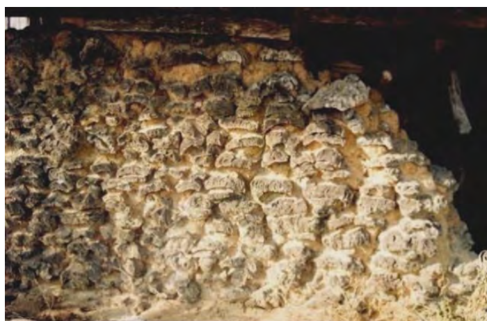
Fig. 1 – Parede em "alvenaria de pranchas de cortiça" na Herdade da Gralheira, Montemor-o-Novo (Crédito: Rui Ferreira, 2000)
