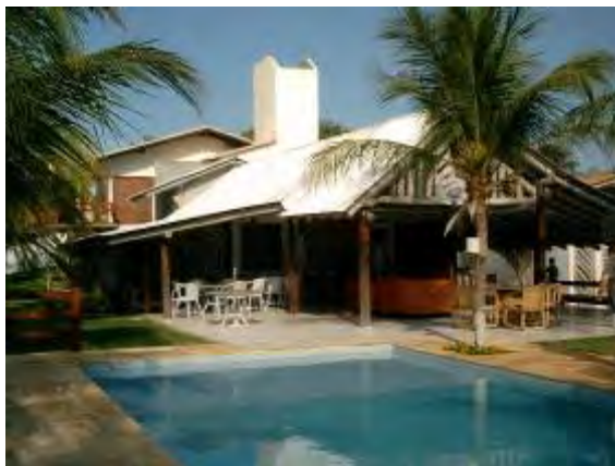
Fig. 3 – Casa de veraneio executada com taipa de sopapo, em Luis Correia, PI (Crédito: Sandra Saraiva, 2006)
