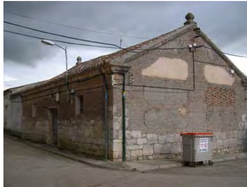
Fig. 6. Edificio de piedra, ladrillo y madera en Pedrosa del Rey, provincia de Valladolid.
