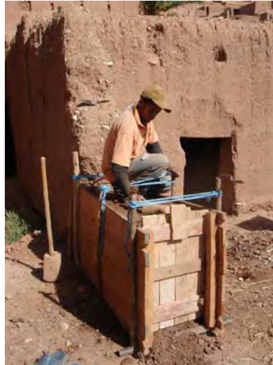
Fig.3 - Construcción de tapial (créditos: autora).
