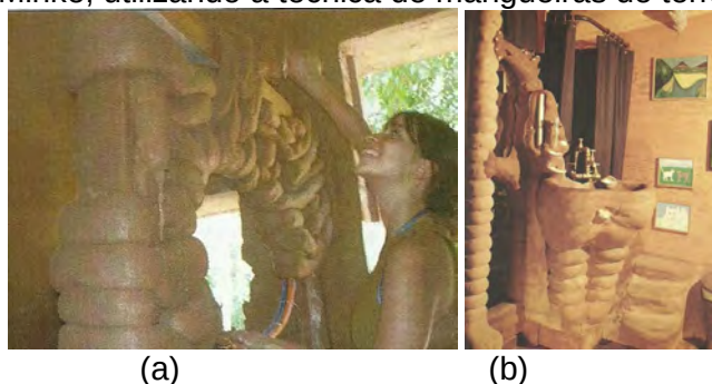
Figura 03: (a) confecção de uma parede, com utilização da técnica de mangueiras, no Centro Integria; (b) banheiro concluído, com utilização da técnica de mangueiras, em Kassel - Alemanha. Fonte: 46a - Integria; 46b - Minke (2008).
