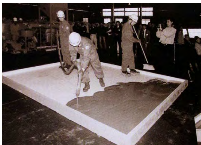
Fig.13 – Investigación de la Universidad de Mopko, tierra vertida fluida, Mopko, Corea (créditos: Bâtir en terre, ed Belin, Cité des sciences et de l'industrie, 2009)
