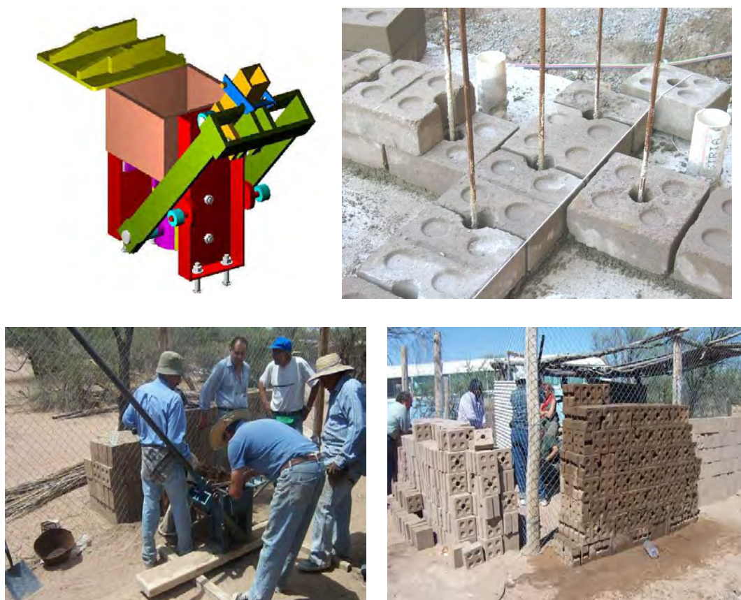
Fig.4 Irpha-Ram-Contrafuerte armado-Sistema Constructivo (créditos: Albarracín- Dubos 2010)
