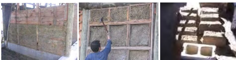
Figura 06: formas de utilização da técnica de terra-palha no Uruguai, respectivamente: taipa, painéis e blocos. Fonte: www.proyecto-hornero.edu.uy/proyecto.htm .
