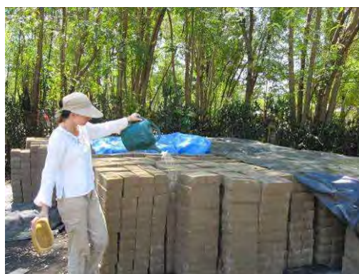
Fig.4 - Curado de los Bloques (créditos: Jim Hallock, 2010)
