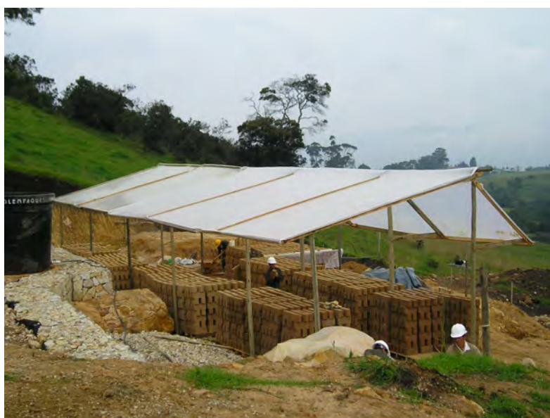
Fotografía 2- Producción de Bloques de suelo cal y cemento, extraídos del suelo local (fotografía Lucia E. Garzón).
