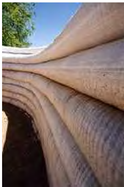
Fig. 3 Muro curvo, Brasil
