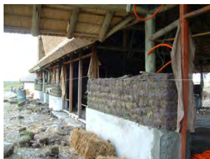
Colocación de terrones en el muro
