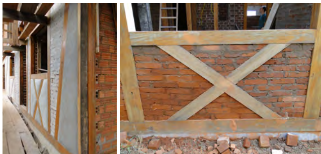
Figura 04: construção em estilo enxaimel, com tijolos assentados com argamassa de barro. Fonte: Juliana Moehlecke.
