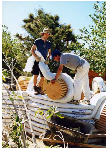
Fig. 1 Ejecución de vivienda con STC, California, EEUU.
