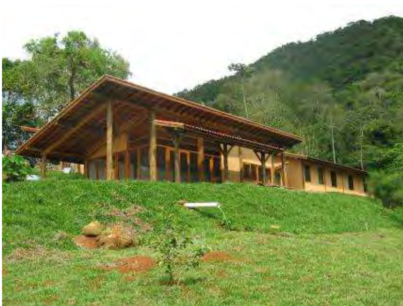
Figura 1.3 Residência em Pau-a-Pique
