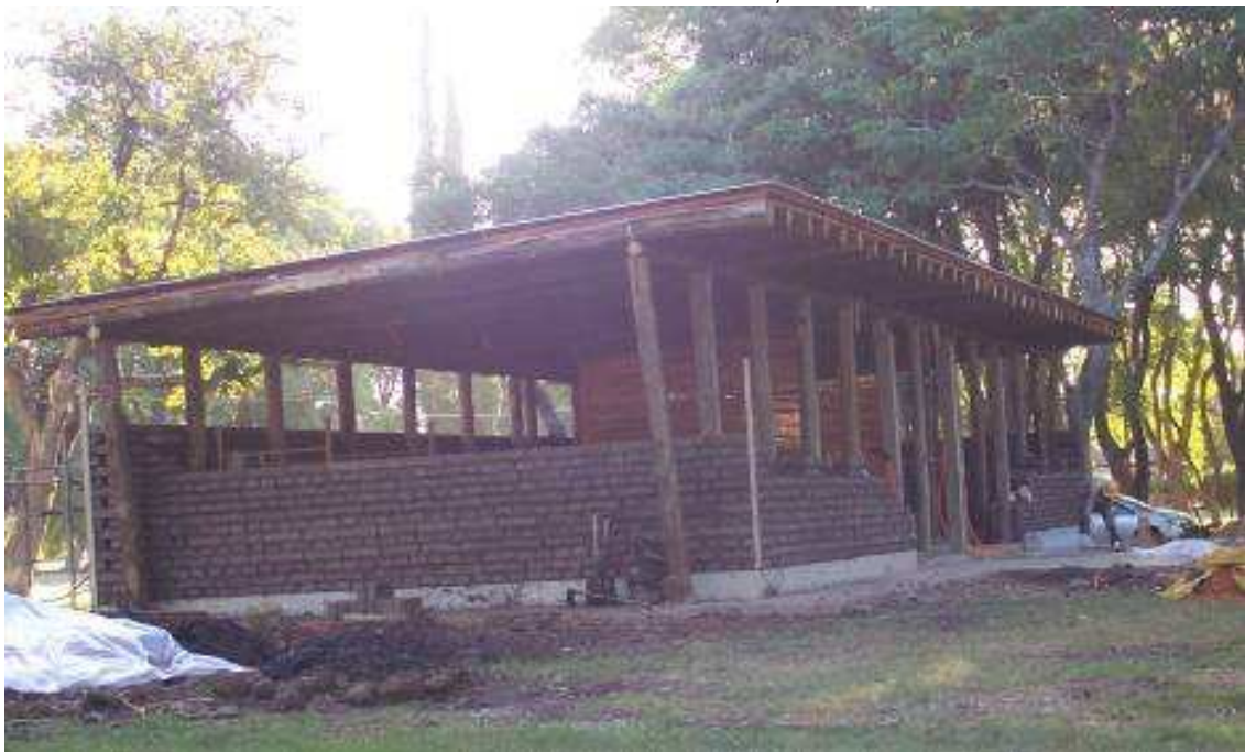
IMÁGENES: ESTRUCTURA DE MADERA, MUROS DE ADOBE
