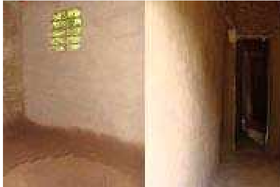
Figura 6 – Reboco liso.
