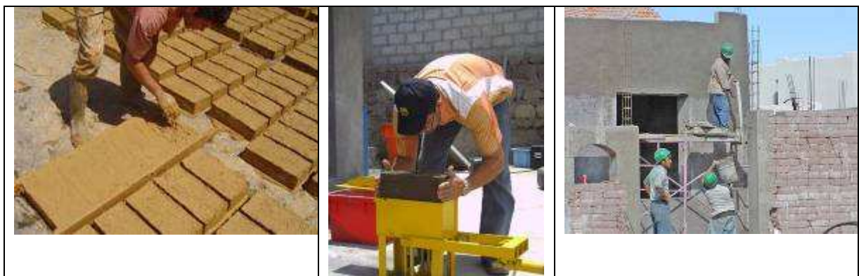
Fig. 4. Etapas en el ciclo de vida de la arquitectura de tierra. Aspectos no ergonómicos: Fábrica de adobe; fábrica de BTC; muros con adobe.
