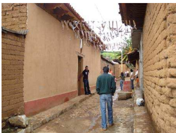
Figura 2. La mayoría de las viviendas tradicionales en la región, se construían a partir de formas geométricas sencillas, por ejemplo una planta rectangular rematada por una cubierta a una o dos aguas, utilizando como materiales los que le proporcionaba la naturaleza, se aprecian los paramentos de los solares dentro de los cuales destaca el predominio del macizo sobre el vano.
