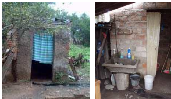
Figura 2: Vista de algunas letrinas y baños
