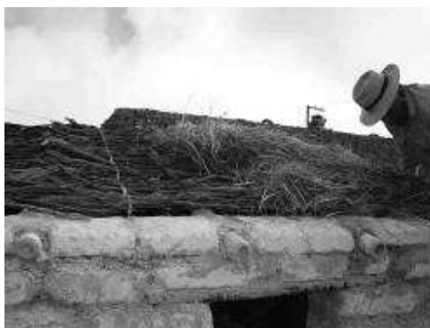
Figura 3, colocación del cijne por parte de un maestro constructor, Rinconada 2008.
