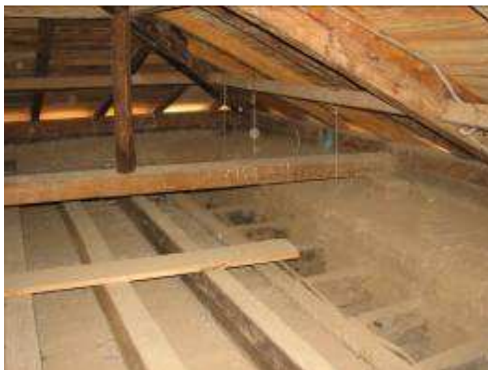
Fig. 5 Vista de estructura mostrando disposición de vigas pares (Fotografía de F. Méndez).
