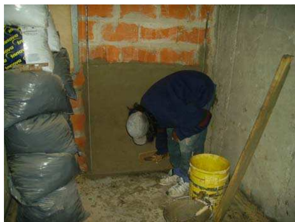
Figura 3: Prototipo de revoque de suelo-cemento-cal (Florencio Varela)
