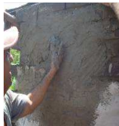
Imag3. Aplicación de Revoque
