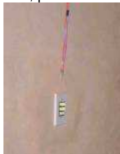
Figura 5 – Aplicação de instalação elétrica.
