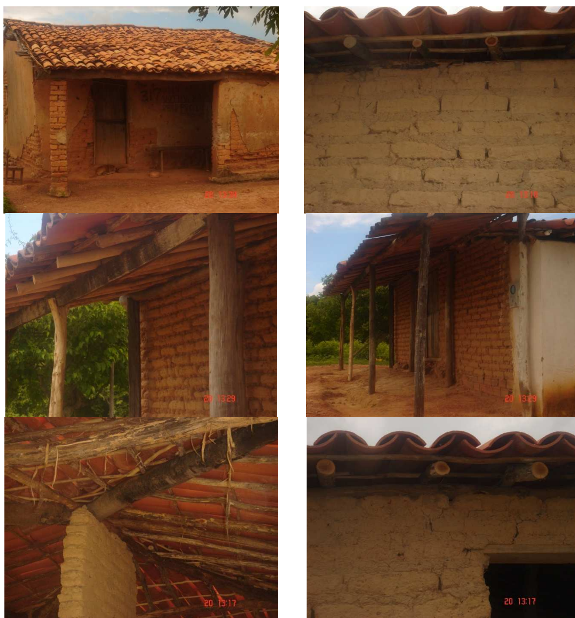
Figura 04 – Detalhes construtivos das construções em adobe.
