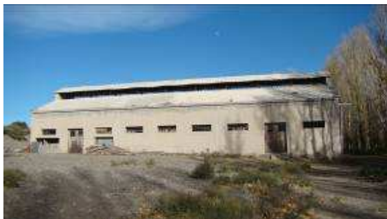
Foto N°3 Intervenciones en muro exterior este
