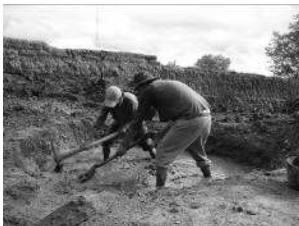
Figura 1, preparación del barro (agregado de tierra), Rinconada 2007.
