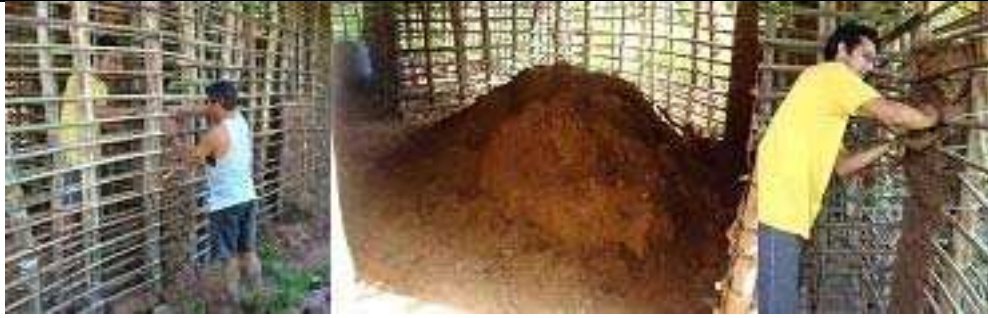
Figura 3 – Preenchimento do entramado e barro armazenado.
