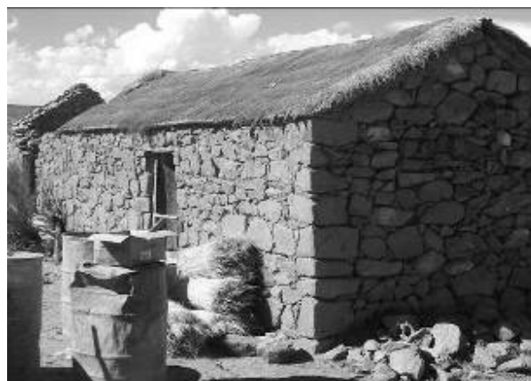
Fig.2. (Der.) Muro de Pirca Húmeda en domicilio rural, Susques 2008.
