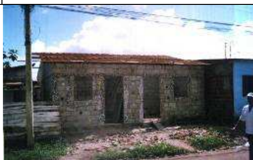
Foto 08-Casa em bloco de argamassa
