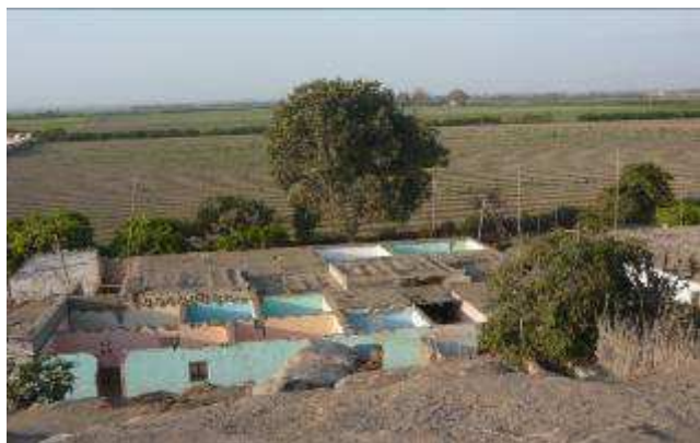
Figura 1 – Vivienda típica de adobe en Santa Luisa
