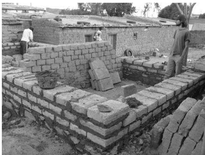
Fig. 3. Colocación de adobe esquinero y elevación de muro sogá , Rinconada, 2007.
