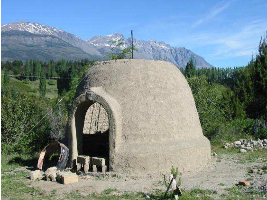
Construcción con adobe en Golondrinas - Chubut
