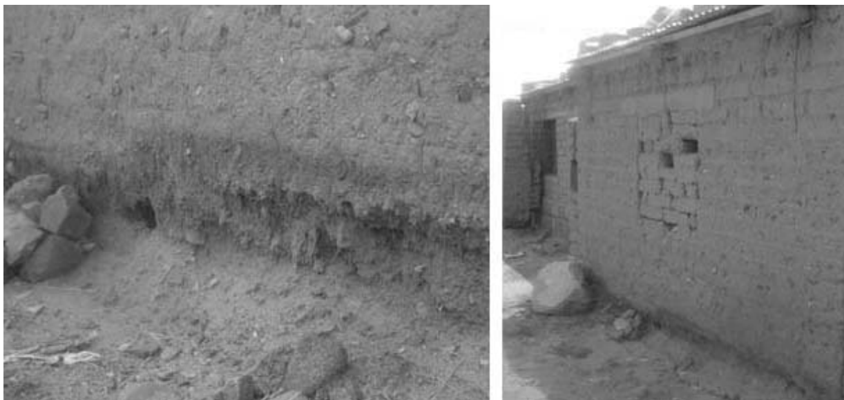
Figs 3 y 4. Presencia de patologías constructivas relacionadas con la humedad por la ausencia de sobrecimientos en la edificación. En este caso urbano se verifica la presencia de humedad y desgaste de los adobes próximos al nivel de suelo. Casa urbana, Susques, 2009.
