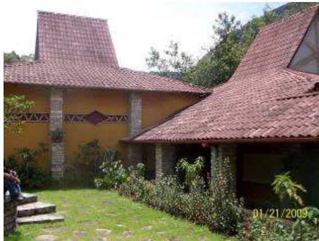
Detalle al interior del primer patio de una de las salas integrada a uno de los dos corredores
