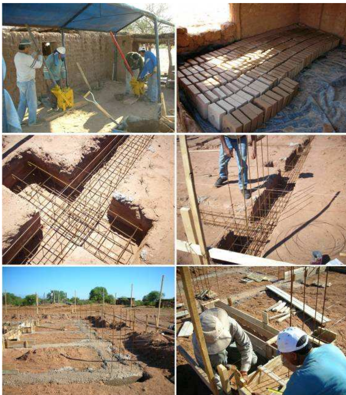
Fig. 4. Arriba: Operarios fabricando los mampuestos de suelocemento con dos prensas IRPHa-RAM. Al medio: Armadura horizontal y vertical en la zanja de la zapata corrida. Abajo: Zapata armada hormigonada y armado de encofrado del sobrecimiento.
