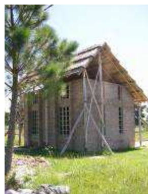
Figuras 4 y 5: Taller de mampostería de bloques de tierra comprimida para constructores locales.
