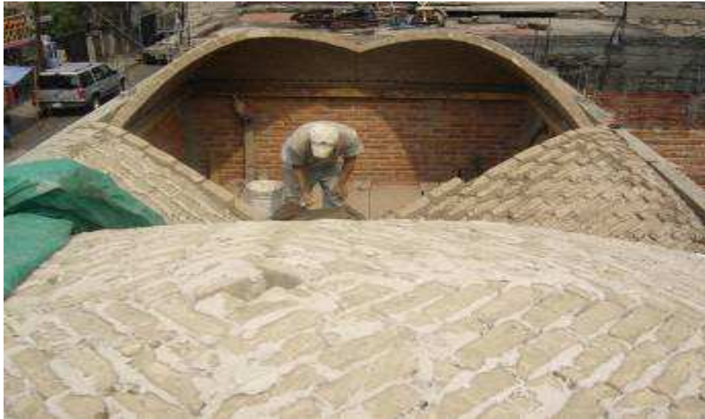
Avance de la segunda bóveda.
