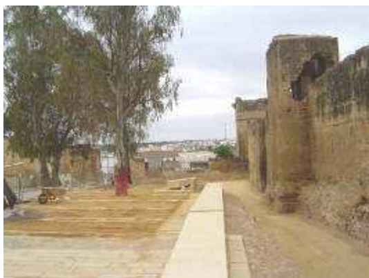
Foto 3: Lienzo muralla acceso Alcazar, en obras.
