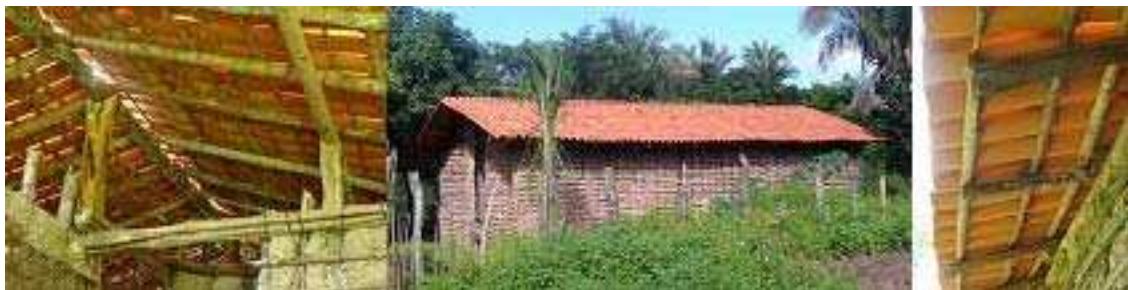
Figura 2 – Estrutura da cobertura, vista externa e beiral.
