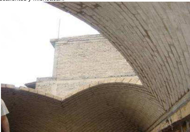
Vista interior del espacio abovedado.
