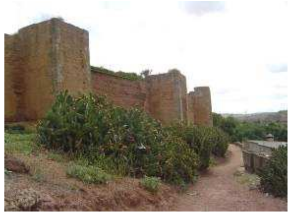
Foto 6: Lienzo muralla antes de puerta del Buey
