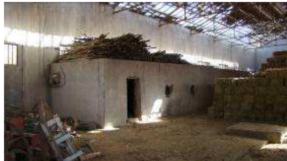
Foto N°4 Intervenciones en el interior de la sidrera
