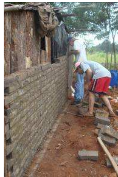
Imag.2 construcción de nuevos muros
