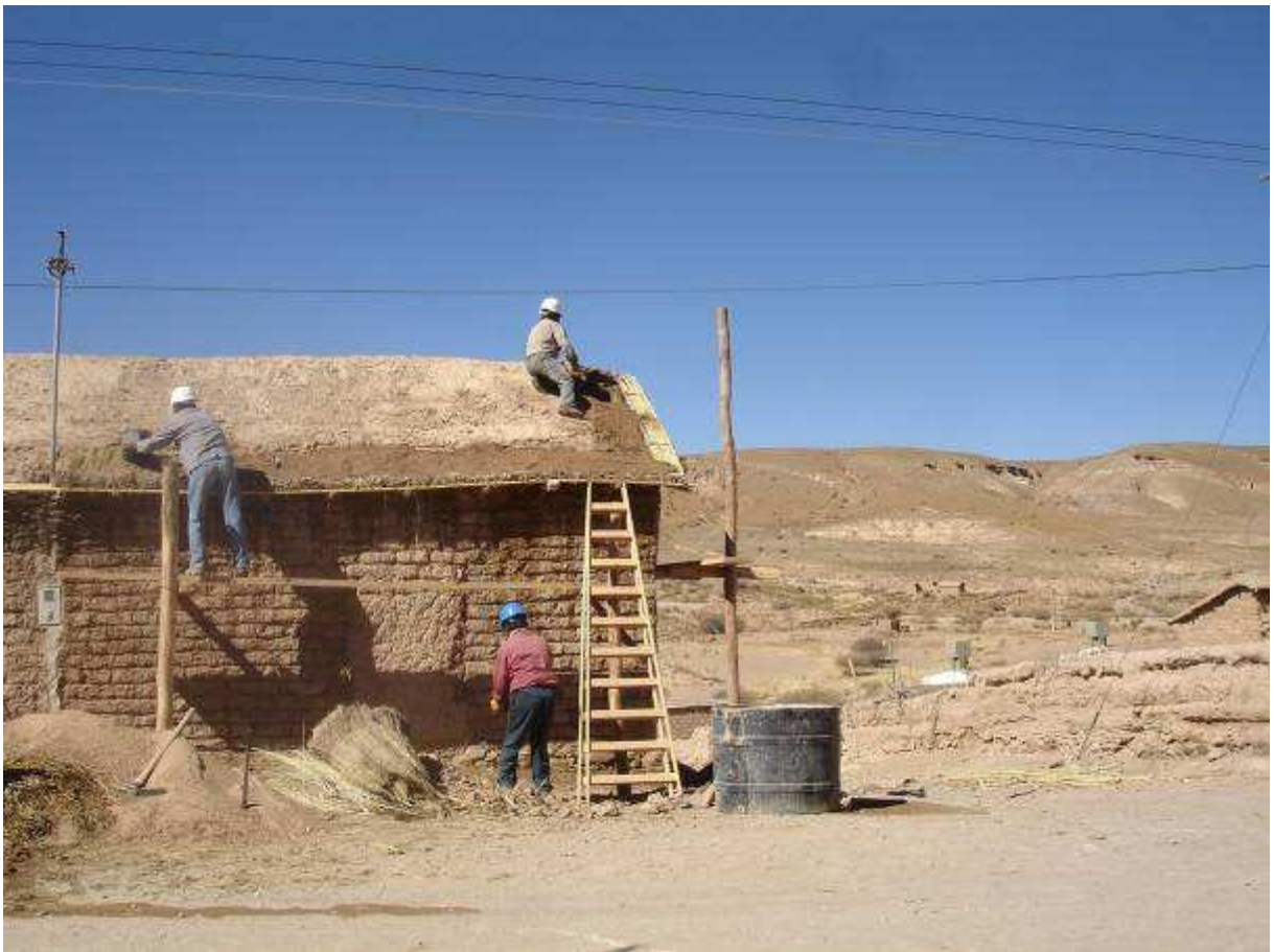
Figura 5. Equipo trabajando en un techo. Uno está colocando guaya en el alero, otro está colocando torta en cumbrera y en alero lateral, el tercer hombre está abajo alcanzando los baldes con torta de barro.
