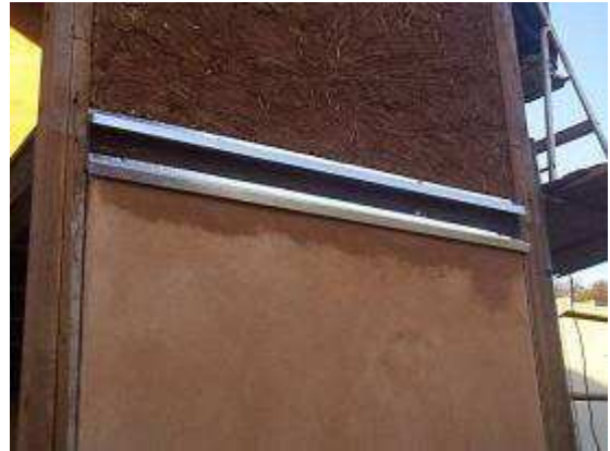
Foto 6 – Barreado sem presença de rachaduras após secagem do barreado.
