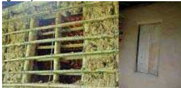
Figura 4 – Aplicação das janelas.
