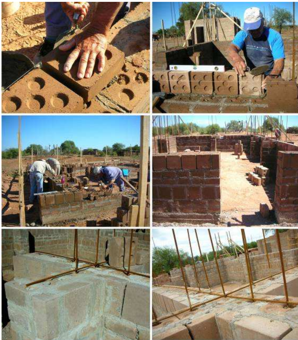
Fig. 5. Arriba: Asiento de mampuestos en soga (Izq.) y en panderete con línea y nivel (Der.). Al medio: Cuatro primeras hiladas asentadas con mortero (Izq.) y vista del muro con seis hiladas (Der.). Abajo: Armadura horizontal a la altura de antepecho de ventana (décima hilada).
