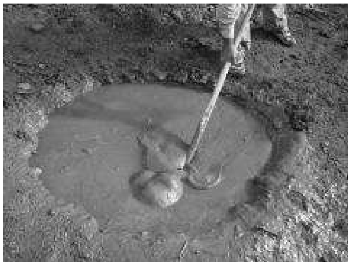
Figura 2, mezclado del barro introduciendo aire (en esta imagen puede observarse la consistencia adecuada para guayar), Rinconada 2008.
