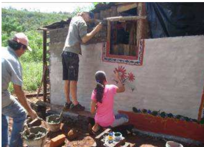
Imag 4. Tarea comunitaria: construcción y pintura
