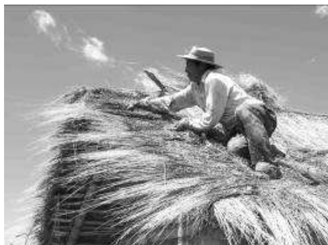
Figura 5, colocación de los aleros laterales, Rinconada 2007.
