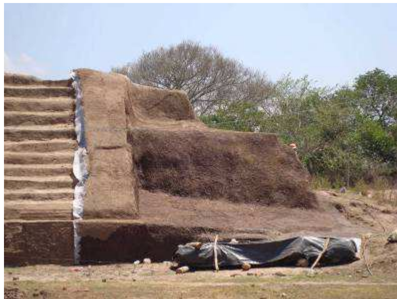
Figura 5. El revoque de sacrificio sobre el geotextil.
