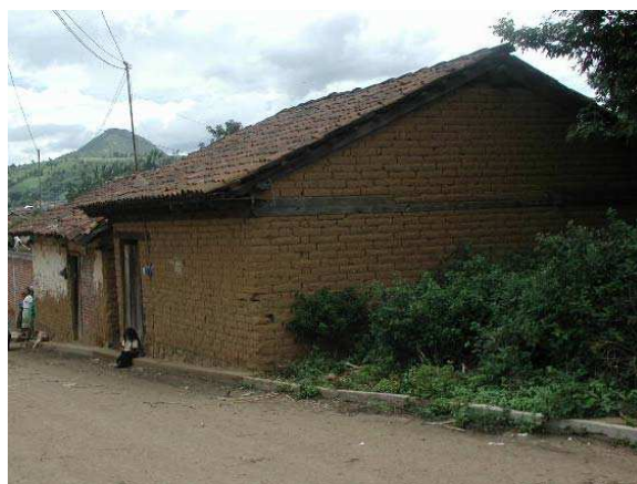
Figura 2. La mayoría de las viviendas tradicionales en la región, se construían a partir de formas geométricas sencillas, por ejemplo una planta rectangular rematada por una cubierta a una o dos aguas, utilizando como materiales los que le proporcionaba la naturaleza, se aprecian los paramentos de los solares dentro de los cuales destaca el predominio del macizo sobre el vano.
