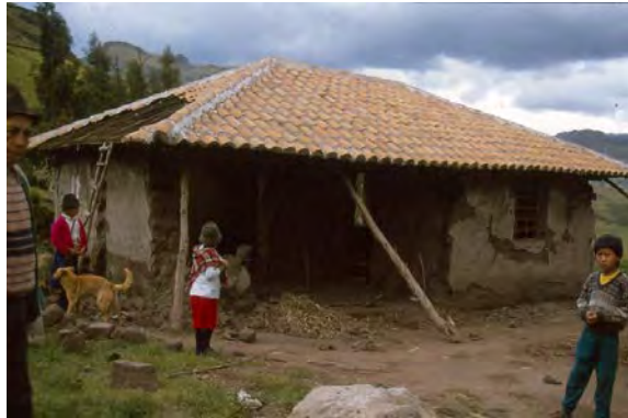
Figura 9 – La falta de vinculación de la solera con el muro libre de adobe, permitió que este se “desprendiera” de la cubierta y colapsara
