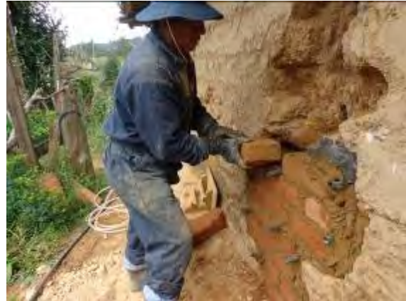
Figura 9. Consolidaciones, cocidos y descocidos de muros
