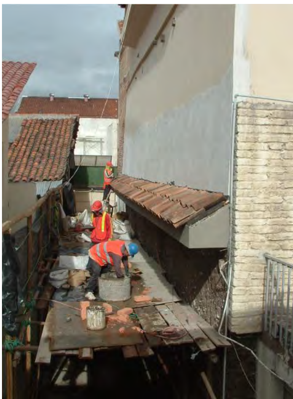
Figura 8. Fabricación de alero a nivel de entrepiso. Crédito: Baquero, 2014
