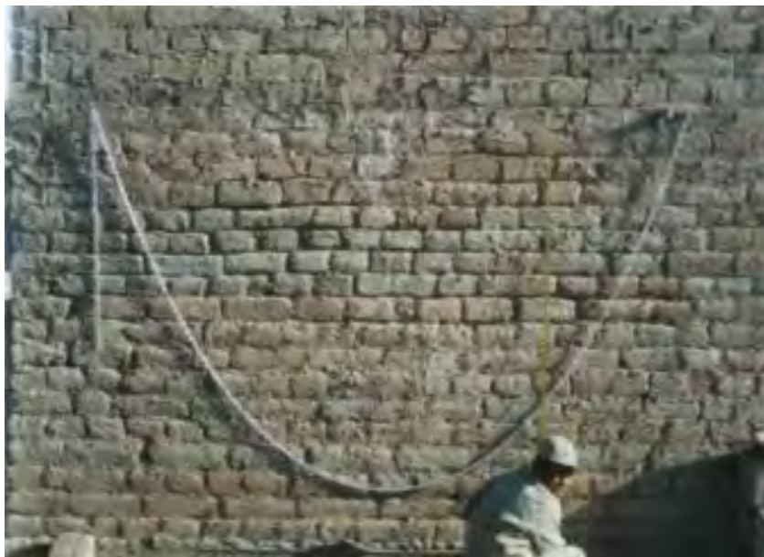
Figura 3. Diseño de curva catenaria, Lahuachaca, Bolivia (Crédito: Jakobsen, 1990)
