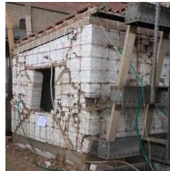
b) Daños en el ambiente de adobe
