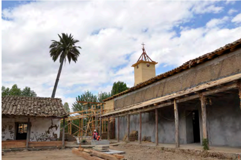
Figura 5. Reparación iglesia San Pedro de Alcántara. Fuente: COTTA Chile.
