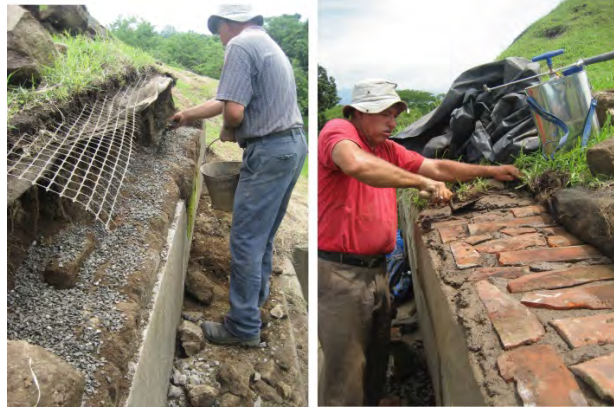
Figura 3 – Uso de pedrín suelto para hacer notar la intervención y uso de teja para cuidar los adobes de la humedad.
