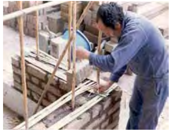
Figura 5. Mejoramiento interno mediante caña de bambú (Blondet et al, 2007)
