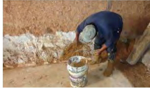
Figura 13. Aplicación de capa de revoque en muro de tapia
