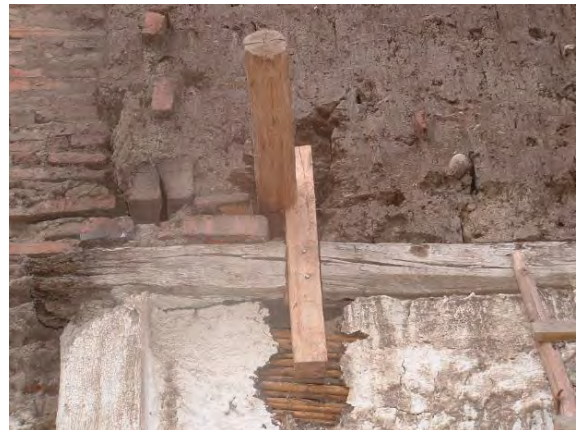
Figura 5. Vigas llaves en la cara exterior del muro de adobe. Crédito: Baquero, 2014
