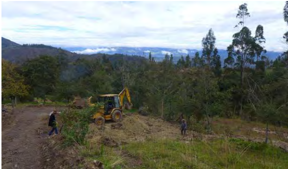
Figura 1. Nivelación del terreno
