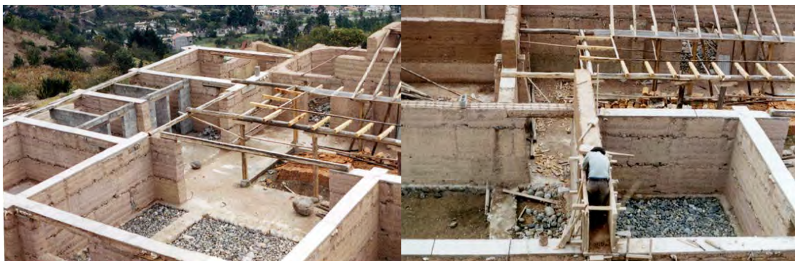
Figura 4. Muros de tapial en construcción
