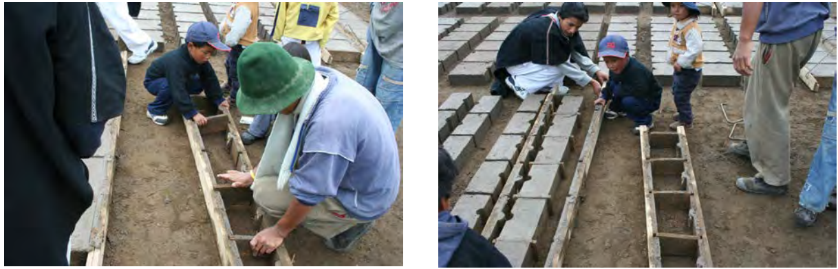
Figura 13 – Elaboración de adobes en una escuela rural
