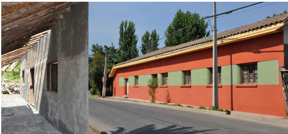
Figura 4. Reparación de viviendas, zona urbana poblado de Coinco, registro 2013
