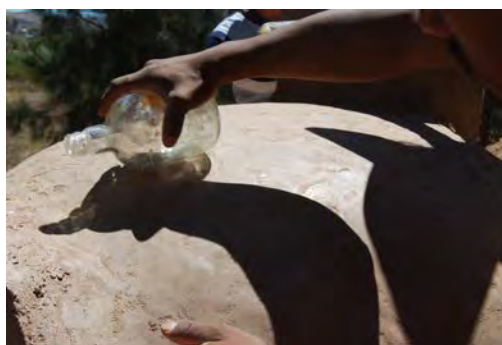
Figura 6. Pulido del enlucido de cal, arena y polvo de ladrillo. (Foto: L. Guerrero, 2015).
