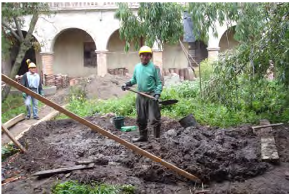
Figura 1. Batido manual de un mortero de tierra
