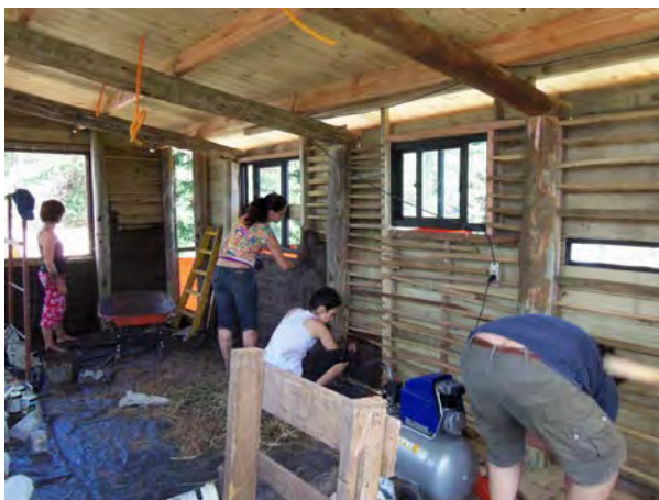
Figura 3. Jornada de embarrado de paneles de fajina
