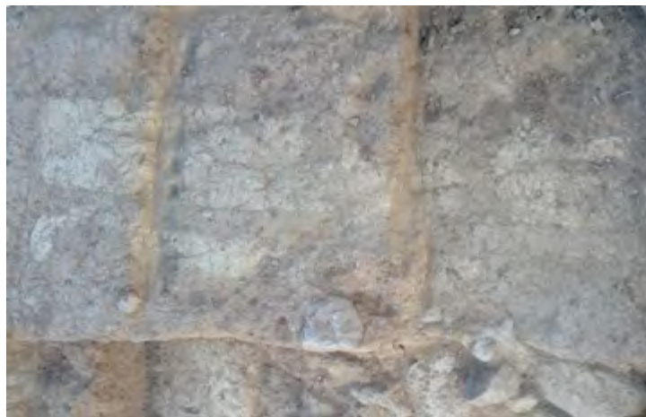
Figura 5. Muro de adobe
