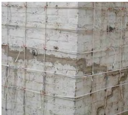
c) Detalle de refuerzo
