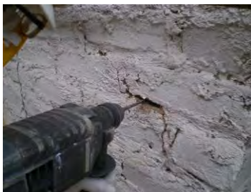
a) Uso de taladro eléctrico
