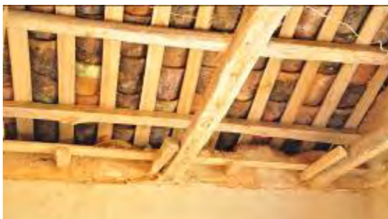
Figura 20. Madera luego de varios días de aplicación de kimocide
