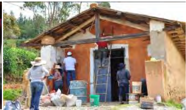
Figura 19. Aplicación de la pintura de tierra en la fachada de la capilla
