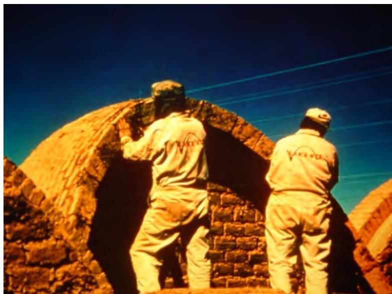
Figura 4. Ejecución bóveda catenaria, Lahuachaca, Bolivia (Crédito: Paz, 1990)
