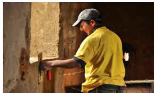
Figura 17. Acabado de filos de ventanas
