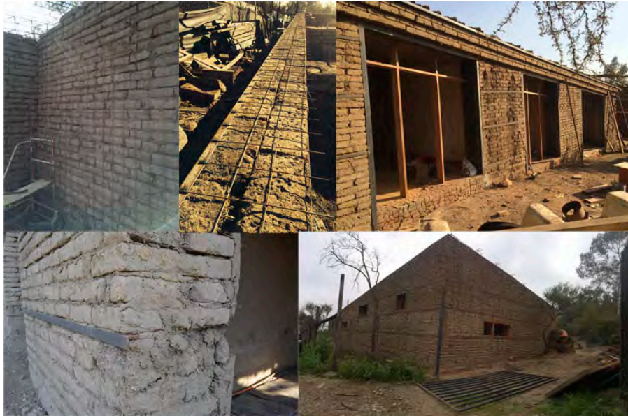
Figura 6. Construcción vivienda de adobe, comunidad ecológica Peñalolén Chile. Registro 2015.
