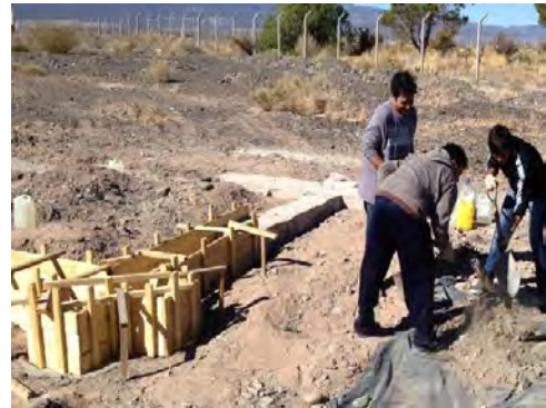
Figura 6. Hormigonado sobrecimiento
