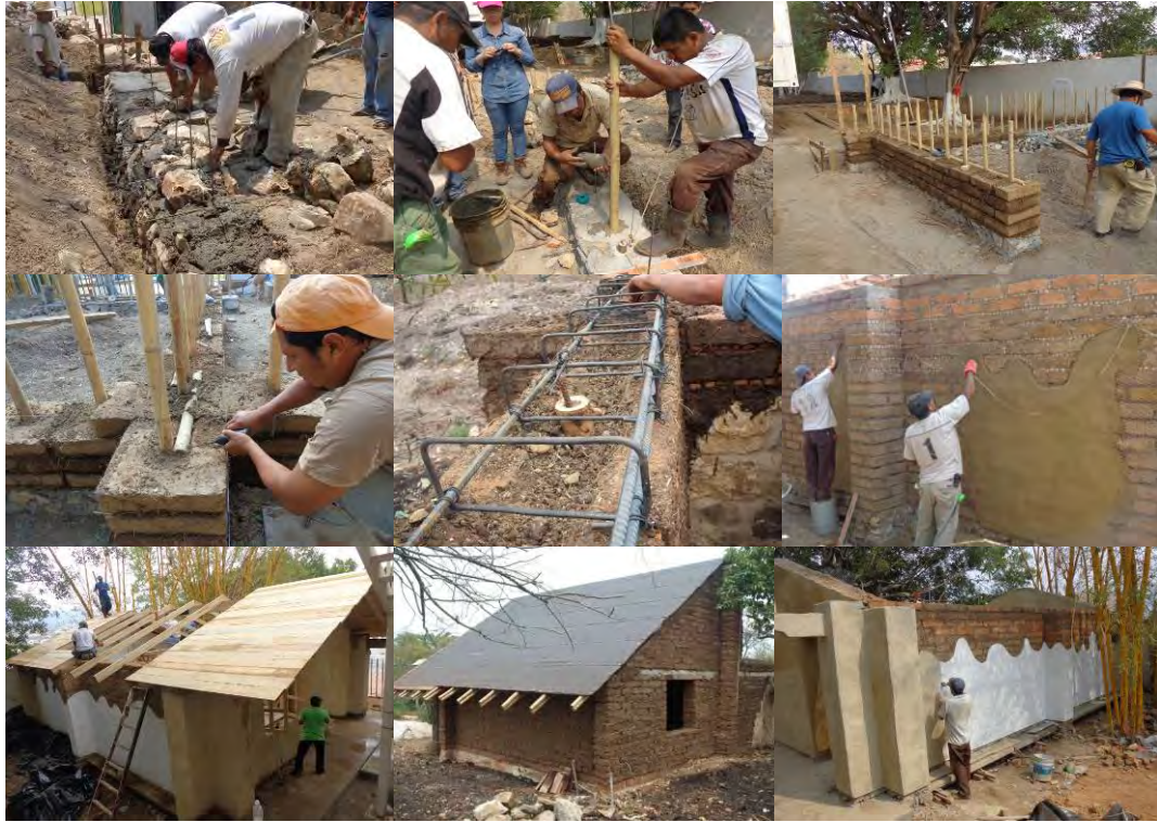
Figura 1- Proceso constructivo del adobe sismo-resistente (S-R)
