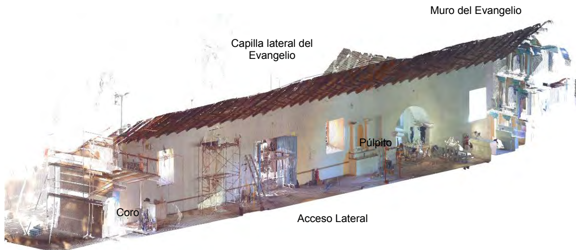
Figura 5. Muestra sección longitudinal interior del muro del Evangelio. (Crédito: Caquisane, 2015)
