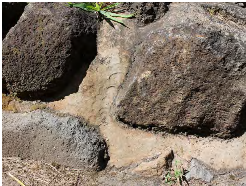
Figura 1. Consolidación del mortero de unión con tierra estabilizada y compactada en Tazumal. Nótese la huella de la herramienta de madera usada para la compactación (Foto L. Guerrero 2014).
