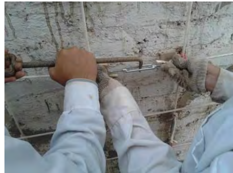
b) Templado de refuerzo horizontal
