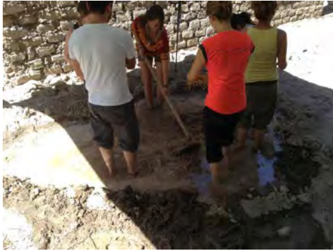
Figura 1. Elaboración de adobes
