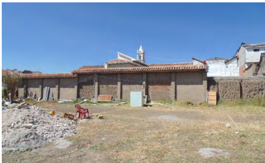
Imagenes 2: Estado actual de sitio para taller de intervención patrimonial Fuente: Arq. Gabriela Barsallo
