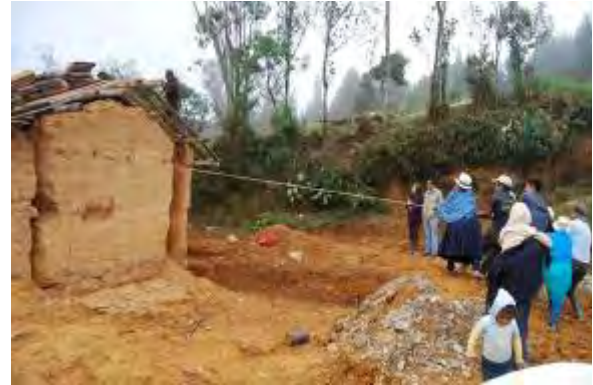
Figura 2. Derrocamiento de muro de tapia para ampliación de capilla
