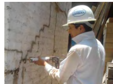
c) Inyección de barro líquido
