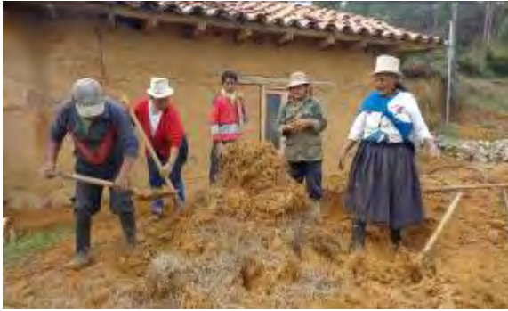
Figura 12. Proceso de elaboración del revoque
