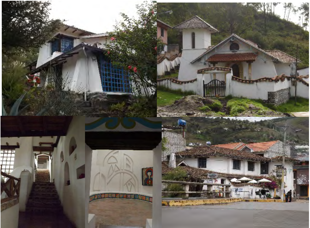
Figura 5. Construcciones de tapial en Paute
