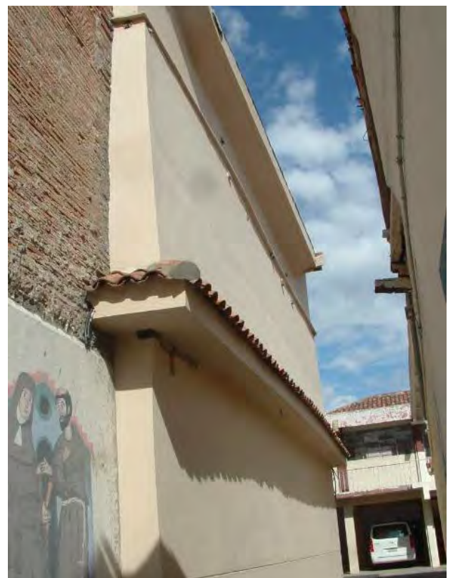
Figura 9. Muro terminado. Crédito: Baquero, 2014
