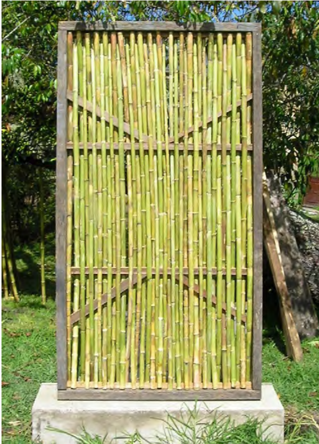
Imagen: Taller de bahareque, muro prefabricado Fuente: Arq. Lucía Garzón
