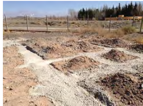
Figura 4. Hormigonado cimiento
