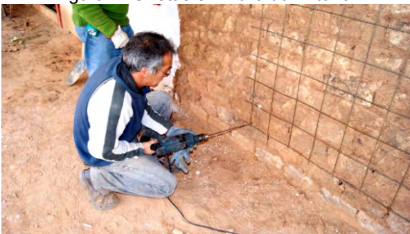
Figura 9. Colocación malla Acma en muro
