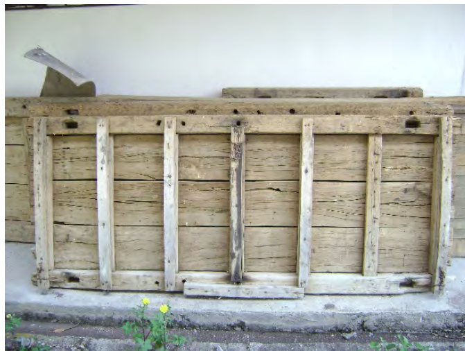
Figura 3. Tablero lateral de tapialera
