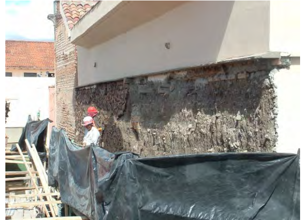
Figura 7. Parte superior del muro finalizada, colocación de cisco de teja. Crédito: Baquero, 2014
