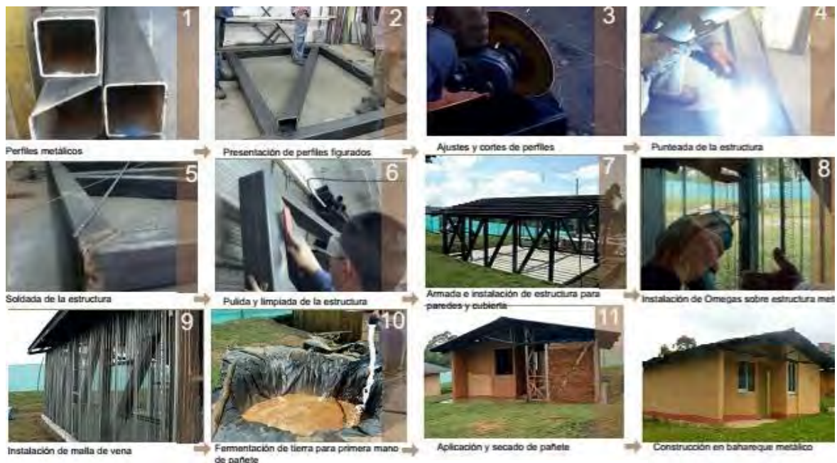
Figura 3. Proceso constructivo bahareque
