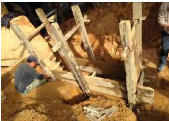
Figura 6. Armado de cajón o encofrado para muros de tapia
