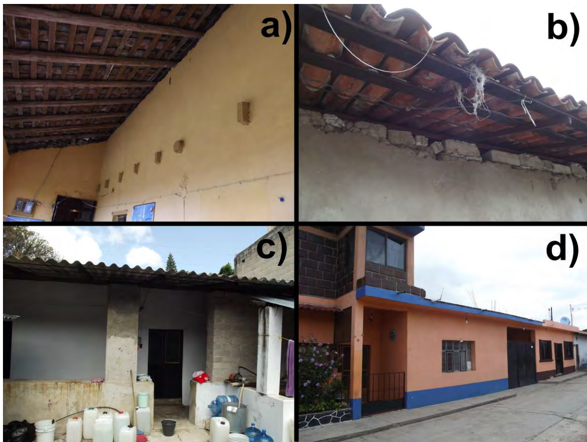
Figura 5. Tipos de techos en las viviendas de adobe de Malinaltenango. a) Tejas con morillos de madera; b) Tejas con estructura mixta de madera y metal; c) Techo de lámina de asbesto sobre estructura de metal; y d) Techo colado.
