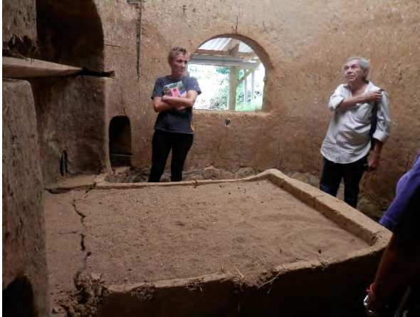
Figuras 1 y 2. Fisuras por asentamiento del suelo. En las ventanas se observa el poco espesor de paredes y la grieta vertical por asentamiento del suelo.
