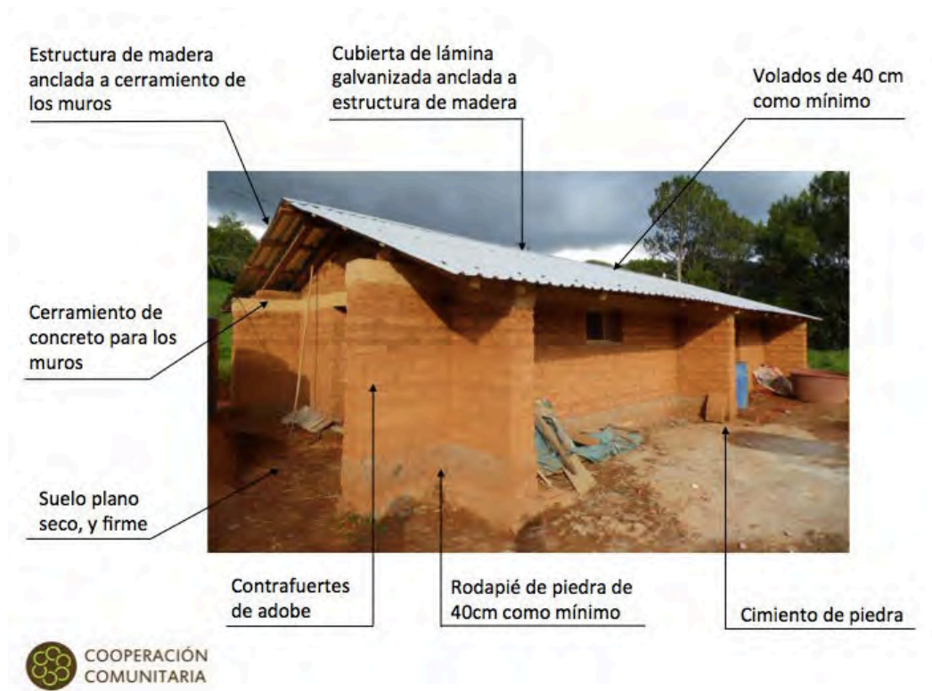
Figura 6. Recuperación de elementos para la correcta técnica constructiva de adobe y elementos de reforzamiento para adaptarla a los fuertes sismos y vientos de la región.
