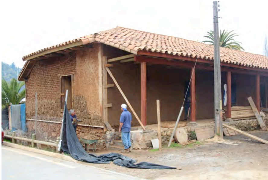
Figura 12- Proceso de reparación de viviendas en la localidad de Vichuquén, zona típica patrimonial de la región del Maule. Crédito: Cristian Muñoz
