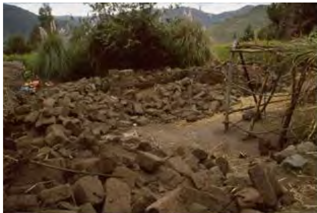
Figura 4 – Construcción literalmente “barrida”, se aprecia que no existen huellas de una posible cimentación
