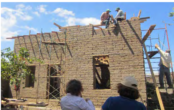
Figuras 5 y 6. Diseñada en 2 plantas, con 40 cm de espesor y múltiples vanos. Delgadas vigas dintel y anillo intermedio.
