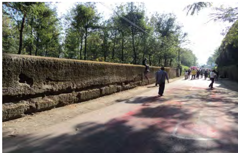
Figura 4. Muros lindero contruidos de tierra compactada en Antigua Guatemala (Quiñónez, 2015).
