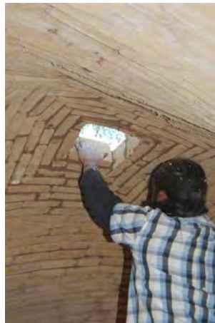
Figura 2. Cierre de una bóveda de adobe y mortero de barro con cal (Foto: L. Guerrero, 2015).
