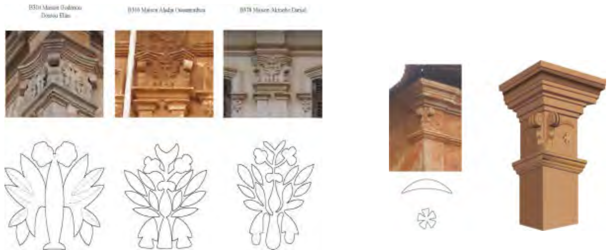
Figura 3: Detalhes dos padrões decorativos em argamassa das fachadas das residências agudás (Crédito: Kiki Gbénahou, 2012)
