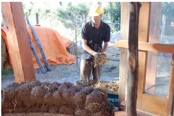
Figura 4. Montaje paredes exteriores en cob, barrio Carrasco, Montevideo
