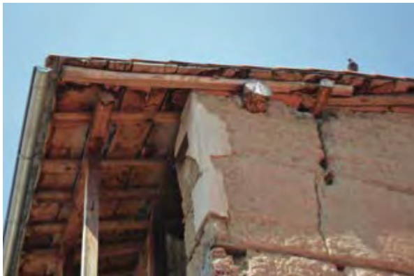
Figura 12. Tapia con elementos horizontales en madera del Caso de Estudio 8
