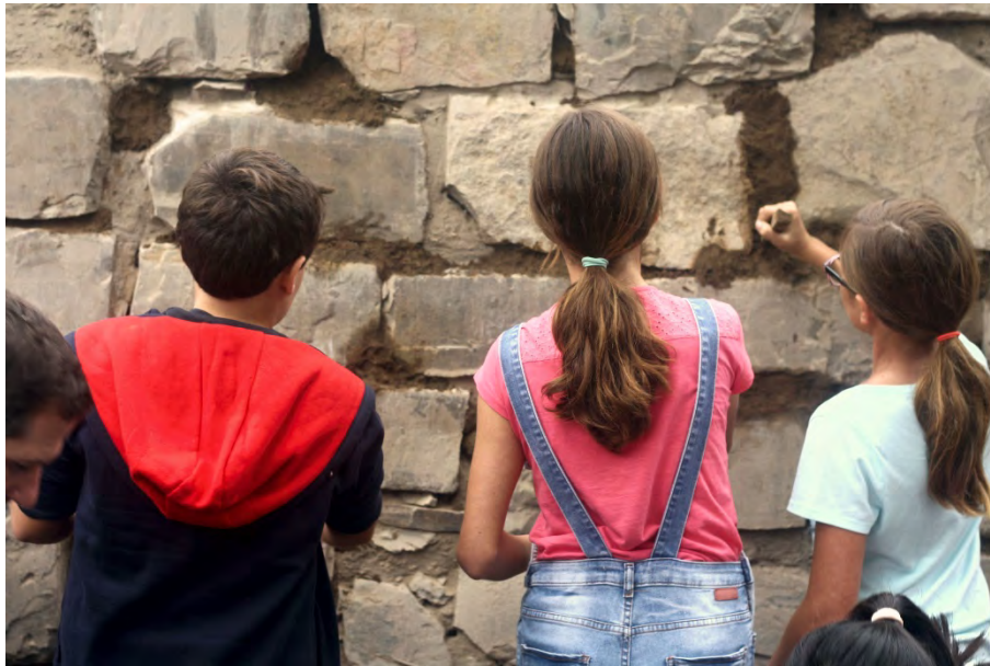
Figura 6 – Niños colaborando en el emboquillado con barro en un muro de prueba del Santuario
