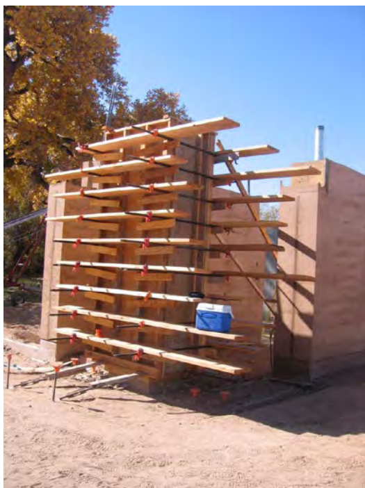
Figura 5. Sistema de encofrado para muros de tapial en la Casa Downey
