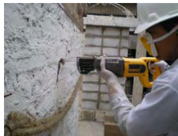
b) Uso de cuchillo eléctrico
