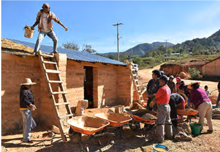
Figura 11. Taller práctico de autoproducción en adobe reforzado para construir la casa del pueblo, comunidad El Obispo, Malinaltepec, Gro.
