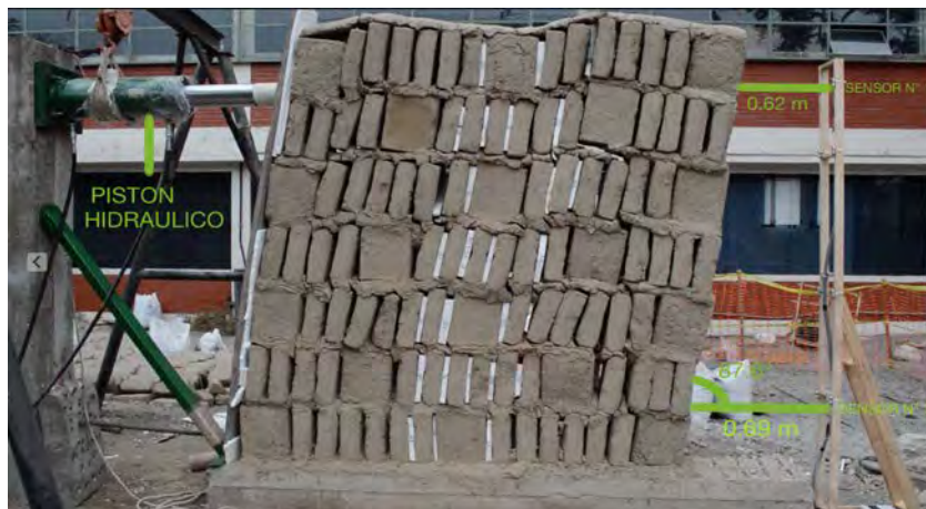
Figura 4. Falla del muro de adobe en aparejo de librero (Crédito: CECOS-BRIGURP, 2015)
