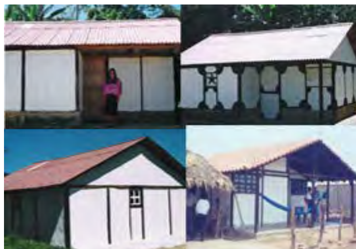
Figura 4a – Diversas obras concluidas con el sistema de bajareque mejorado (continúa)
