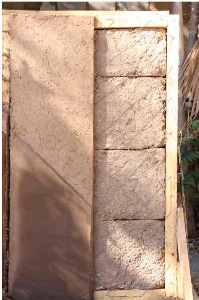
Figura 5- Maqueta a escala real de técnica constructiva del “adobe en pandereta” 3 . Crédito: Matías Valenzuela
