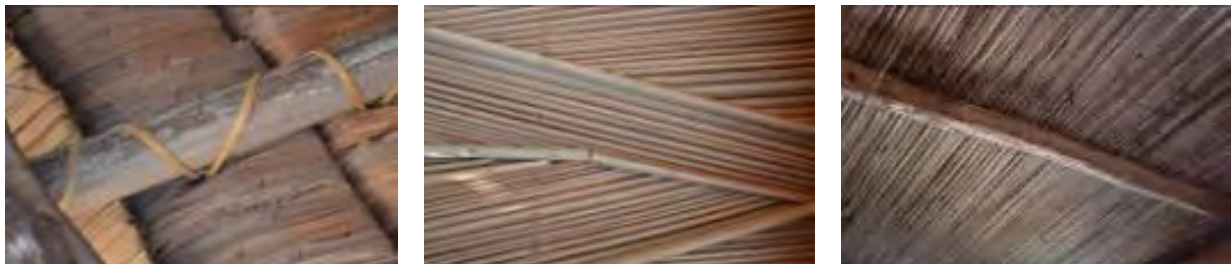
Figura 4: Exemplares de forros em bambu em Porto Novo, Ganvié e Adjarra (Créditos: Alexandre Mascarenhas, 2012)
