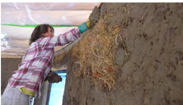
Figura 3. Primera capa de mortero de tierra. Crédito: Bowman
