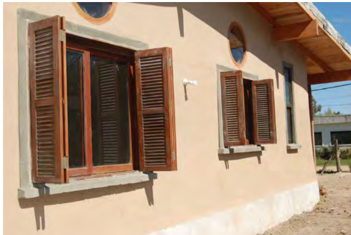
Figura 9. Cob en pared exterior al norte
