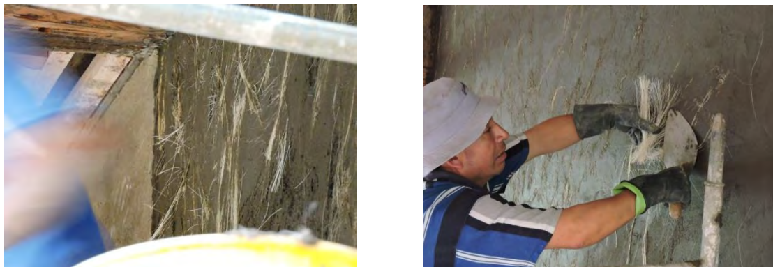
Figura 3. Aplicación de la segunda capa de “cabuya peinada” en un muro de adobe
