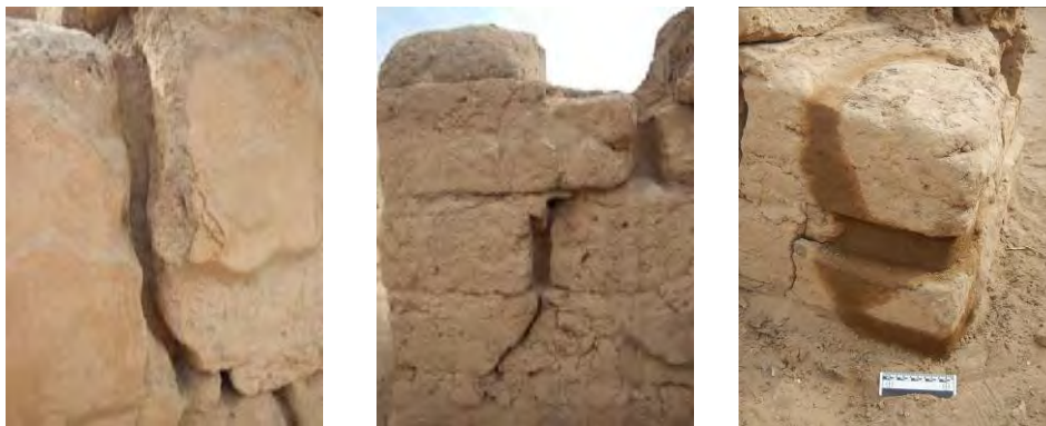
Figura 8 – Resultados de la inyección de barro líquido en muros de adobe
