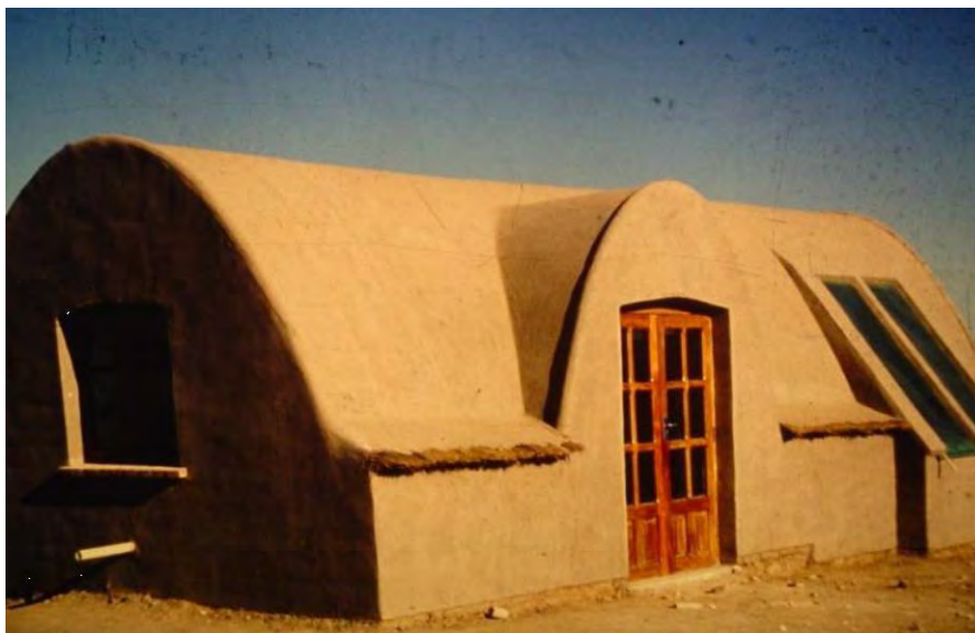
Figura 5. Vivienda rural de autoconstrucción con muro trombé , Lahuachaca, Bolivia (Crédito: Jakobsen, 1994)
