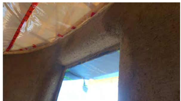
Figura 4. Segunda capa de mortero de tierra
