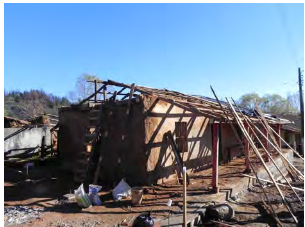
Figura 6. Desarme de vivienda
