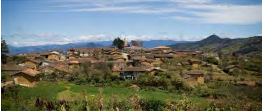
Figura 5. Conjunto arquitectónico y contexto natural de la parroquia Chuquiribamba (INPC, 2012).
