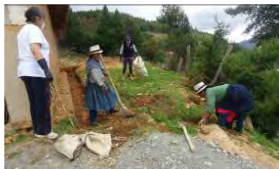
Figura 11. Limpieza y mantenimiento de zanjas
