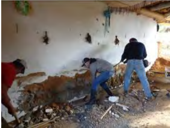
Figura 8. Liberación del revestimiento de cemento de los muros de tapia
