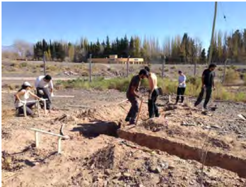
Figura 3. Excavación de zanjas
