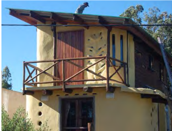
Figura 1. Revoque de cal sobre la pared de tierra en balneario Playa Verde, Maldonado, Uruguay
