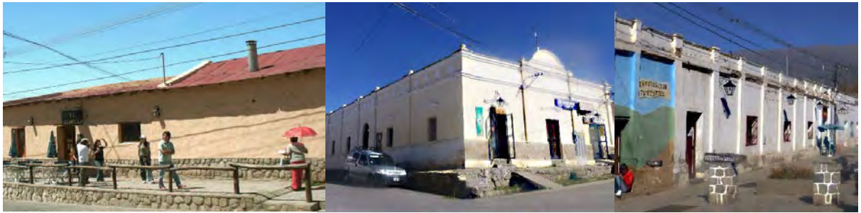
Figura 2. Fachadas del casco fundacional
