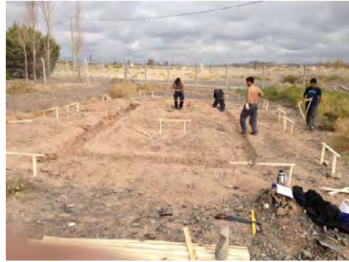
Figura 2. Replanteo de la obra
