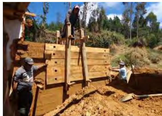
Figura 7. Desplazamiento horizontal del cajón para el armado del muro de Tapia
