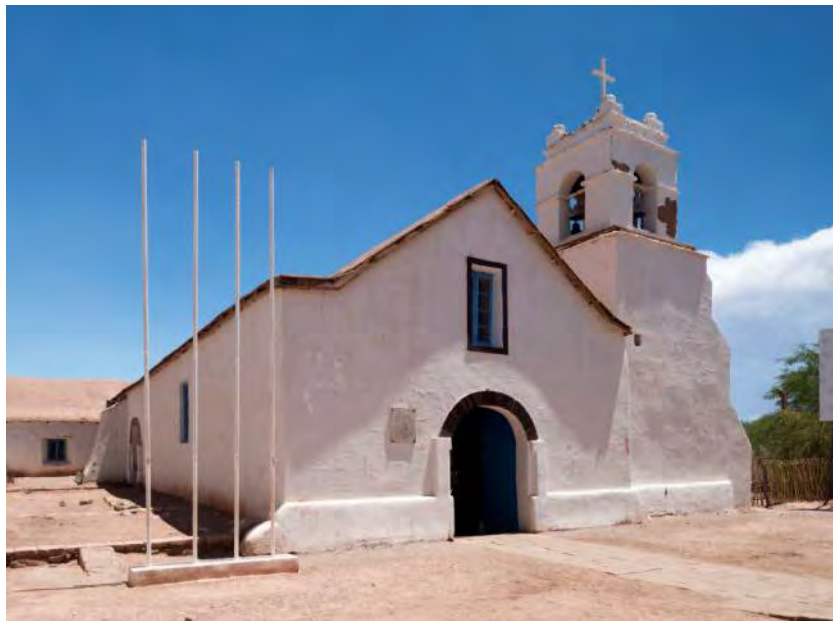
Figura 1. Iglesia San Pedro de Atacama (Cristóbal Correa, 2014)
