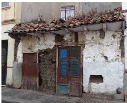
Figura 4 – Muro 3 de carga: Barrio de El Vado, calle Juan Montalvo No. 6-32
