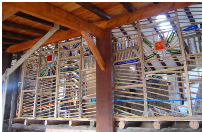
Figura 10. Paneles de fajina al interior, entramado simple
