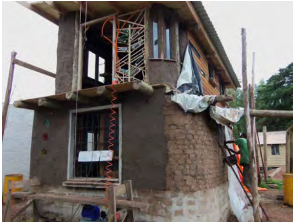
Figura 2. Revoque de arcilla sobre adobe. Zócalo de BTC
