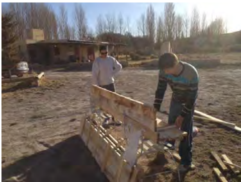
Figura 5. Armado de encofrado
