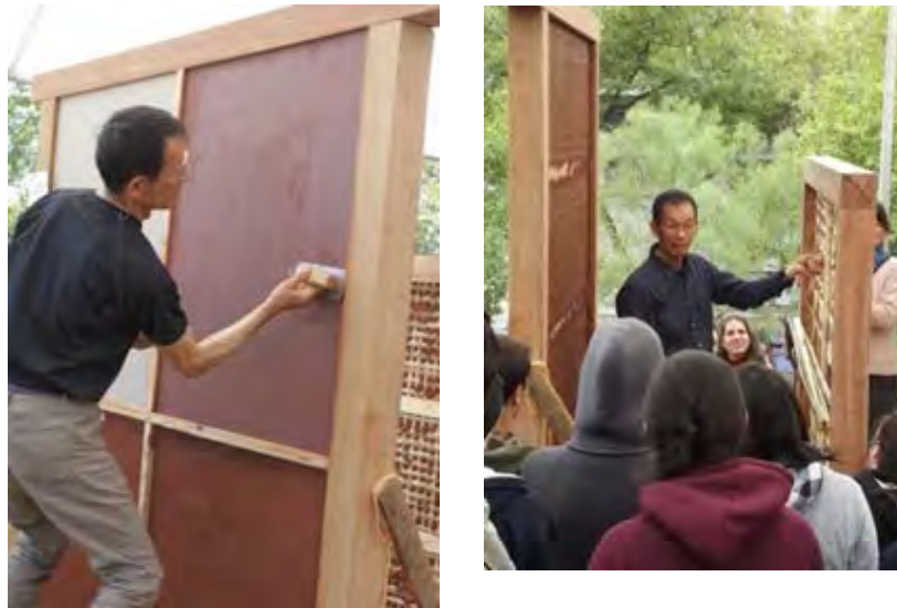
Figura 6: Demonstração de aplicação da camada final e fixação da trama de bambu. Credito: Yoneda, 2013
