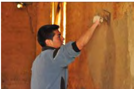
Figura 16. Jóvenes del barrio aprenden la técnica del empañetado
