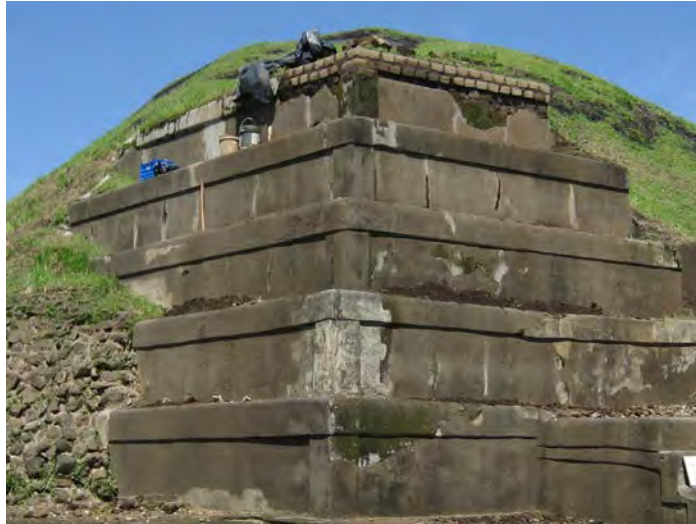
Figura 3. Colocación de adobes para restituir la cornisa (Foto O. Camacho 2013).
