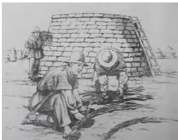
Figura 6— Al llegar a una altura de 1,20 m del nivel de la plataforma, se coloca un dintel de madera de cactus, para cerrar el espacio que albergara la puerta
