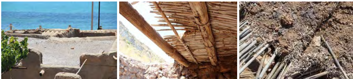
Figura 5. Imagen de una terraza de tierra de láguena en La Azohía (derecha) y del detalle tanto interior como exterior de su composición (central e izquierda) (fotos V. La Spina).
