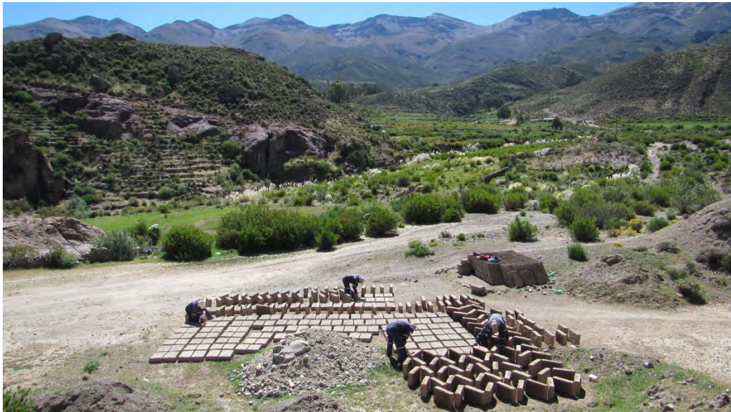
Figura 6. Secado de adobes fabricados
