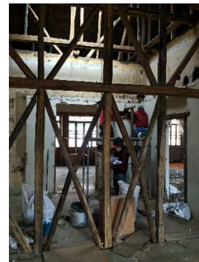
Figura 7. Casa Carvalho, conservación total. Restitución de las paredes de bahareque
