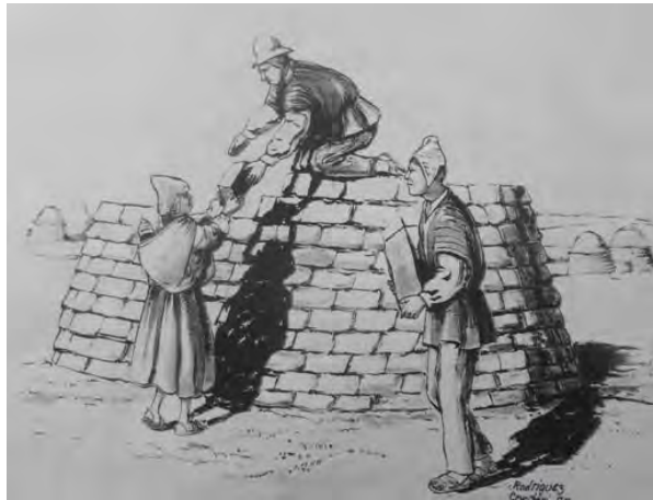
Figura 5— Se van colocando los tepes con el pasto hacia abajo y las raíces hacia arriba, para conseguir una buena adherencia. Esta vivienda no posee cimientos
