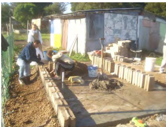
Figura 3. Inicio de la construcción de muros de BTC sobre platea de hormigón.
