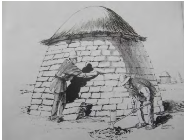
Figura 11 – Finalmente se coloca la paja brava encima de la wara, a su vez la paja se sujeta con una chipa red trenzada, para finalmente estucarse por dentro
