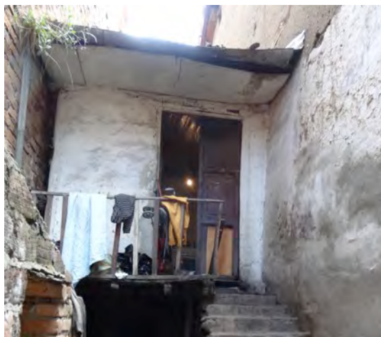
Figura 6. Deformación de las piezas de madera en cubierta y piso en la segunda crujía de la edificación 008. Fuente: Proyecto vlirCPM.
