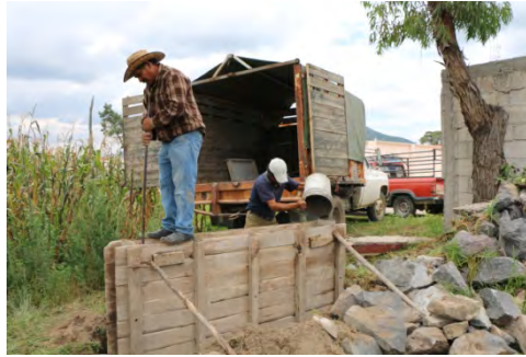
Figura 6. Procedimiento constructivo, encofrado de madera y apisonado
