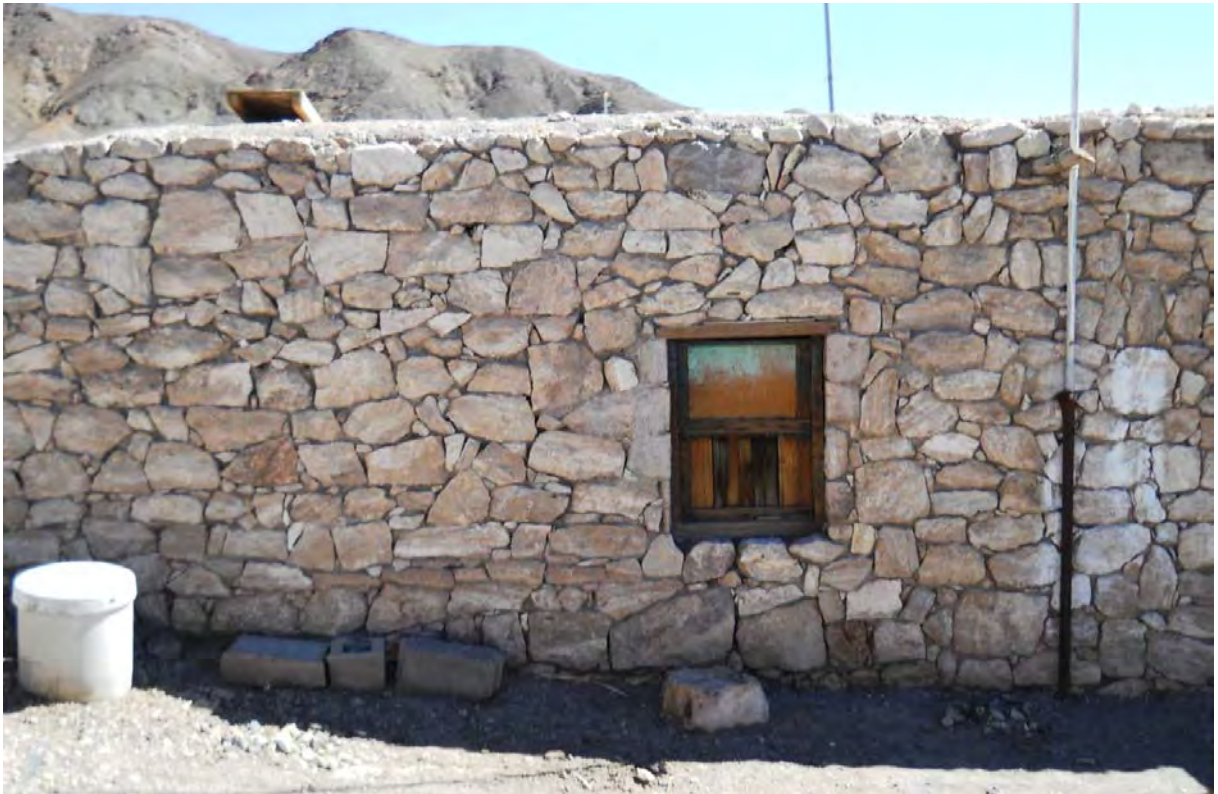
Figura 5. Mampostería de piedra, localidad de Peine
