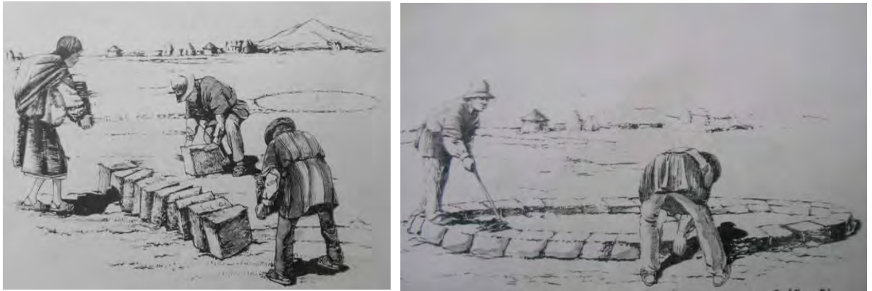
Figura 4— Seguidamente se crea una plataforma de 0,30 m de alto para evitar el ingreso de agua a la vivienda
