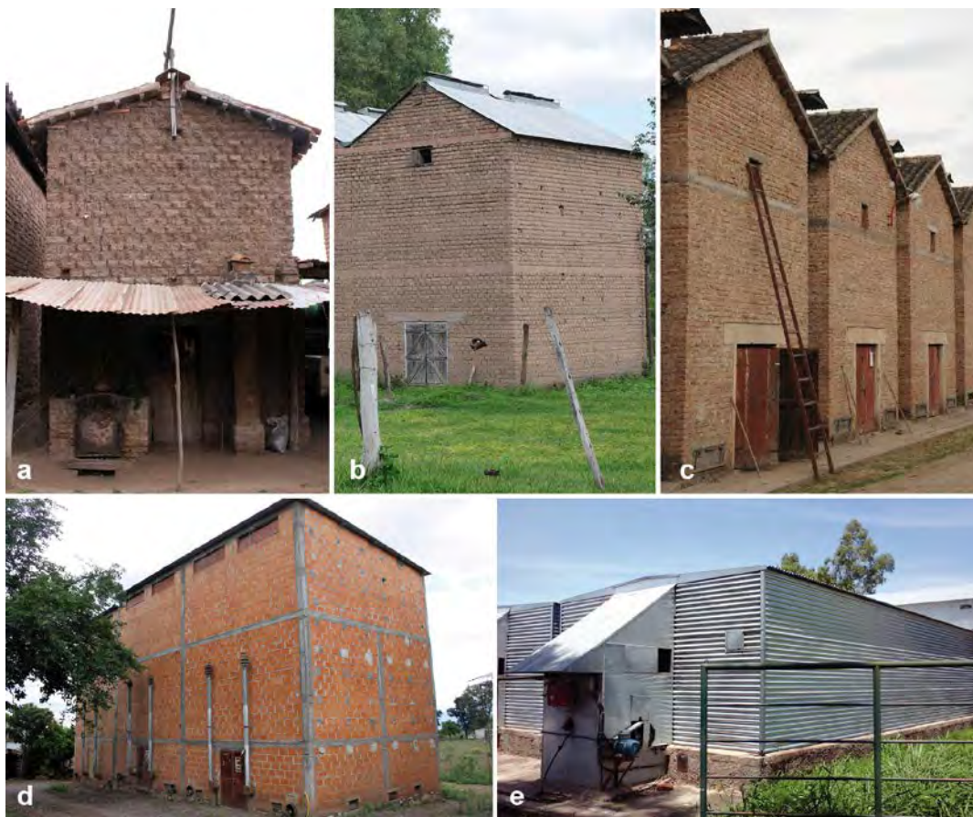
Figura 1. Tipos de estufas: a) Convencional de mampostería de adobe sin refuerzos; b) Convencional de mampostería de adobe con refuerzos; c) Convencional de mampostería de ladrillo cerámico macizo; d) Convencional de mampostería de ladrillo cerámico hueco; e) Bulk curing . Fuente: Elaboración propia
