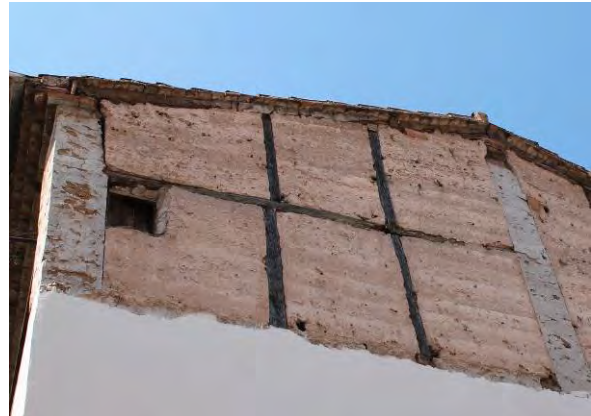
Figura 4. Entramado con paños de “tapialete” y reforzado con pilares de yeso
