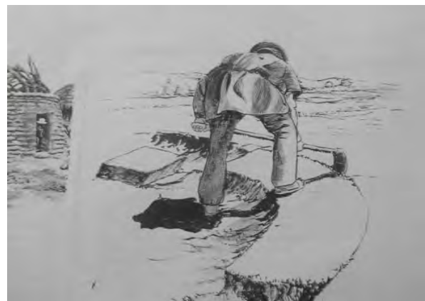
Figura 3—Se traza inicialmente un círculo de aproximadamente 2,40 m de radio externo
