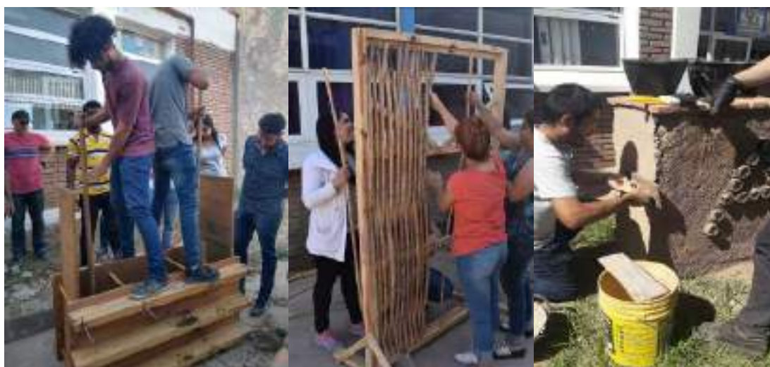
Figura 3. Taller de tapial, taller de quinchá, taller de revoques y revestimientos, materia construcciones con tierra, carrera de arquitectura, UNLaR (Crédito: E.E. Brizuela)
