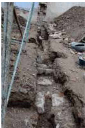
Figura 9. Piso y cimiento original
