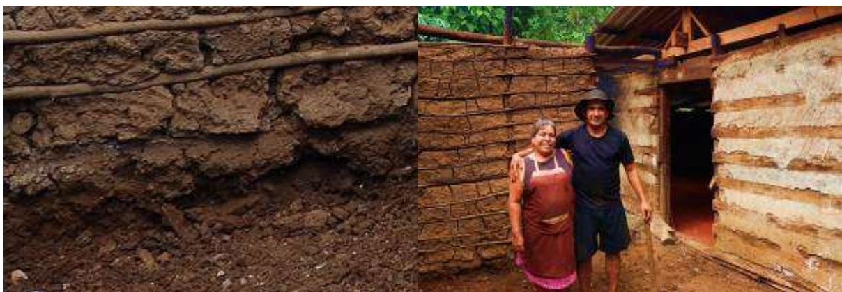
Figura 2. Izquierda: Base de pared de bahareque; derecha: Para el envarillado también se han encontrado prácticas de utilización de tablas de madera aserrada (crédito: T. Juárez – FUNDASAL)
