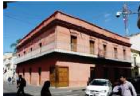
Figura 7. Fachadas, después de la intervención
