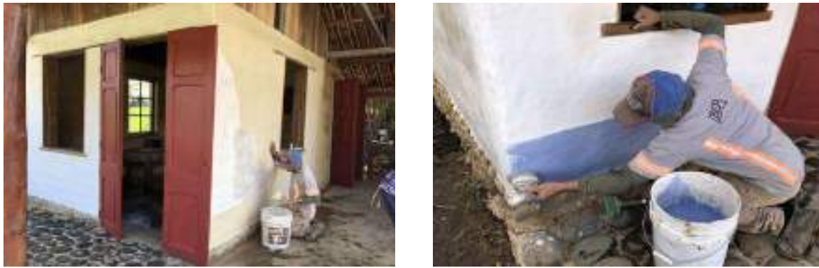
Figura 8. Proceso de encalado luego del secado del revoco final y franja tradicional con pintura de cal
