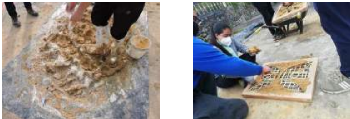
Figura 4. Preparación y colocación del barro (crédito: M. Pesantes 2021)
