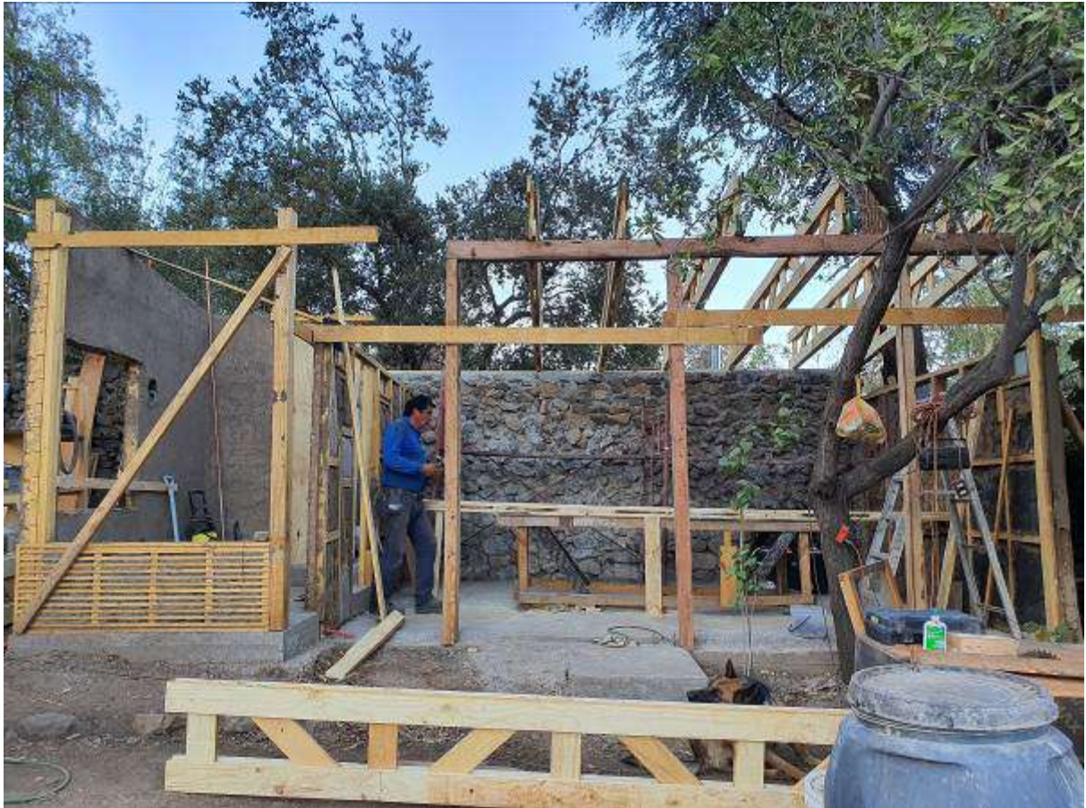
Figura 6. Armado de la nueva fachada norte y nueva cubierta con cerchas prefabricadas en obra con maderas recicladas de la cubierta anterior
