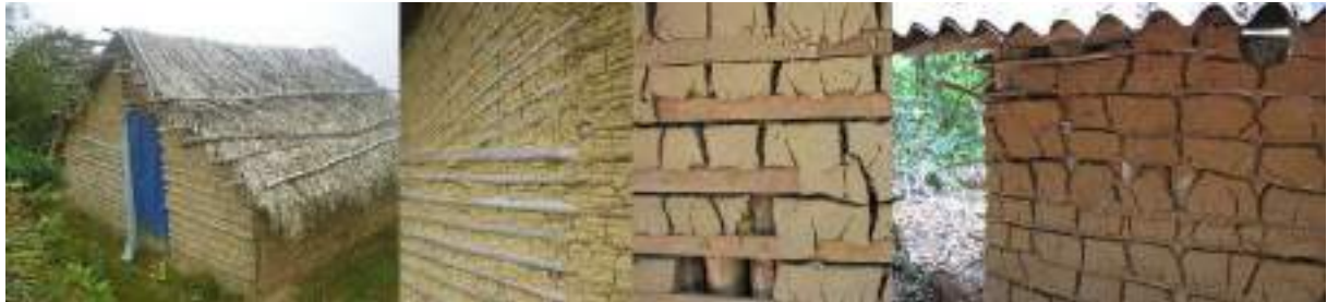
Figura 10. Estrutura terciária de takuara fixa com pregos, de ripas, e de jovens cafeeiros com arame
