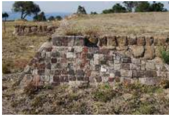
Figura 4. Se puede observar el núcleo de los basamentos y el recubrimiento con piedra careada en las plataformas y taludes de Xochitécatl (crédito: L. Guerrero, 2020)
