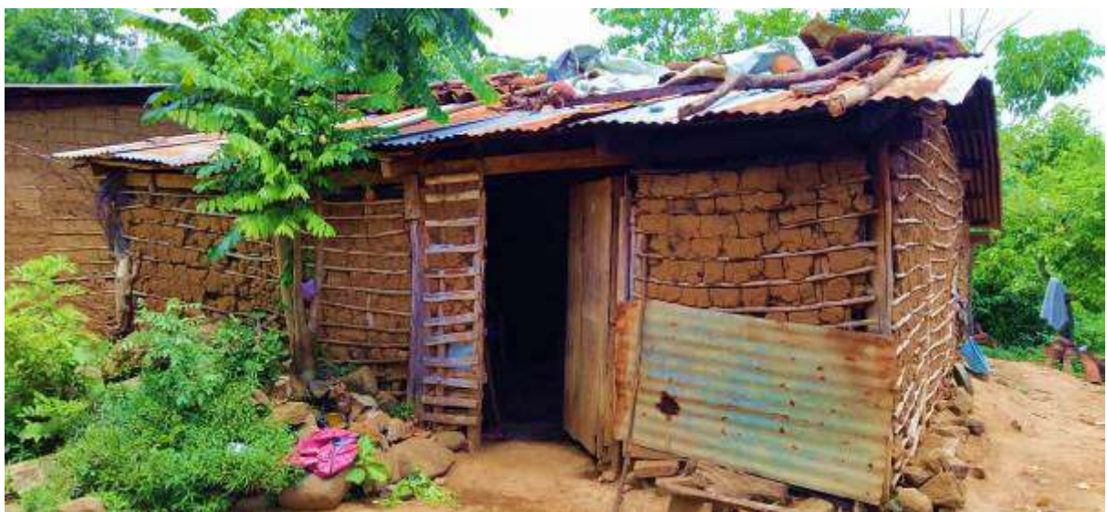
Figura 4. Antes, vivienda de Bersaides Ramírez. Sistema bahareque tradicional identificado en Potrerillos (crédito: T. Juárez - FUNDASAL)
