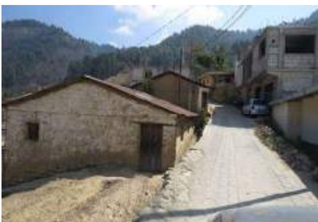
Fig. 2. Viviendas de adobe y block de concreto en la comunidad de Paxtocá, Totonicapán, Guatemala. Fuente: Méndez, 2020.
