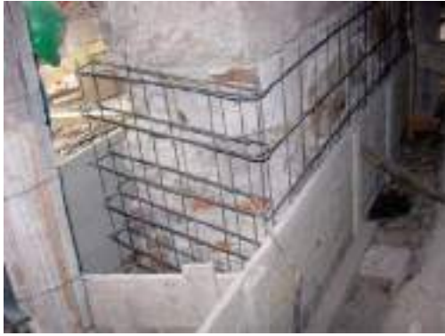
Figura 4. Refuerzos de sobrecimientos
