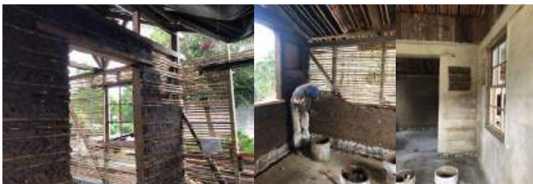
Figura 6. Proceso de estructura horizontal en caña de castilla y relleno de barro con pasto y trozos de teja
