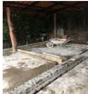
Figura 4. Trazado y cimentación de la casa de bahareque sobre contrapiso de rancho existente
