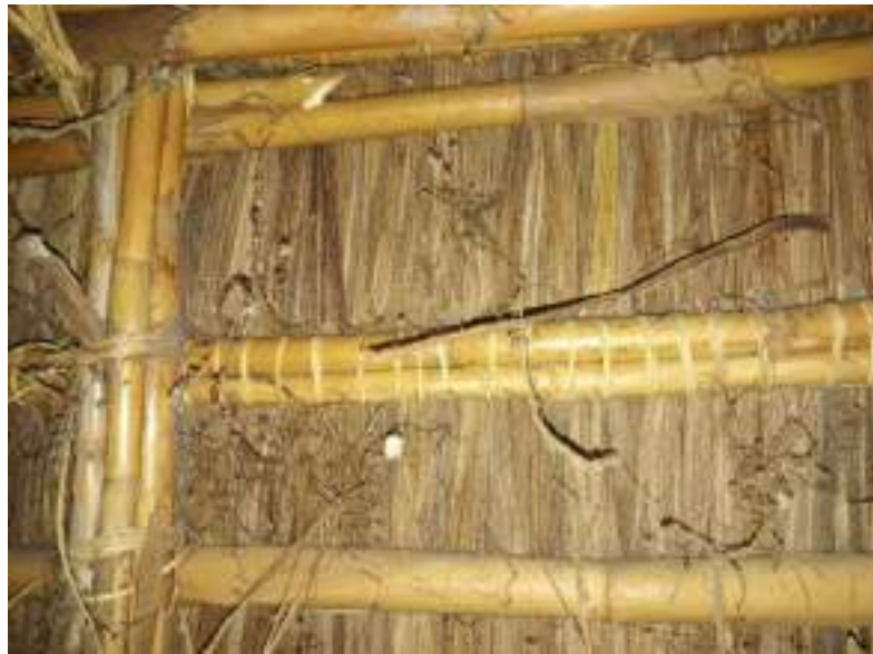
Figura 6. Detalle de la palma y las varas de otate y carrizo del armazón del “techo de oreja” de la construcción vernácula de San Jerónimo Xayacatlán (crédito: Alejandro Pantaleón Calixto, 2020)
