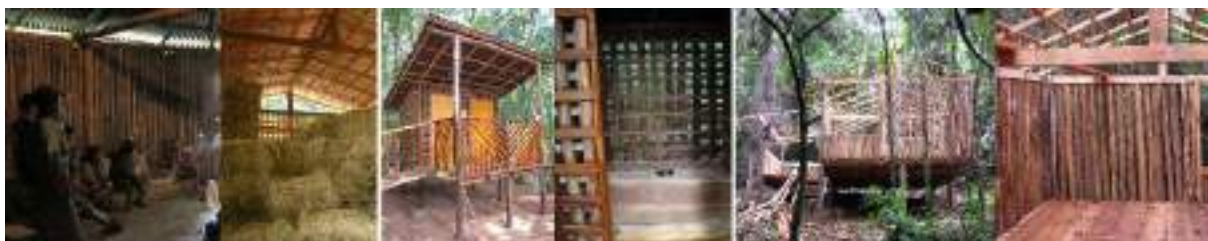
Figura 8. Reprodução do banheiro seco e alteração do espaçamento da estrutura secundária para a aplicação do barreamento com feno, Tekoa Yvy Porã, 2021 (fotos da autora)
