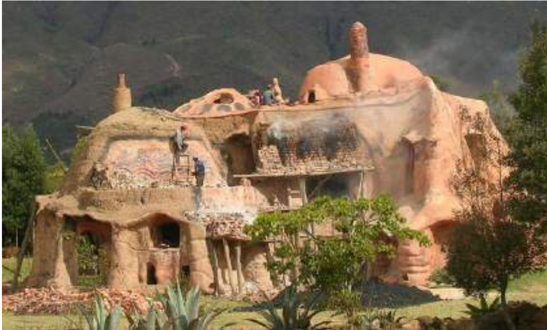
Figura 2. Proceso de cocción in situ de la casa terracota (Baraya 2019)
