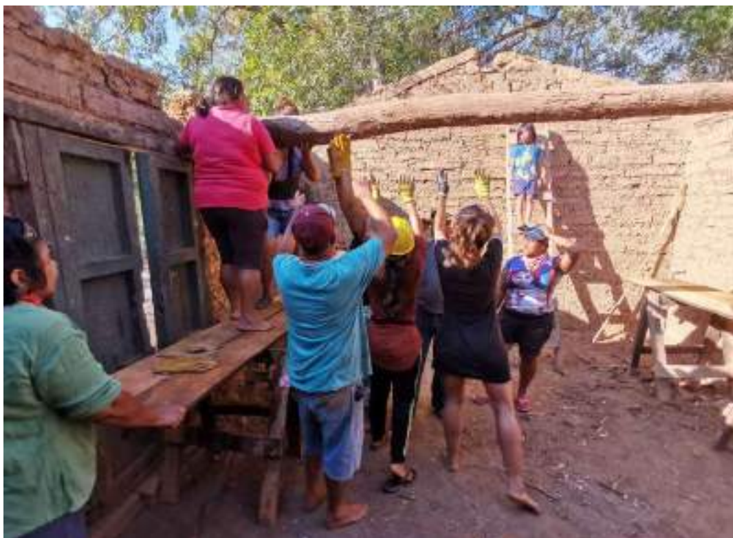
Figura 5. Organización de las mujeres integrantes de las familias, la Colectiva y voluntarias para la liberación del tirante inferior de la estructura de madera de la cubierta de una vivienda tradicional de adobe (Crédito: Colectiva Bioreconstruye, 2021)
