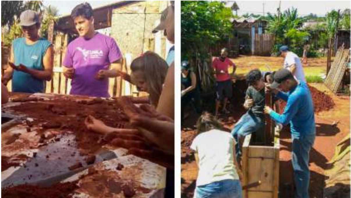
Figura 3. Etapas del curso: reconocimiento del suelo y compactación de la técnica de tapia.
