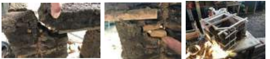
Fig. 7-9. Daños y procesos de intervención. Fuente: propia.
