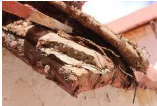
Figura 6. Cateo realizado sobre la torta de barro en el estado encontrado al inicio de los trabajos
