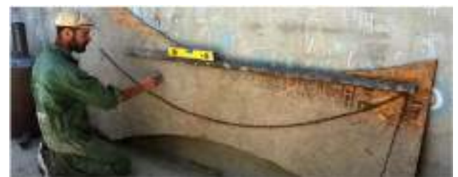
Figura 9. Estudio de la curvatura del arco de catenaria como generatriz de las bóvedas | Fuente: "Debarro Arquitectura"
