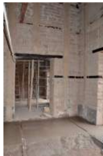
Figura 11. Traba de madera y refuerzos de sogas
