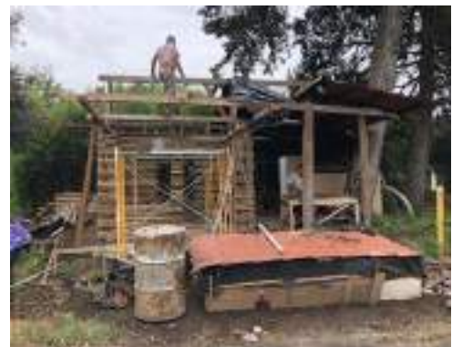
Figura 5. Levantamiento de estructura primaria en madera reciclada
