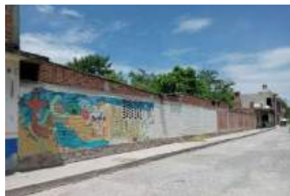
Figura 12. Muro en Xoxocotla.
