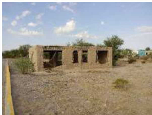
Figura 1. Deterioro y abandono de la vivienda construida con adobe en el contexto rural de Torreón, Coahuila (crédito: A. J. González)
