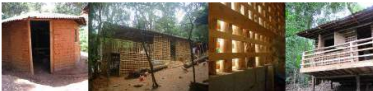
Figura 9. Detalhes de inovação para as bases de parede, com bloco de cimento ou elevando a construção, Tekoa Yvy Porã, 2021
