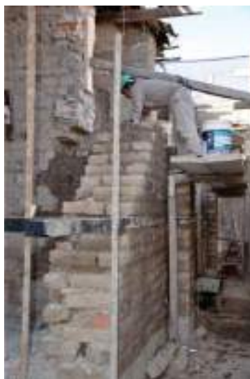
Figura 10. Restitución de muro
