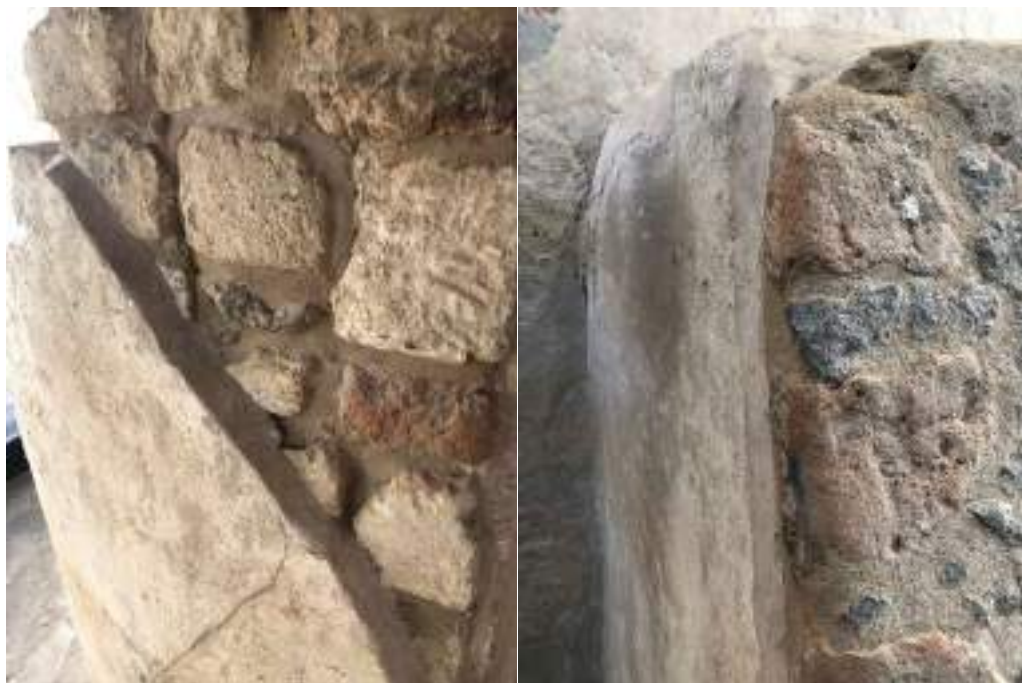
Figura 7. Columnas y altares fueron contruidos con pequeños bloques de tepetate y revocados con una capa gruesa de enlucido de cal y arena (crédito: E. Avila, 2019)
