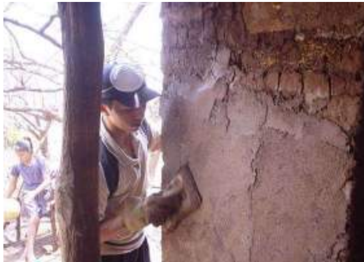
Figura 3. Prueba de mezclas para revestimiento en laboratorio del CII
