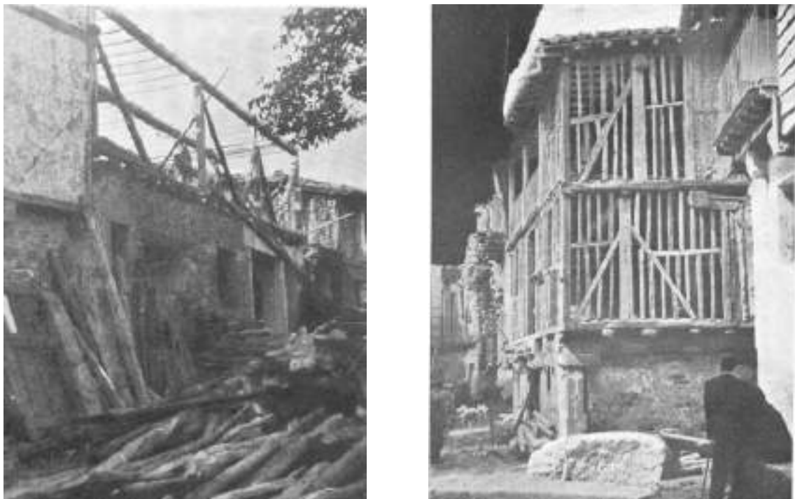
Figura 8. Construcción de entramados en La Alberca, Salamanca. (González Iglesias, 1945, p. 119)
