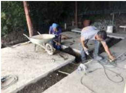
Figura 4. Trazado y cimentación de la casa de bahareque sobre contrapiso de rancho existente
