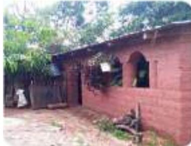
Fig. 1. Vivienda construida con la técnica del adobe. Zacatzonapa, Guerrero, México. 2020.
