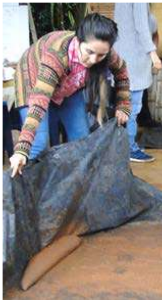
Figura 4. Mezcla mediante el método del burrito, realizado en la sede Taller. Experiencia Taller 2018
