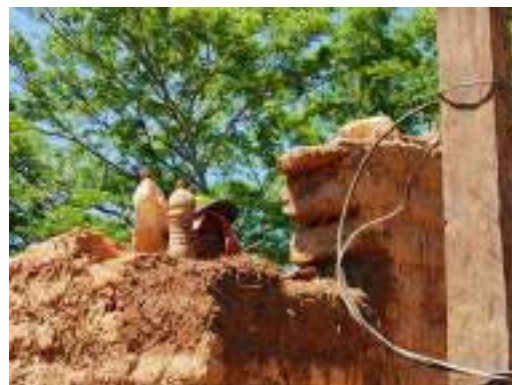
Figura 4. Consolidación de sección de muro de adobe de vivienda tradicional con cob (Crédito:Colectiva Bioreconstruye, 2021)
