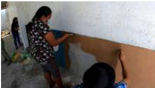
Figura 7. Aplicación de pintura a la cal
