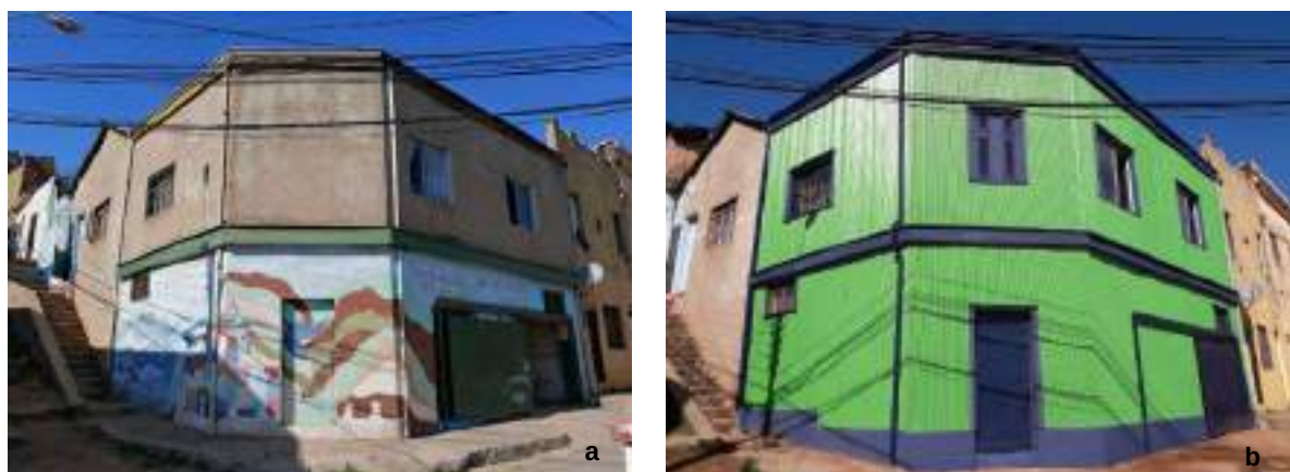
Figura 7: Obra realizada: a) antes de la intervención donde se observan evidentes fisuras en los estucos de cemento; b) Después de la intervención con revestimiento de acuerdo al estilo original de las viviendas patrimoniales de Valparaíso
