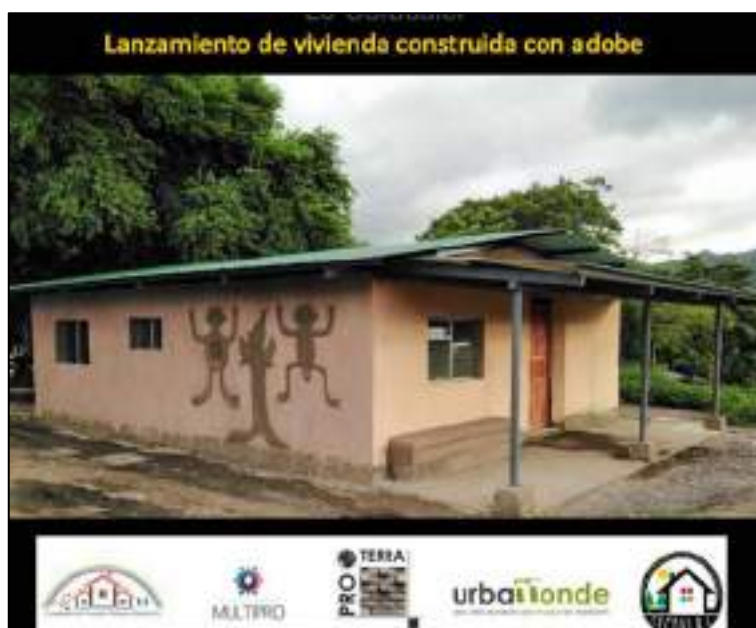
Figura 5. La casa piloto ya terminada (Crédito: Multipro)
