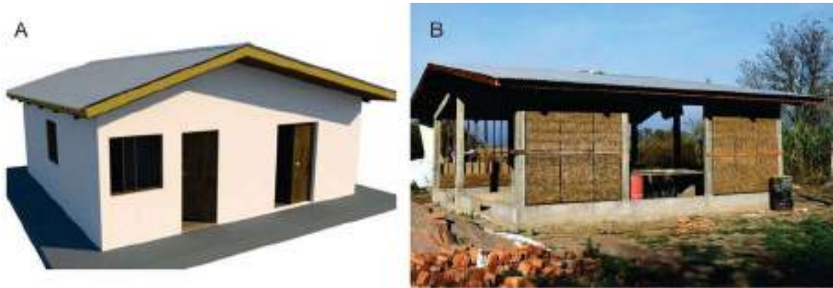
Figura 2. A) modelo 3d del edificio destinado al depósito de alimentos; B) estado de avance de la obra a marzo de 2021
