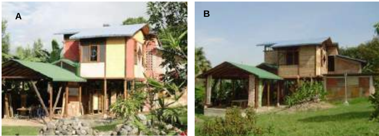
Figura 9. Sede Taller, un lugar para la investigación, experimentación y producción de los ecoacabados desde 2007: A) técnica de construcción mixta con madera y esterilla de guadua; B) uso de los revestimientos con pigmentados terrosos
