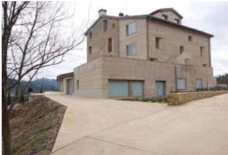
Figura 1. Imagen exterior del edificio
