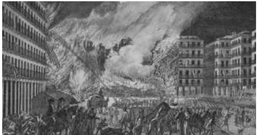
Figura 7. Recorte de la obra pictórica "Incendio de la Plaza Mayor de Madrid en 1790", donde se ve colapsando un edificio con estructura de madera. (Jimeno, 1807)
