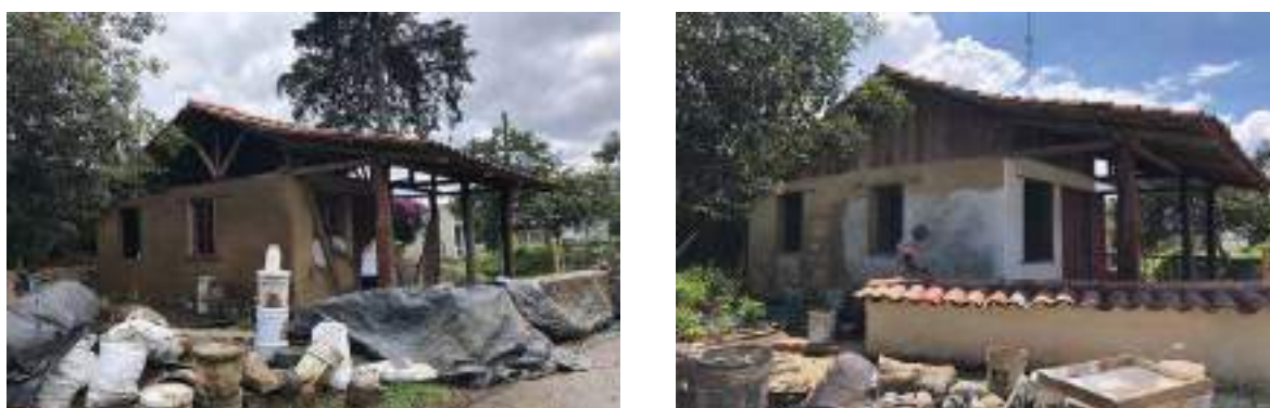
Figura 7. Procesos de revoco y encalado. Cierre de tapicheles y muro de adobe
