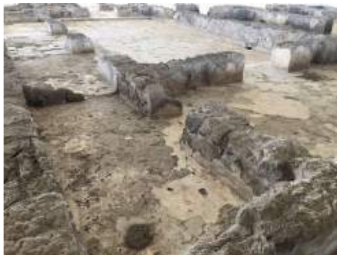
Figura 2. En el Gran Basamento de Cacaxtla, se puede observar cómo el tepetate fue utilizado sin un procesamiento complejo. Fue solamente tallado en burdos sillares que luego se asentaban con material en estado plástico bajo la lógica de la mampostería común (crédito: E. Avila, 2019)
