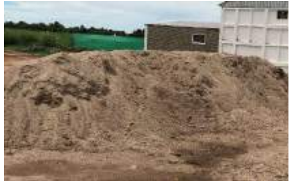
Figura 3: Acopio arena gruesa
