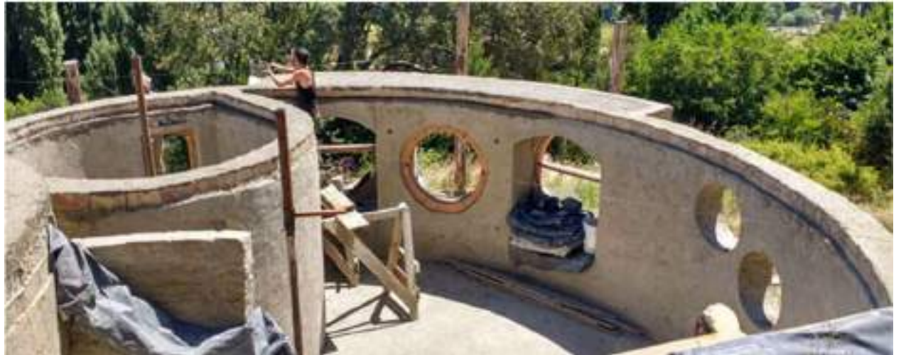
Figura 5. Construcción de paredes curvas con técnica de adobe "enhuacalado" | Fuente: "Debarro Arquitectura"
