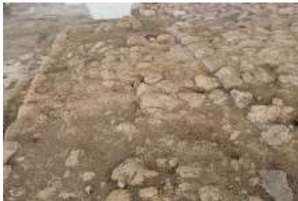
Figura 3. Para la edificación de “cajones” o “celdas” se utilizan bloques mejor trabajados que se alinean y conforman los muros perimetrales que posteriormente se van rellinando con piezas burdas (crédito: L. Guerrero, 2020).
