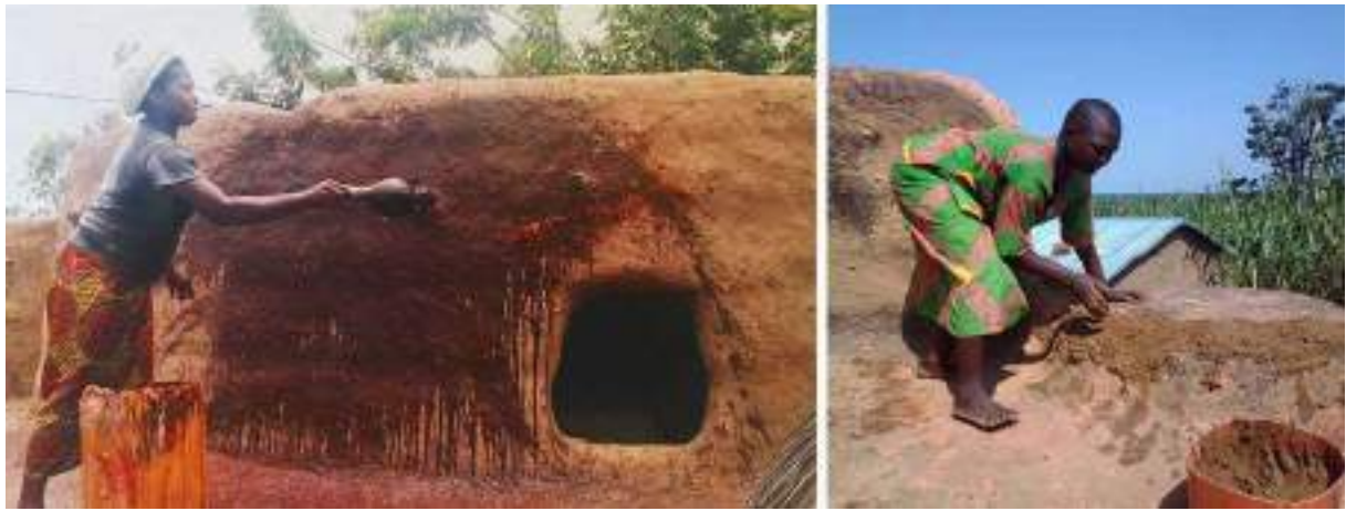
Figura 3. Mujeres realizando el enlucido sobre las takientas (créditos: C. Tastet, 2013)
