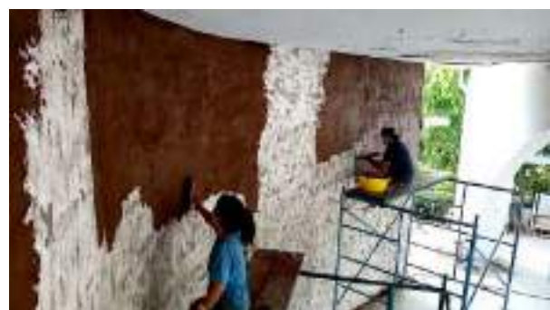
Figura 14. Revoque de tierra sobre puente de agarre. Crédito: Alexis Yael
