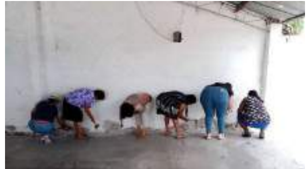
Figura 4. Mujeres quitando el revoque dañado en Huatecalco
