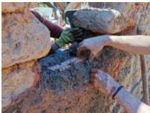
Figura 3. Consolidación de sección de muro de adobe de vivienda tradicional con cob y reglillas de madera como refuerzo horizontal para (Crédito:Colectiva Bioreconstruye, 2021)
