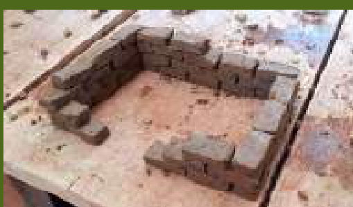
Fig. 6. Inicio de construcción mostrando las trabes
