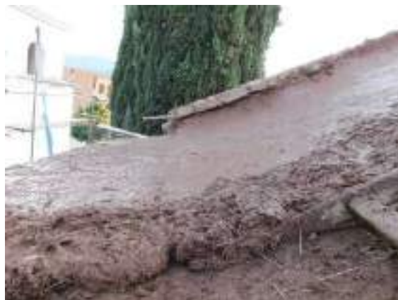
Figuras 11 y 12. Proceso de ejecución de la capa de base
