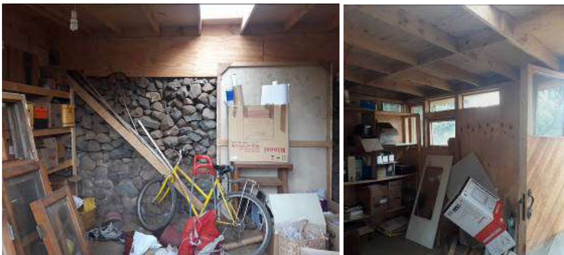
Figura 3. Situación original pared de piedras interior bodega y muro norte con placa interior
