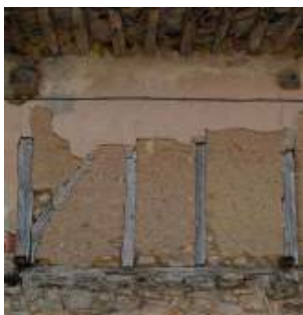
Figura 2. Muro entramado con tapialete en Valdazo (Burgos)
