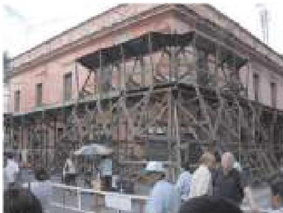
Figura 1. Vista de fachadas antes de la intervención
