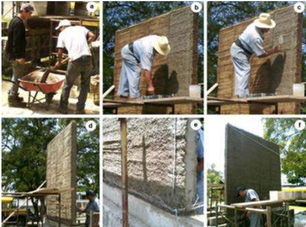
Figura 6. Aplicación de revestimiento primario (crédito: Chic, 2014)
