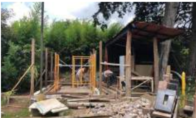
Figura 5. Levantamiento de estructura primaria en madera reciclada
