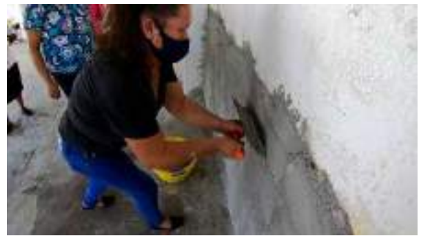
Figura 6. Aplicación de revoque fino de cal-arena
