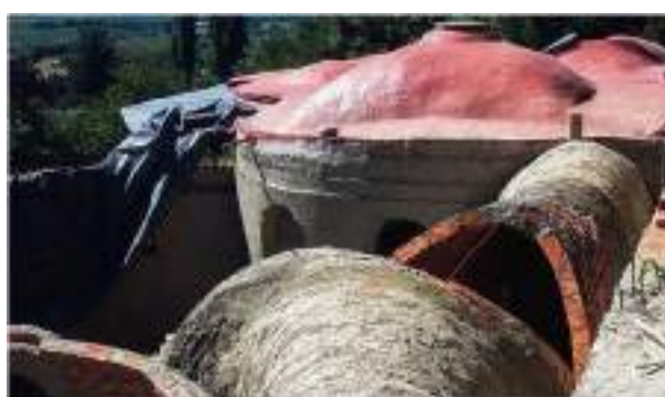
Figura 7. Construcción de techos abovedados sobre pared de adobe "enhuacalado" | Fuente: "Debarro Arquitectura"
