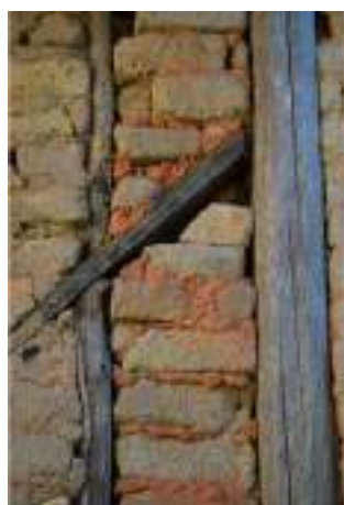
Figura 1. Muro entramado con adobe en Cepeda (Salamanca)
