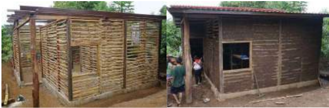
Figura 5. Proceso constructivo de vivienda de Bersaides con el sistema constructivo bahareque mejorado. Izquierda: envarillado con vara de bambú; derecha: proceso de embarre de vivienda (crédito: T. Juárez - FUNDASAL)
