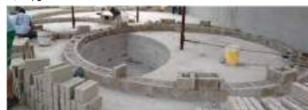
Figura 4. Construcción de pared curva con compás | Fuente: "Debarro Arquitectura"
