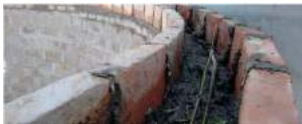
Figura 6. Construcción de una viga de encadenado superior con caña, arcilla y fibra larga | Fuente: "Debarro Arquitectura"
