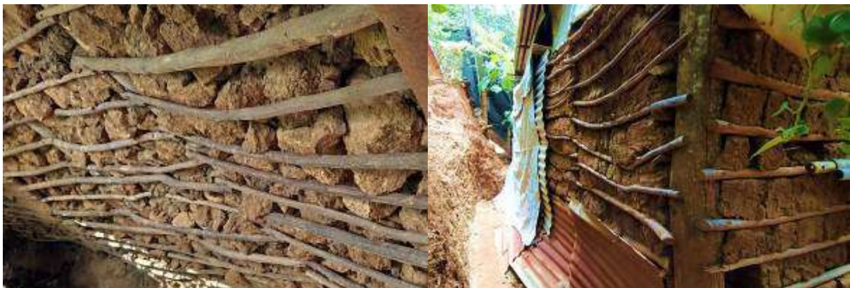
Figura 3. Viviendas existentes en Potrerillos, Alegría. Izquierda: relleno de pared con “terron” y piedra; derecha: bahareque con varas de árbol de Tigüilote (crédito: T. Juárez - FUNDASAL)
