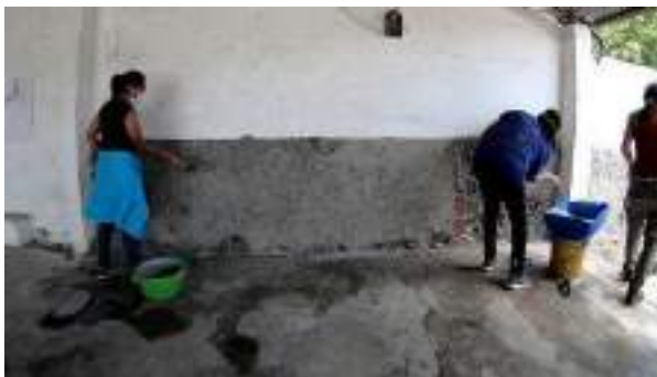
Figura 5. Aplicación de revoque base de cal-arena
