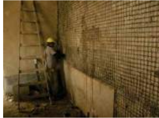
Figura 5. Atando los conectores de la malla
