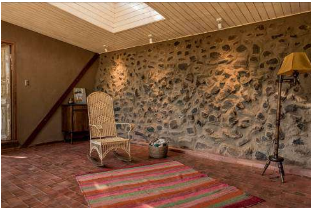
Figura 7. Terminación interior de la pirca con revestimiento de tierra y diagonal de refuerzo de madera entre muro de quincha y pirca (crédito: Tomás Munita)
