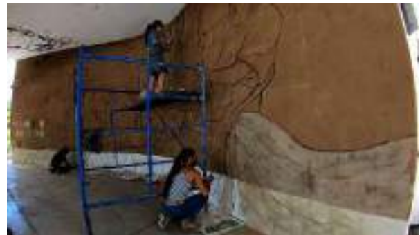
Figura 18 Revoque de tierra sobre muro con cuadrícula. Crédito: Alexis Yael
