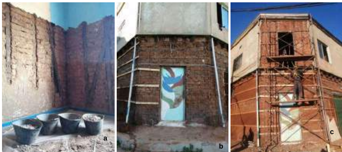
Figura 6: Obras realizadas: a) retiro de estucos interiores; b) reforzamiento de muro de adobe con malla electrosoldada; c) retiro de estucos en segundo piso y colocación de estucos en primer piso. Abertura de vano en ochavo
