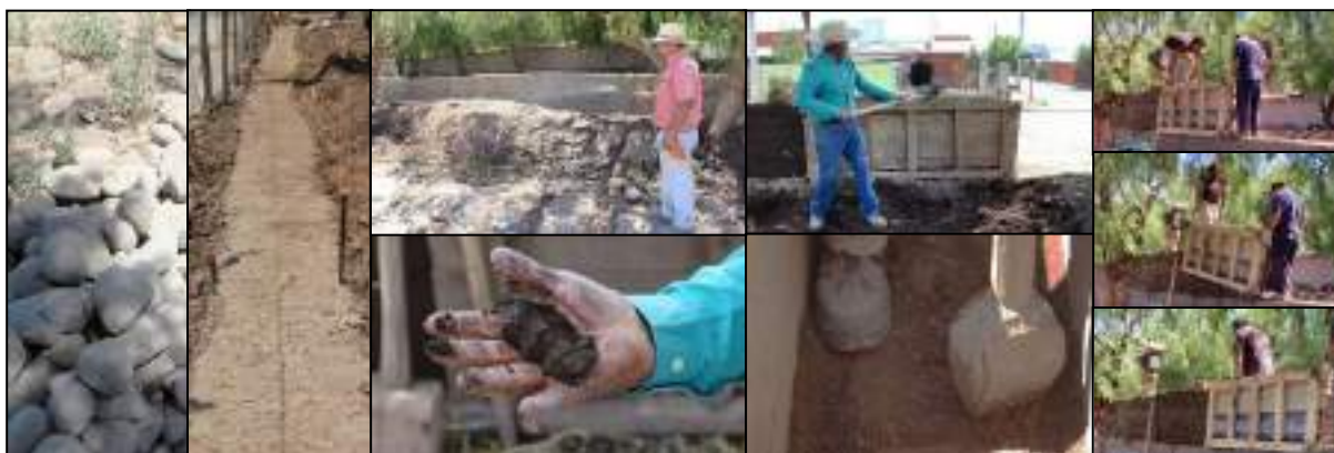
Figura 4. Proceso constructivo de las tapias
