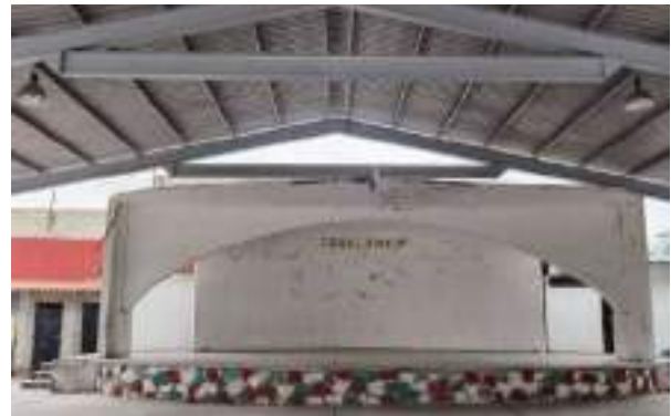
Figura 10. Muro en el auditorio de Huatecalco
