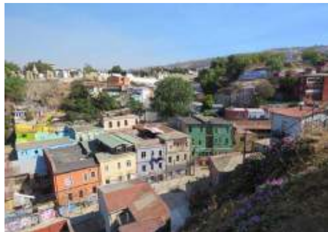
Figura 4: Casas en deterioro en la actual Quebrada Elías. Archivo propio
