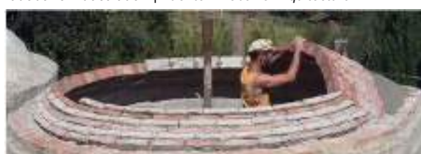
Figura 8. Construcción de una bóveda de adobe e ladrillo sin cimbra | Fuente: "Debarro Arquitectura"
