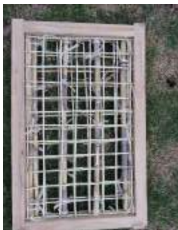
Figura 2. Estructura y malla de carrizo (crédito: M. Pesantes, 2019)
