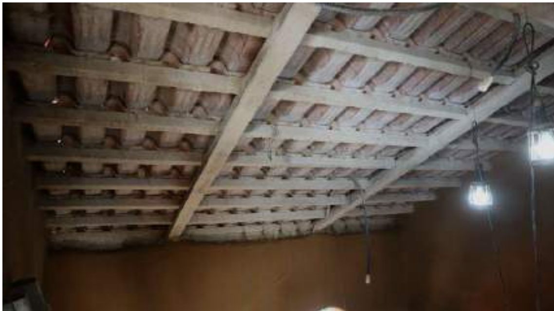
Figura 1. Techo de la cubierta existente. Las tejas están directamente aplicadas sobre la estructura ninguna capa de aislación térmica
