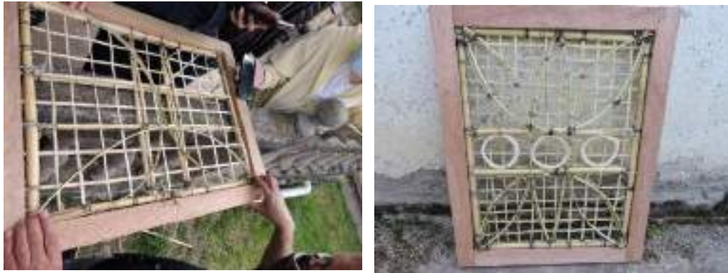
Figura 3. Estructura y malla de carrizo (crédito: K. Núñez, 2021)
