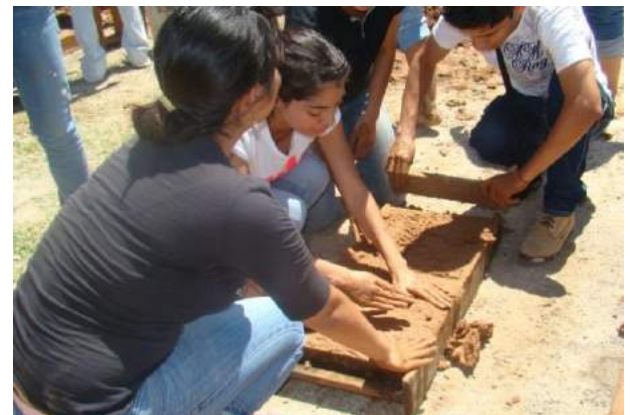
Figura 3. Estudiantes participan en elaboración y colocación de adobes
