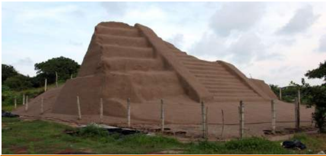
Figura 1. Vista desde el noroeste de la fachada de la Pirámide de La Joya, con el nuevo talud de contención y con la capa de sacrificio de tierra con bitumen disuelto (Foto Daneels, 7 de julio 2014).
