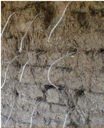
Figura 3. Colocación de la rafia cada 30 cm en la zona del mortero
