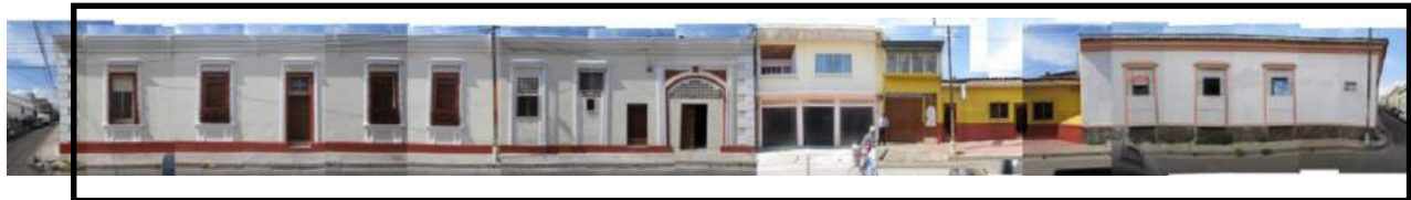
Figura 3: resultados finales en la intervención de inmuebles de "Villa Morena"
