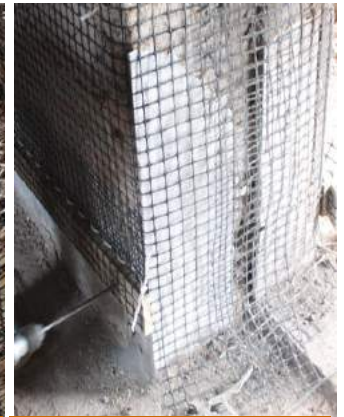
Figura 6. Sujeción geomalla en parte inferior del muro
