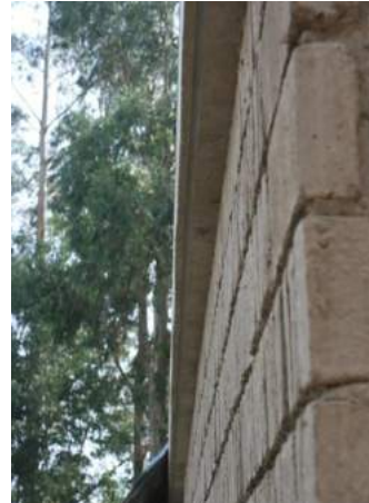
Figura 9 – Detalle de la solera y escurridor de agua lluvia
