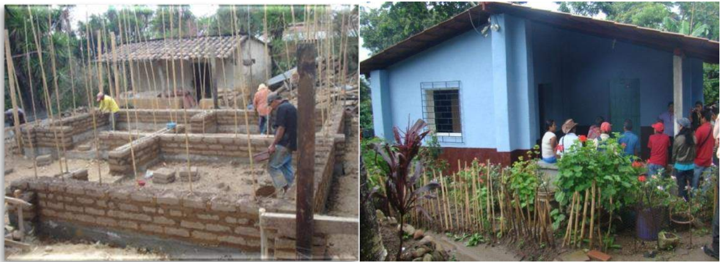
Figura 5 – Construcción con sistema adobe reforzado (Créditos, FUNDASAL, 2011)
