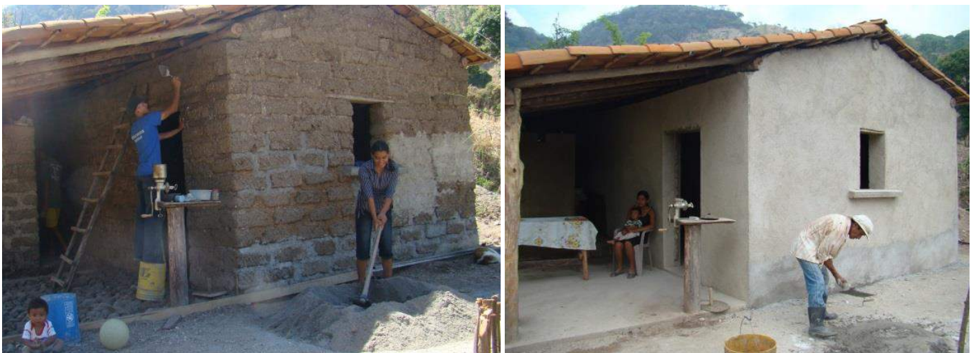
Figura 3 – Restauración y mejora de paredes de adobe (Créditos: FUNDASAL, 2010)
