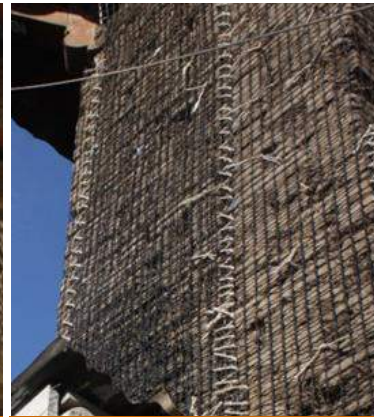
Figura 5. Retorno de la malla en esquinas (100 cm)
