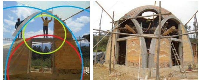
Figuras 5a y 5b – Proporciones áureas de las paredes construidas con tierra.
