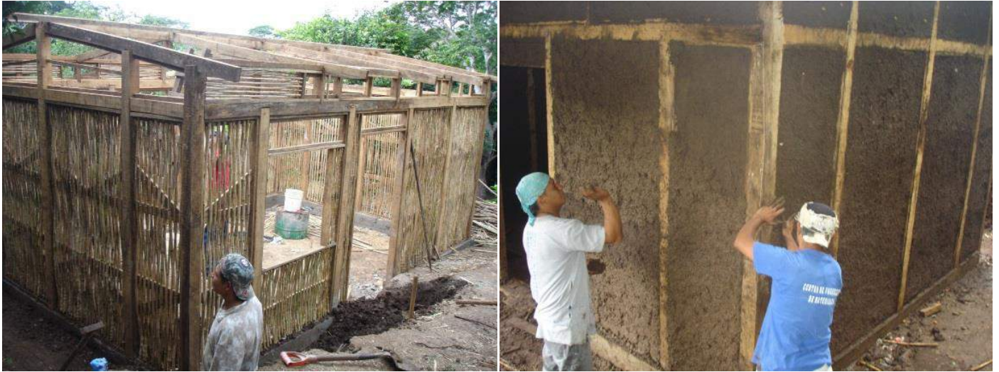
Figura 6 – Construcción de vivienda con sistema quincha prefabricada (Créditos, FUNDASAL, 2011)
