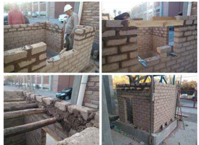
Figura 3. Construcción de los modelos a escala.
