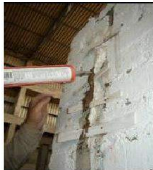
Figura 7 – Inyección de mortero
