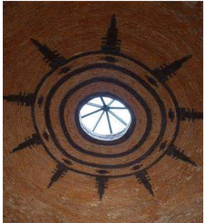
Figura 4 – Cúpula construida en ladrillo con la técnica sin formaleta, al interior de IEIASCA
