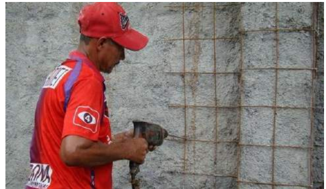
Figura 2 – Refuerzo estructural con mallas electrosoldadas (Créditos: FUNDASAL, 2009)
