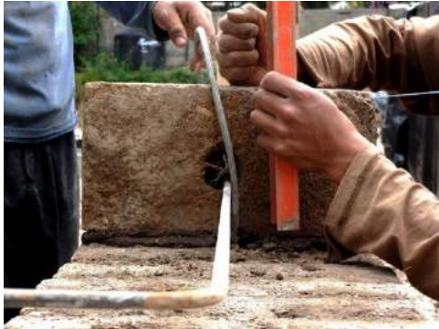
Figura 8 – Detalle de refuerzos, varilla y cable.
