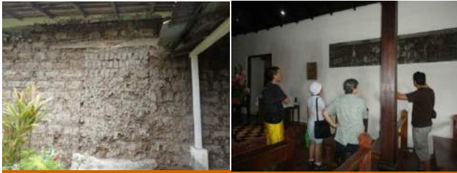
Figuras 5 y 6. Puerta sellada que se encontró al quitar el repello de concreto y testigo dejado justo en la parte superior de la puerta.
