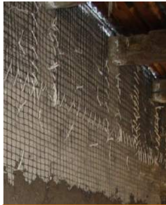
Figura 4. Retorno de malla entre las cerchas (80 cm)
