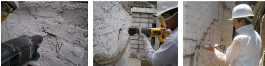
a) Uso de taladro eléctrico b) Uso de cuchillo eléctrico c) Inyección de barro líquido
