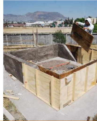
Figura 5. Prototipo con muros de tierra vertida compactada por capas. (Foto: L. Guerrero)
