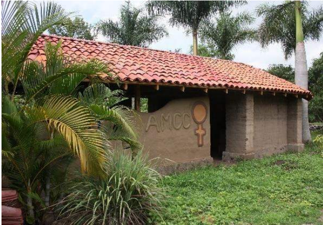
Figuras 5. Cafetín construido con adobe mejorado y otras técnicas con tierra en la nueva sede de la escuela y muestra del repello (revoco) y pintura con tierras naturales aprendidas en el intercambio con la especialista Liz Johndrow.
