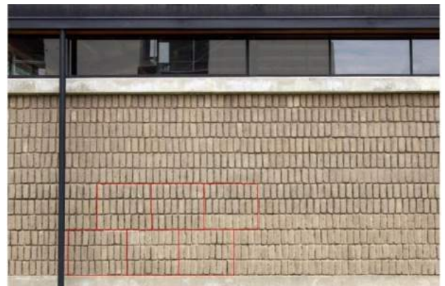
Figura 4 – Esquema de trabe entre bloques de adobes
