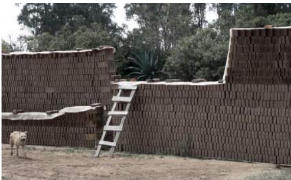
Figura 1 – Pilas de adobes en talleres artesanales de elaboración de ladrillos. Apariencia que se desea dar a los muros en la obra Lienzo de Barro.
