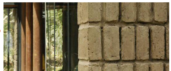
Figura 12 –Detalle del acabado del muro
