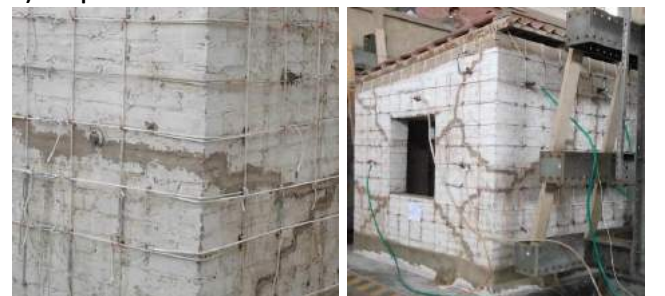
c) Detalle de refuerzo d) Modelo reparado y reforzado
