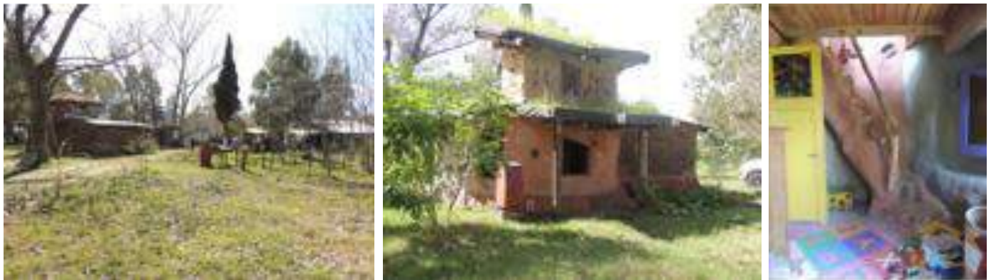
Figura 3 – Aldea Atrapasueños, casa principal y otras construcciones
