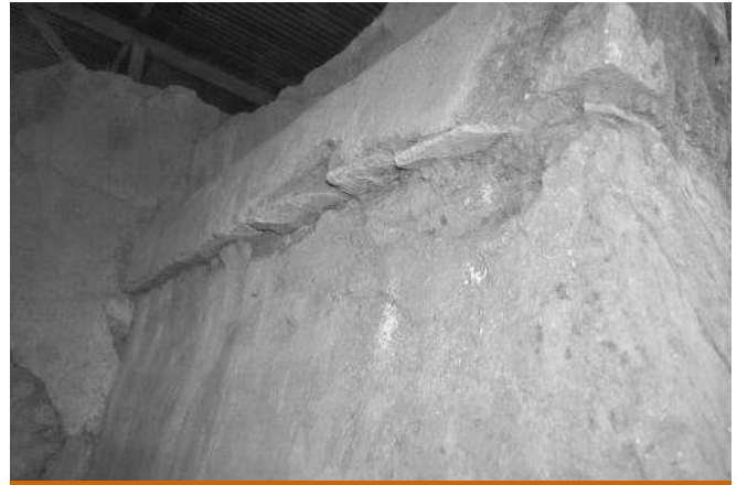
Figura 6: Detalle de la fachada sur del Edificio K donde se observa el uso de lajas para soportar las molduras. Fotografía por D. Juárez
