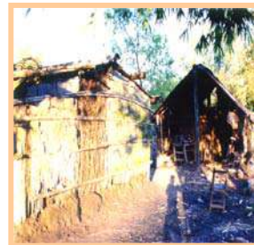
Cerramiento vertical en caña y barro.
