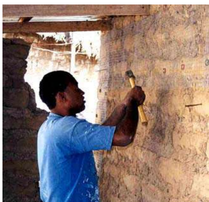
Fig. 17a – Refuerzo de malla de alambre electrosoldada.
