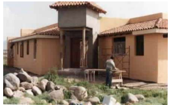
FOTO 6 Vista torreón de acceso desde surplente.
