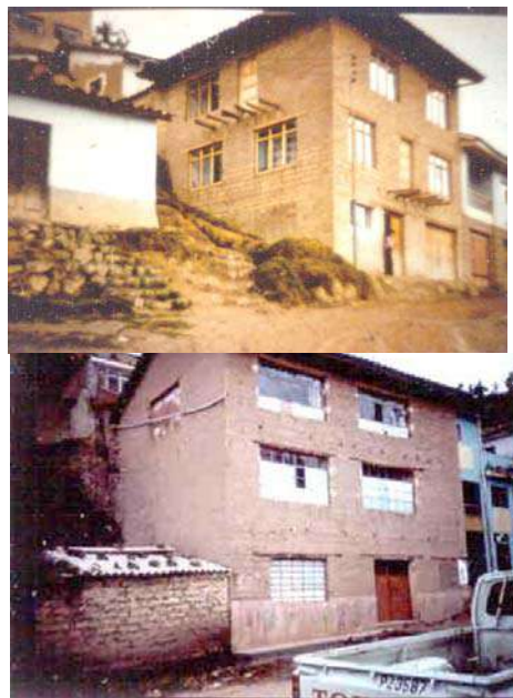
Fig. 9 – Viviendas de adobe de tres pisos.
