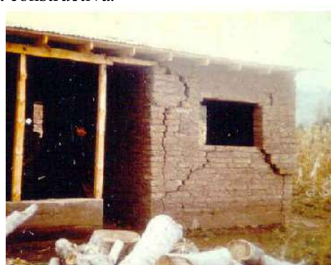
Fig. 11 – Grietas diagonales por corte en los muros.
