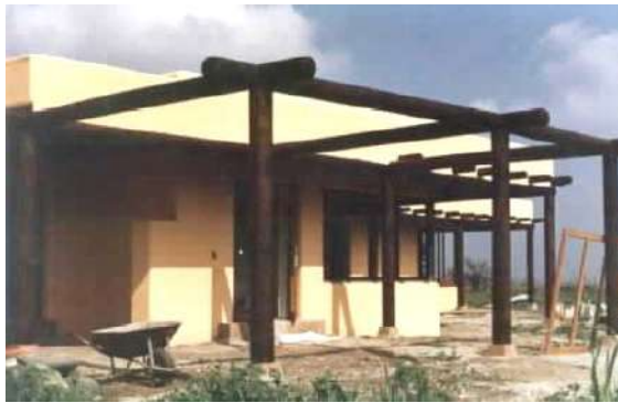
FOTO 5 Vista corredor fachada norte.
