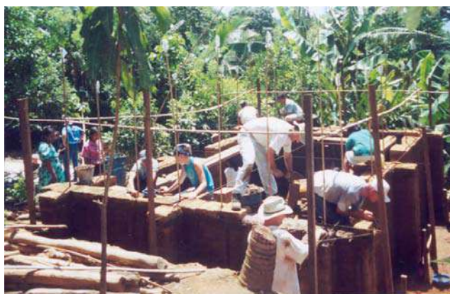
Figura 3: Proceso de construcción vivienda modelo.
