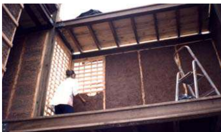
Figura 12. Fotos do momento do barreamento e da construção concluída, São Carlos, SP. (Foto: Wilza Lopes, 1998)
