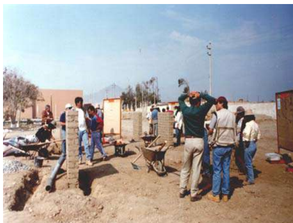
Fig.8 – Execução de drenagem – Curso PAT99/Peru
