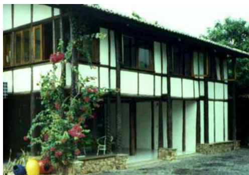
Fig. 02. Detalhes externo e interno de construção de taipa de mão, com estrutura em carnaúba, situada em Teresina, Piauí. (Foto: Wilza Lopes, 1997).
