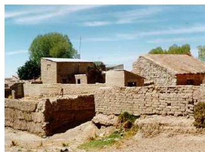
Vivienda rural con sustitución de materiales en la cubierta. Zona periurbana de La Paz (Foto: A. Calla)
