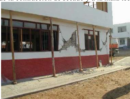
Fig. 11 – Grietas diagonales por corte en los muros.
