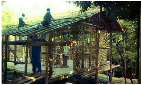
Figura 10. Vistas da colocação das telhas e da construção concluída, Linhares, ES. (Foto: Akemi Ino e Karla Caser)
