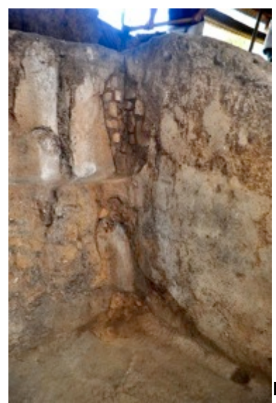
Figuras 5 a y 5 b: Daños ocasionados por agua pluvial, Sección superior del Edificio K. Se observan los numerosos escurrimientos que afectaron los escalones superiores, ocasionando la pérdida de aplanados Fotografía por D. Juárez
