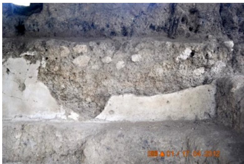
Figura 6: Detalle da la fachada este del Edificio K donde se observa los cantos de pómez como parte del sistema constructivo. Fotografía por D. Juárez
