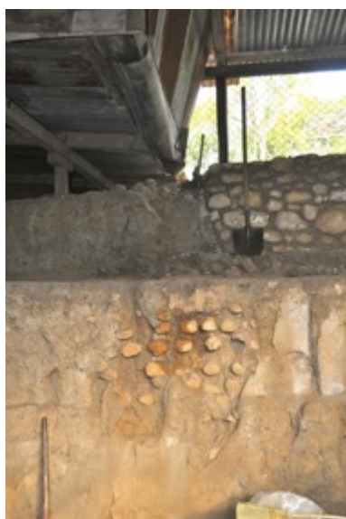
Figuras 5 a y 5 b: Daños ocasionados por agua pluvial, Sección superior del Edificio K. Se observan los numerosos escurrimientos que afectaron los escalones superiores, ocasionando la pérdida de aplanados Fotografía por D. Juárez
