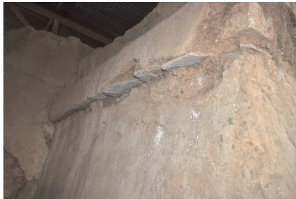
Figura 7: Detalle de la fachada sur del Edificio K donde se observa el uso de lajas para soportar las molduras. Fotografía por D. Juárez
