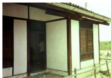
**Figura 07.** Painéis de bambu montados Fonte: Hays e Matuk (1993)
