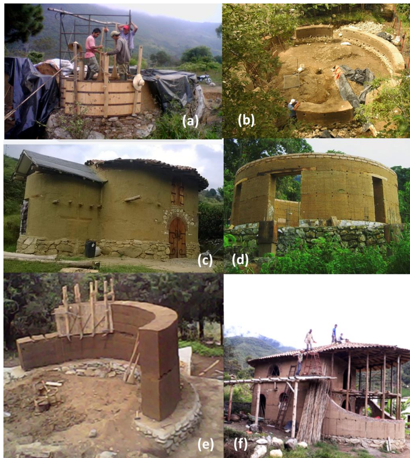
Figura 3. Obras realizadas con el tapial de radio variable: (a) El tapial curvo en funcionamiento, (b) Casa Trujillo, (c) Casa Santiago, (d) Cocina Granja-Escuela, (e) El Portal, donde puede observarse el tapial de radio variable todavía en el muro y (f) Casa Moncada
