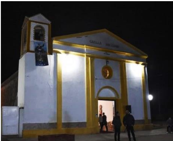
Figura 5. Fachada principal de la Iglesia de San Isidro, Jáchal
