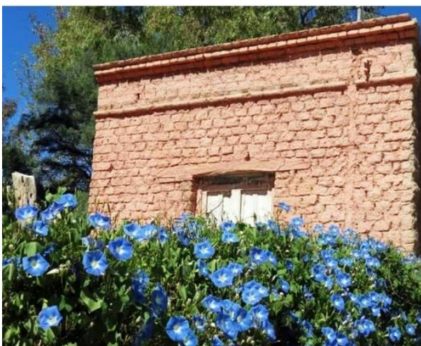
Figura 7. Vivienda adobe con dinteles de madera en San Isidro, Jáchal
