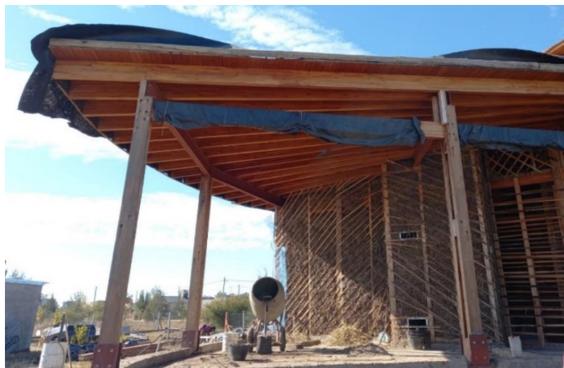
Figura 4. Vivienda en construcción en la localidad de Arroyo Leyes, Santa Fe, 2022
