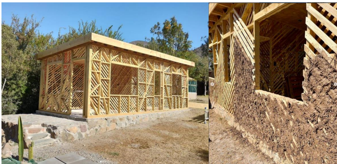
Figura 2. Fotos de la obra de la cabaña
