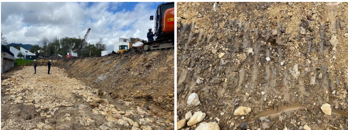
Figura 11. Izquierda: excavación del Bloque A de Nuevos Espacios para las Artes; Derecha: tierra seleccionada para envoltivo
