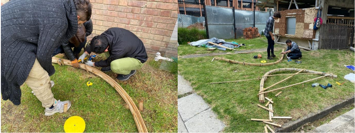
Figura 7. Izquierda: proceso de curvado de latas a través de las guías; Derecha: arco de viga-lata terminado y trabado
