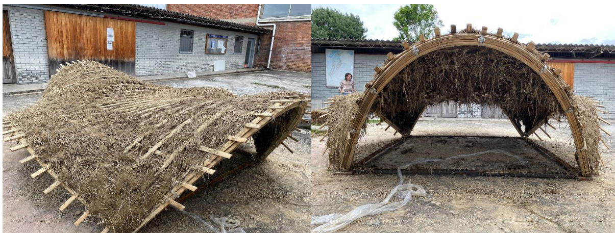
Figura 15. Estructura con envolvente de tierra aplicada
