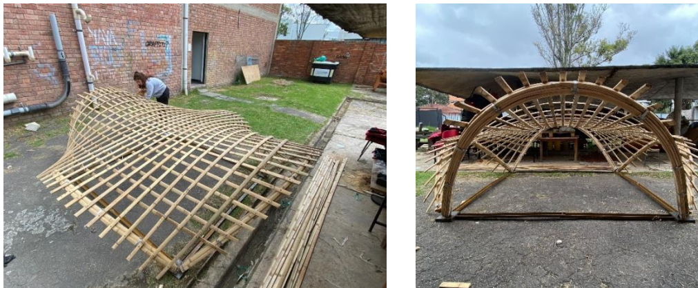
Figura 10. Estructura final de paraboloides hiperbólico
