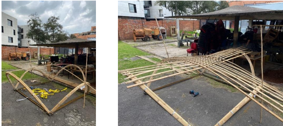
Figura 9. Izquierda: montaje de latas guía centrales; Derecha: elaboración del diafragma
