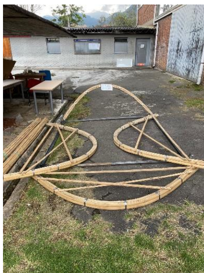
Figura 8. Izquierda: arcos de viga-lata antes de empotrar; Derecha: arcos de viga-lata empotrados en el marco metálico
