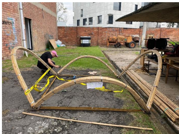
Figura 8. Izquierda: arcos de viga-lata antes de empotrar; Derecha: arcos de viga-lata empotrados en el marco metálico
