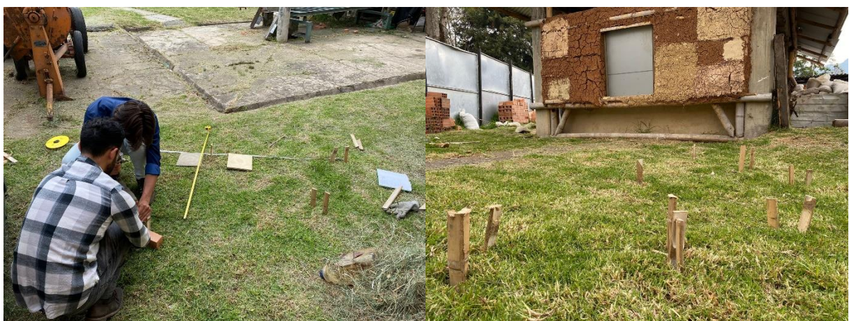
Figura 4. Derecha: proceso de elaboración de guías para conformación de vigas-lata; Izquierda: guía elaborada para arco menor
