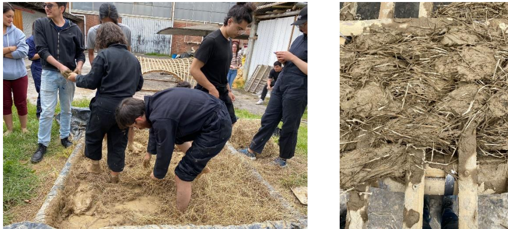
Figura 13. Izquierda: pisado de la tierra con aplicación de heno; Derecha: trenzado de tierra en la estructura de guadua
