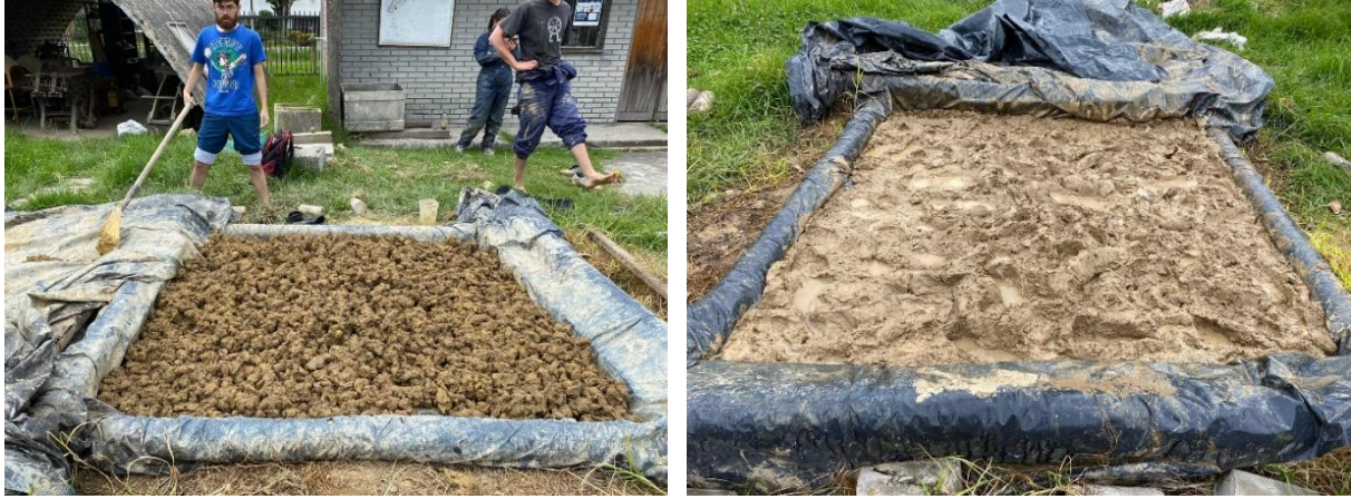
Figura 12. Izquierda: tierra estabilizada una semana previa a su aplicación; derecha: tierra estabilizada para pisar el día de la aplicación
