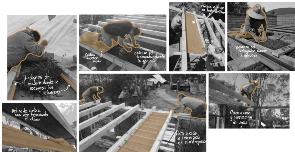
Figura 1. Proceso constructivo del entreciso de pajarilla tradicional
