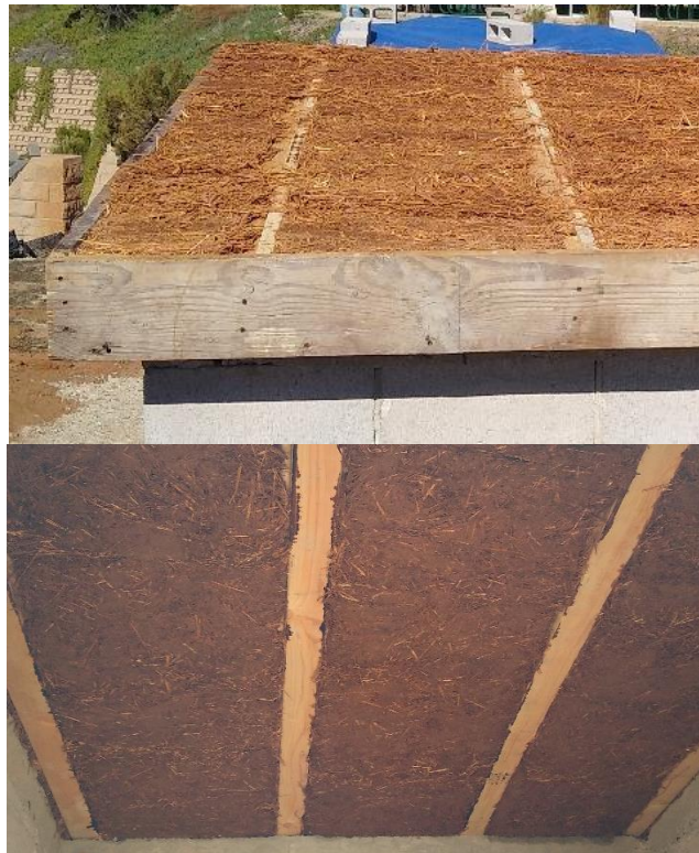
Figura 7. Superficies interior y exterior de la cubierta
