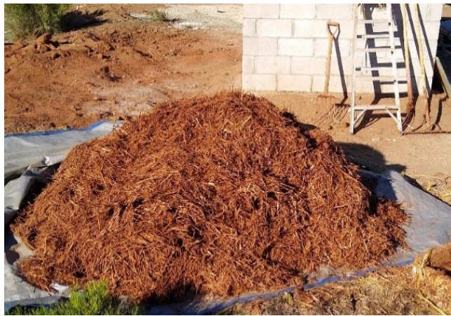
Figura 5. Mezcla de pajarcilla antes de colocarse en la cubierta
