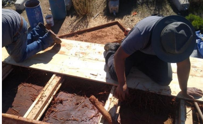
Figura 6. Construcción de cubierta con pajarcilla
