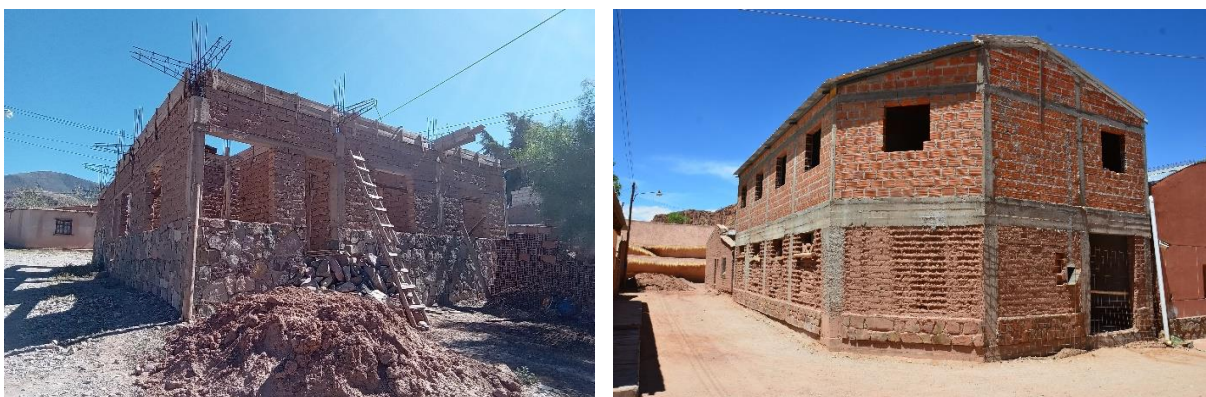
Figura 5. Construcciones de adobe con estructura de hormigón armado en Tilcara, a la izquierda, y en Susques, a la derecha, incluyendo también bloques cerámicos
