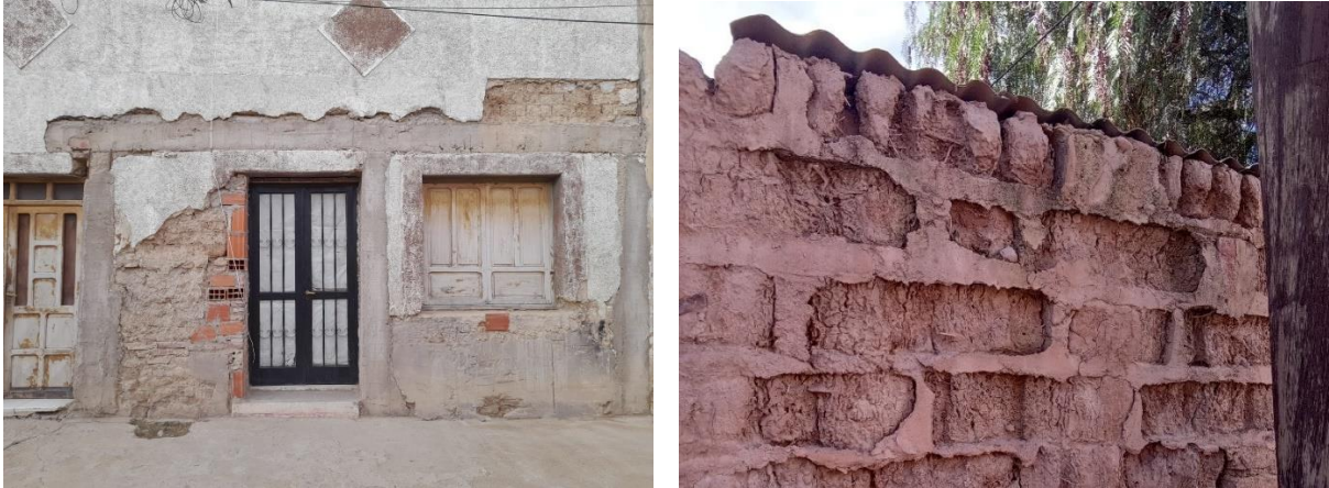
Figura 6. Marco estructural de hormigón armado en un muro de adobe en La Quiaca, a la derecha, y un aparejo de adobe con juntas cementicias en Tilcara
