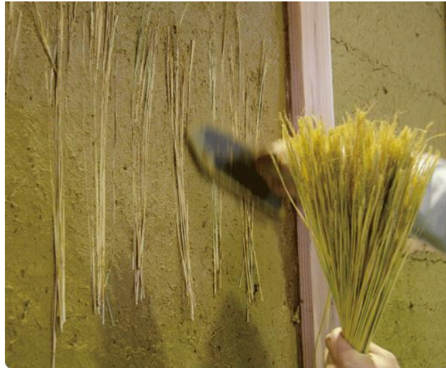
Figura 3. Kote em ação na aplicação de fibras para evitar fissuras (Fonte: tsuchikabe network 4 )
