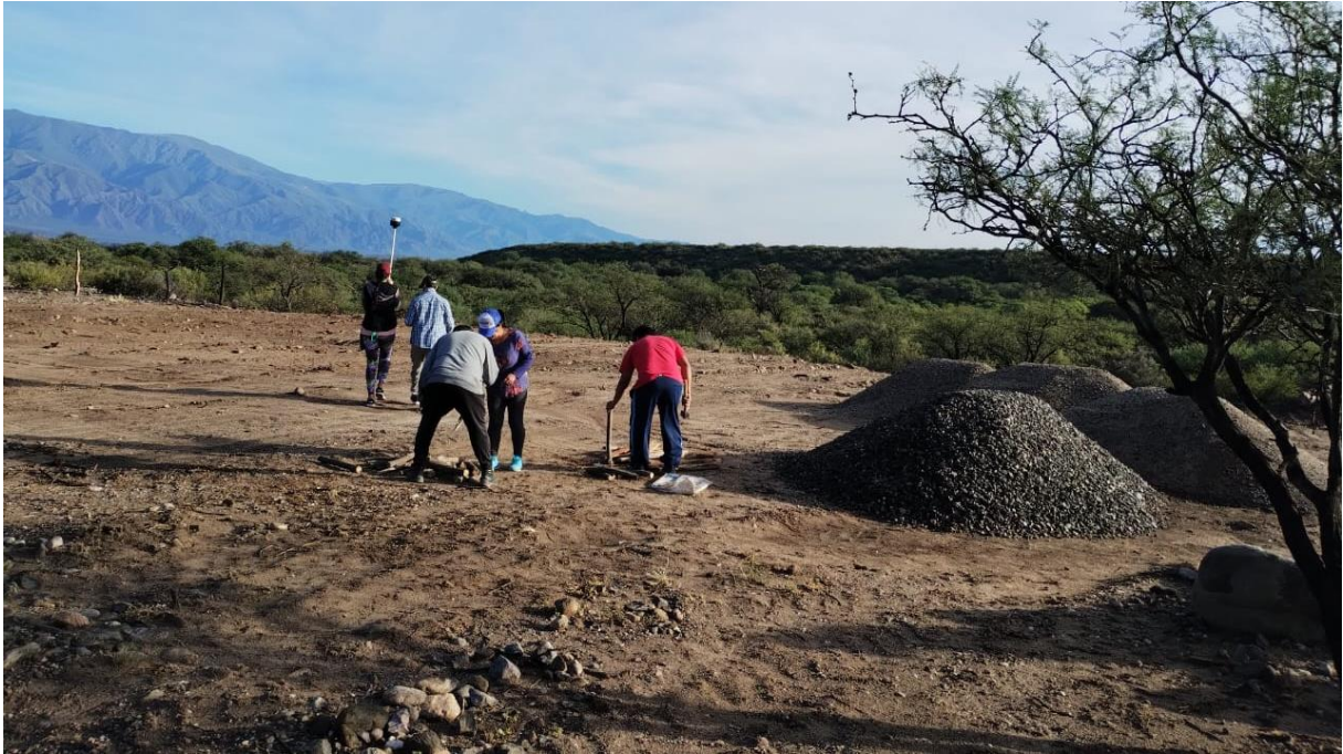
Figura 3. Replanteo de obra de la plataforma en el terreno
