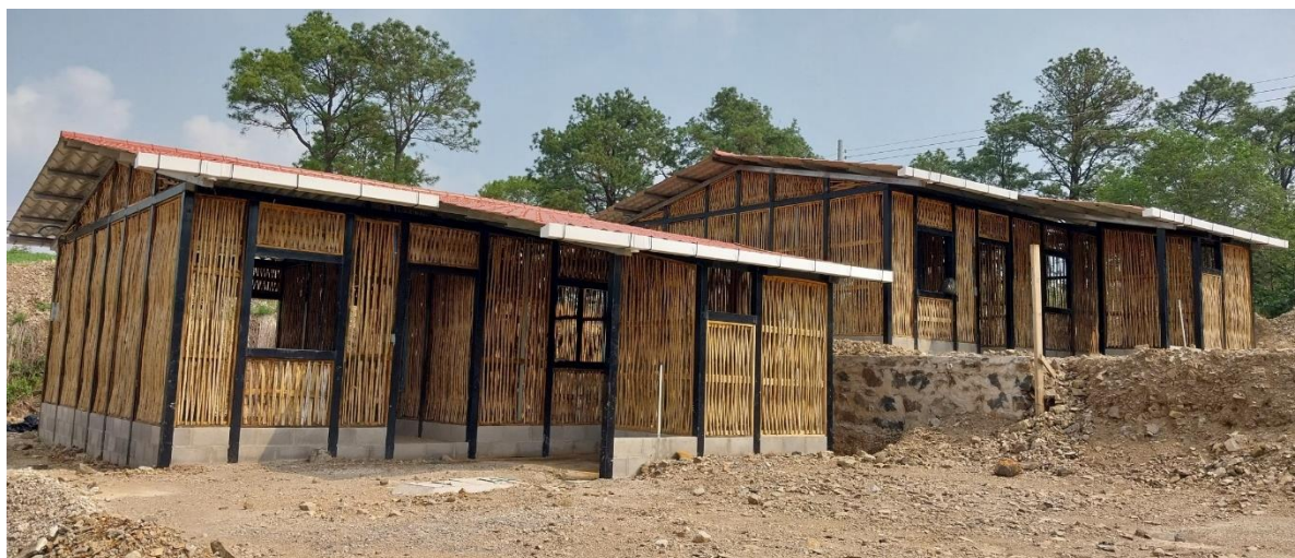
Figura 6. Vivienda de quincha en proceso de embarrado (acervo FUNDASAL, 2024).
