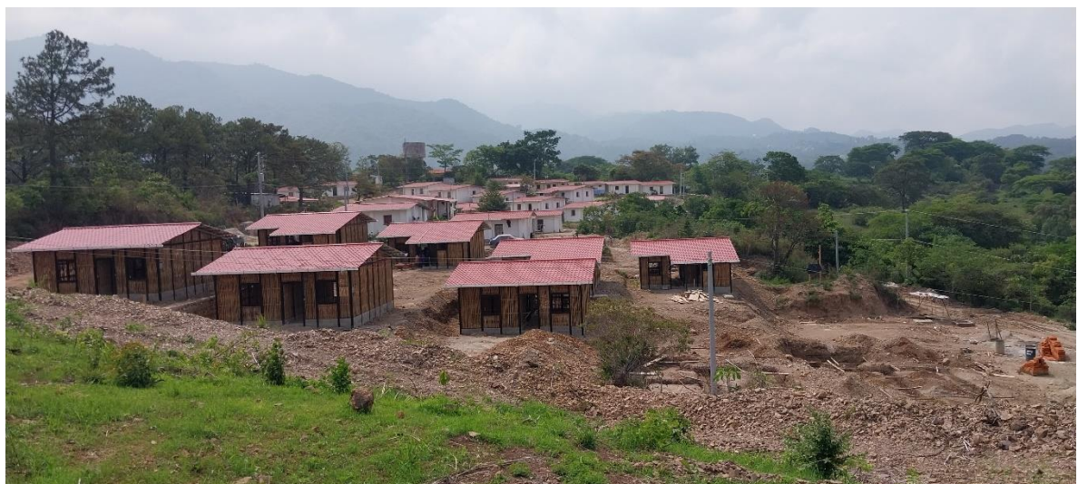
Figura 1. Cuna de la Paz: viviendas habitadas con el sistema adobe reforzado por ACOVIAMET y viviendas de quincha en proceso de construcción por ACOVICUPA (acervo FUNDASAL, 2024).
