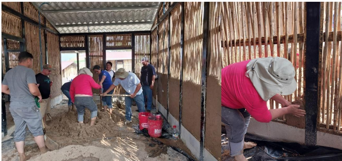
Figura 7. Participación de cooperativistas en la preparación de mezcla para embarado de paredes (acervo FUNDASAL, 2024).
