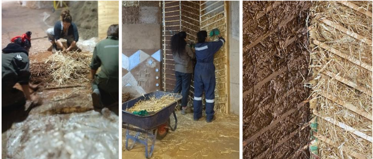
Figura 3. Práctica de quincha: izquierda – preparación de material de relleno; central – puesta en obra; derecha – resultado final de la práctica (acervo Cíclica)
