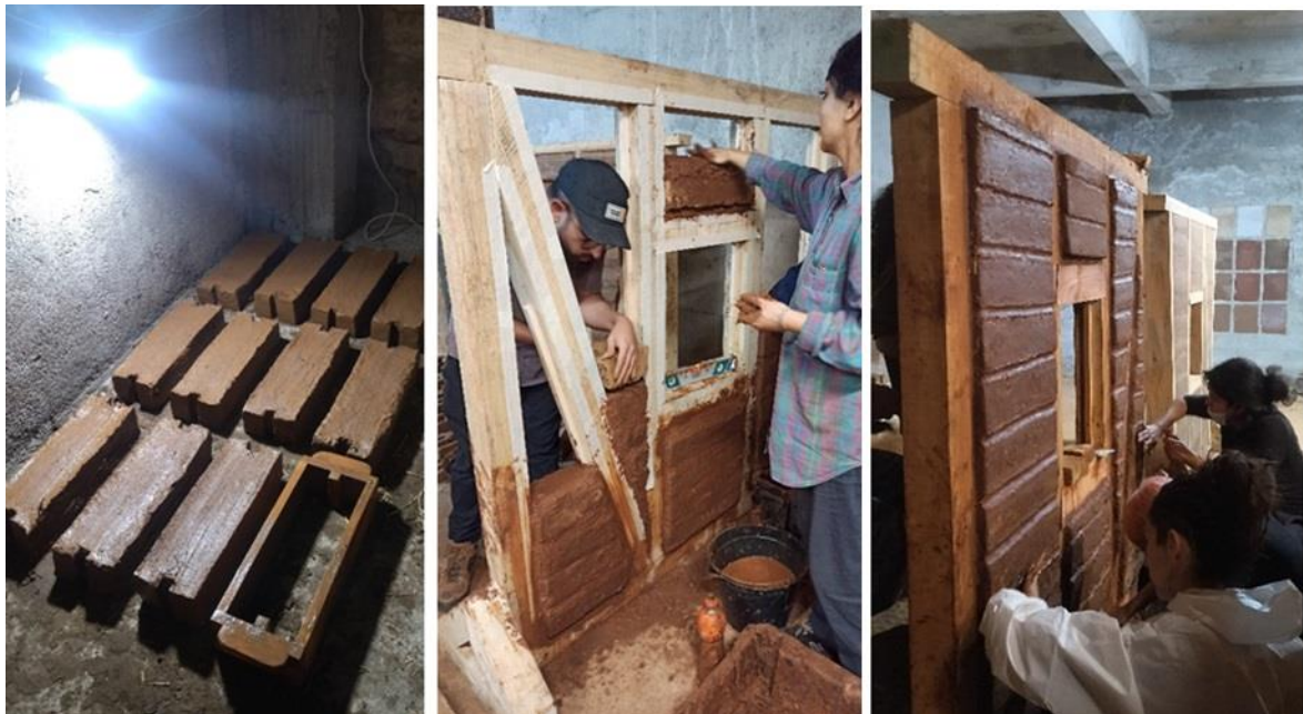
Figura 2. Fabricación y proceso de puesta en obra de adobillos (acervo Cíclica)
