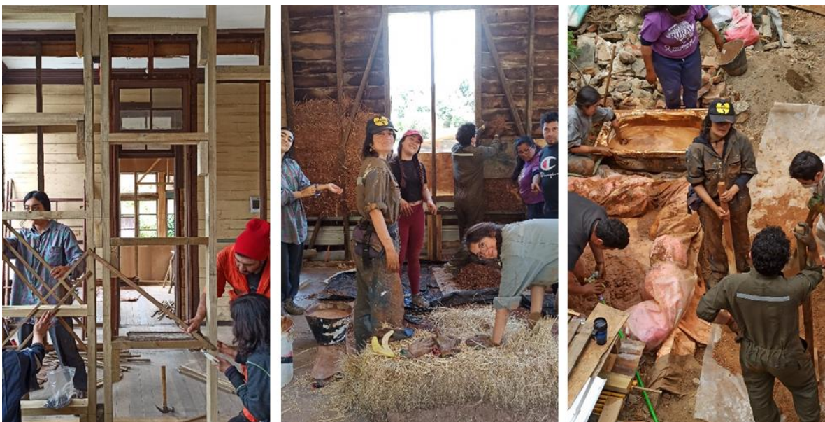
Figura 6. Aplicación en obra real de conceptos aprendidos durante el curso): izquierda – colocación de entramado de madera para quincha; central – preparación de mezcla de tierra alivianada y relleno de muros del fondo; derecha – preparación de mezcla para revocos (acervo Cíclica)
