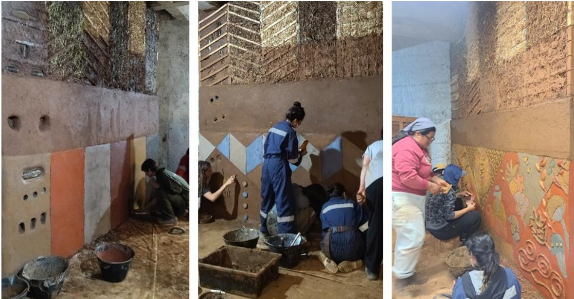
Figura 5. Aplicación de revocos finos con técnicas decorativas: izquierda y central – aplicación de revocos pigmentados; derecha – ejecución de mural mediante técnicas decorativas de sobre-relieve y esgrafiado (acervo Cíclica)
