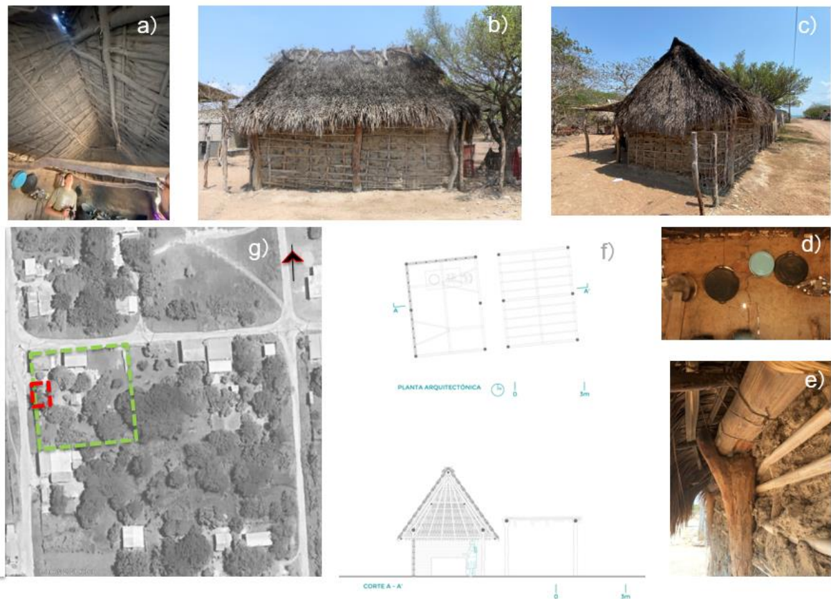
Figura 2. Ficha de integración de información gráfica sobre el sistema de bajareque de Huamúchil. a) vista interior, b) vista exterior fachada poniente, c) vista fachada norte, d) detalle interior de cocina con aplanado y utensilios, e) detalle del sistema de tierra de relleno f) planta y sección arquitectónica y g) relación del solar y la construcción de bajareque (acervo del LABPYSCT: fotografías y dibujo por Paul Castillo)
