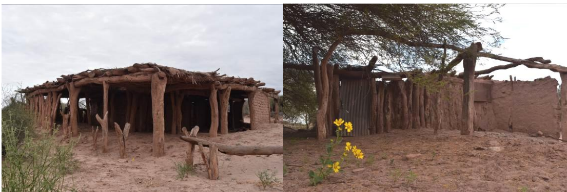
Figura 5. Viviendas de Bañados de Pantano con cerramiento vertical combinado de palo a pique y de adobe
