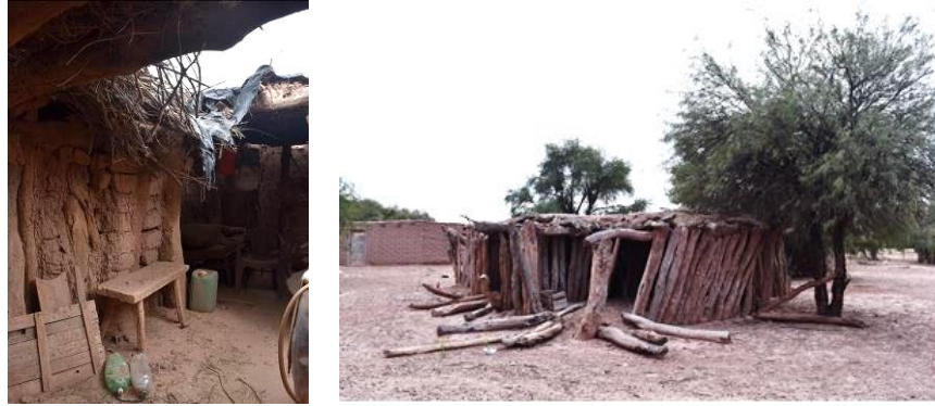
Figura 7. Caída de las cubiertas y desplome de los cerramientos verticales en la arquitectura popular de Bañados del Pantano
