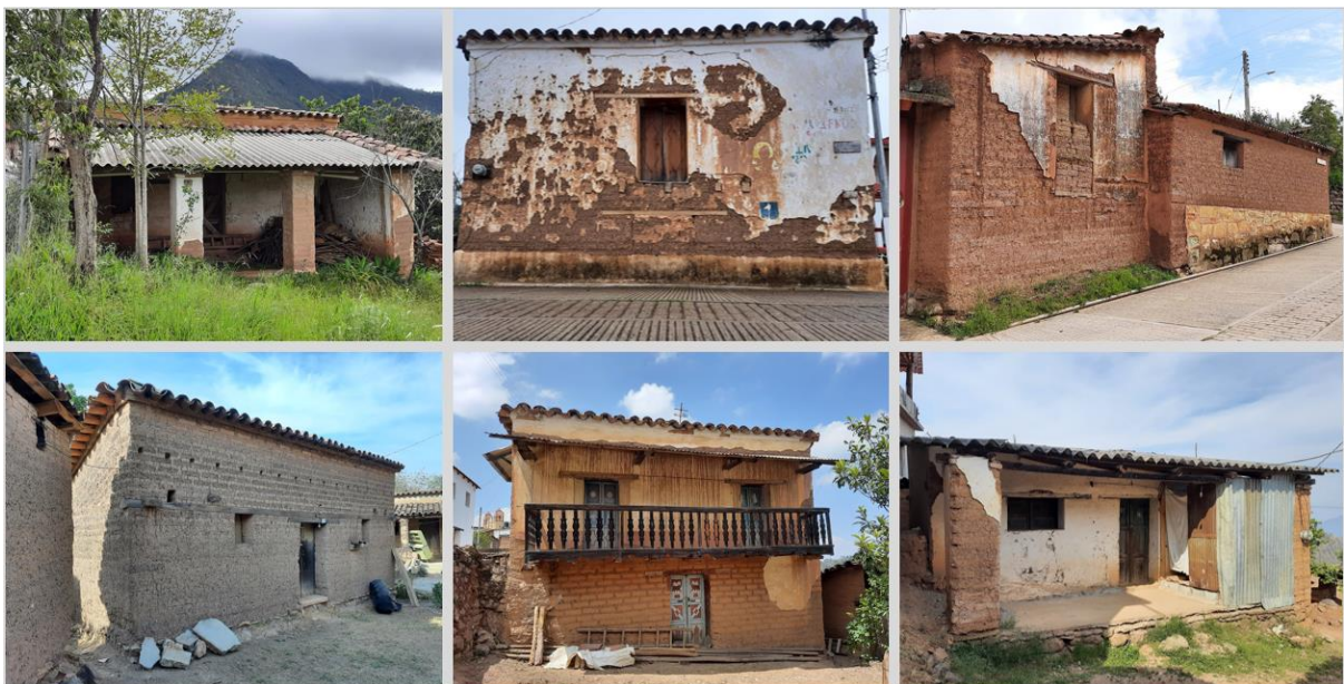
Figura 2. La vivienda de adobe en San Miguel Cajonos. Actualmente la tierra sigue siendo el material de Construcción con mayor presencia en la comunidad
