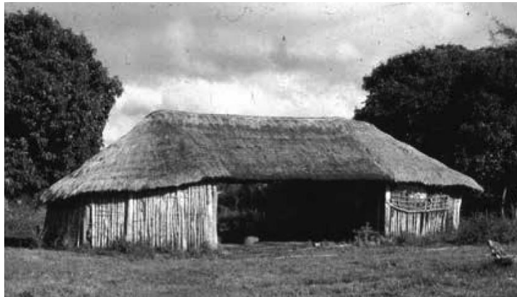
Figura 1. Vivienda rural tipo cubata jovai en el Guairá en la cual se puede ver el estaqueo (Ríos Cabrera, 2018, p.107)
