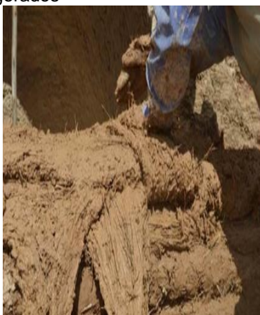
Figura 1: sistemas constructivos denominados Caruna, "Takta", "Tajta", "Pira", "T'ili": técnica constructiva aymara, para los cielos de barro y paja aligerados
