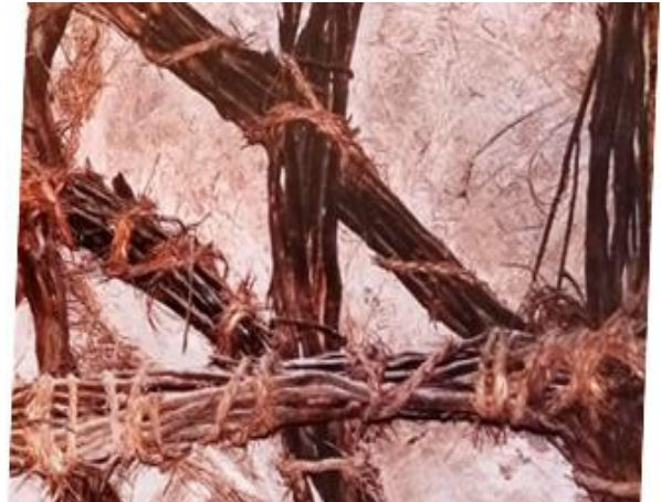
Figura 2: estructura que sostiene la cúpula de una "Wallich Koya, vivienda rural circular Uru se aprecia "Tacta" o "Wara" (De la Zerda, 1993)
