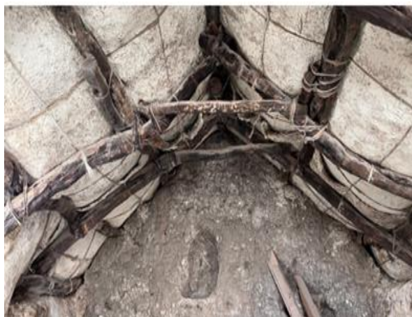
Figura 1: sistemas constructivos denominados Caruna, "Takta", "Tajta", "Pira", "T'ili": técnica constructiva aymara, para los cielos de barro y paja aligerados
