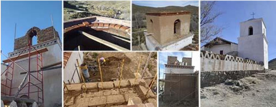
Figura 6. Obras de reconstrucción torre capilla de Santa Bárbara
