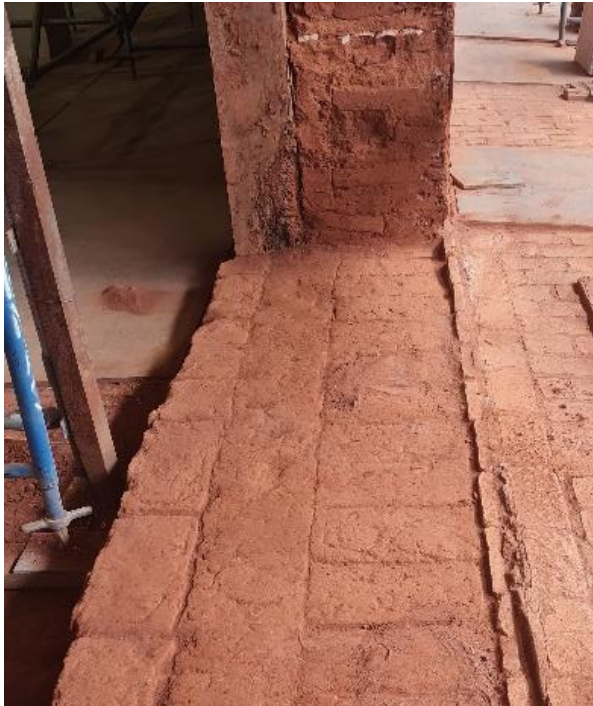
Figura 3. Muro de adobes en el sector desmontado en el sector que sería la nivelación
