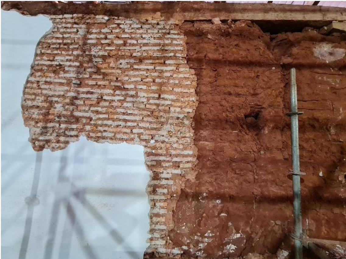
Figura 6. Muro de adobes con relleno de ladrillos cocidos
