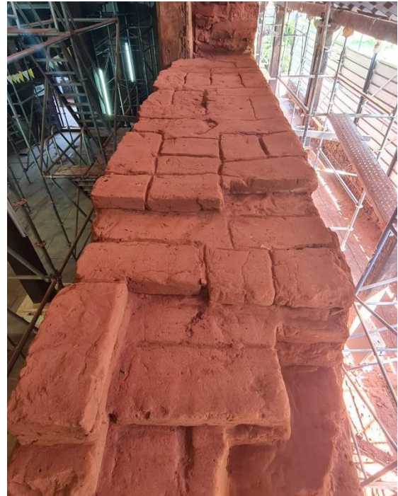
Figura 4. Muro de adobes en la parte superior del sector desmontado
