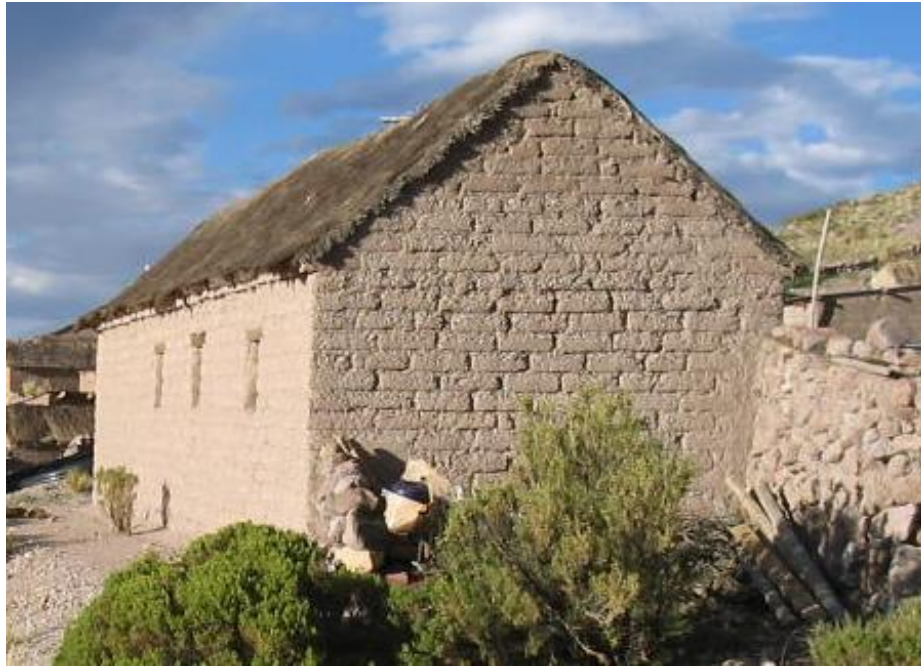
Figura 5. Muro base de piedra, que recibe a los adobes y paja brava en su cubierta
