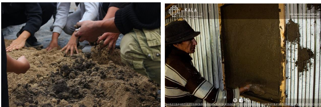
Figura 7: Reconstrucción de espacios con técnicas constructivas andinas
