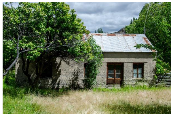
Figura 5. Pulpería Mondelo, comuna de Cochrane, Región de Aysén, construida en adobe, zona rural, 2020 (crédito: Tándem)
