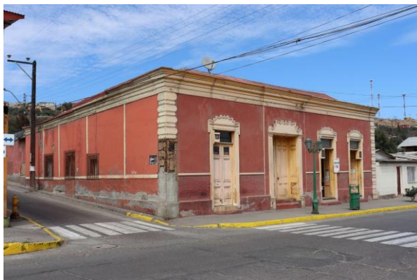
Figura 4. Casa Vega, comuna de Freirina, Región de Atacama, construida en quincha rellena con churqui, zona urbana, 2020 (crédito: ArqChoapa)
