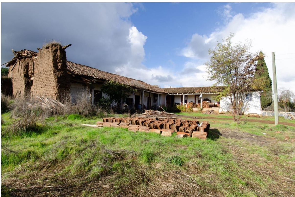
Figura 6. Fundo Miramar, comuna de Quirihue, Región de Ñuble, construida en adobe, zona rural, 2021 (acervo: Fundación Aldea)
