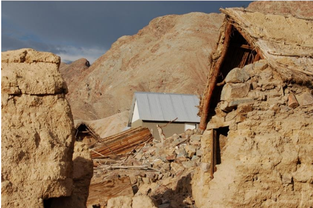
Figura 3 - Poblado de Mocha, en la quebrada de Tarapacá el año 2008, reconstrucción post terremoto de 2005, las viviendas otorgadas por el subsidio no respetan la cultura constructiva existente
