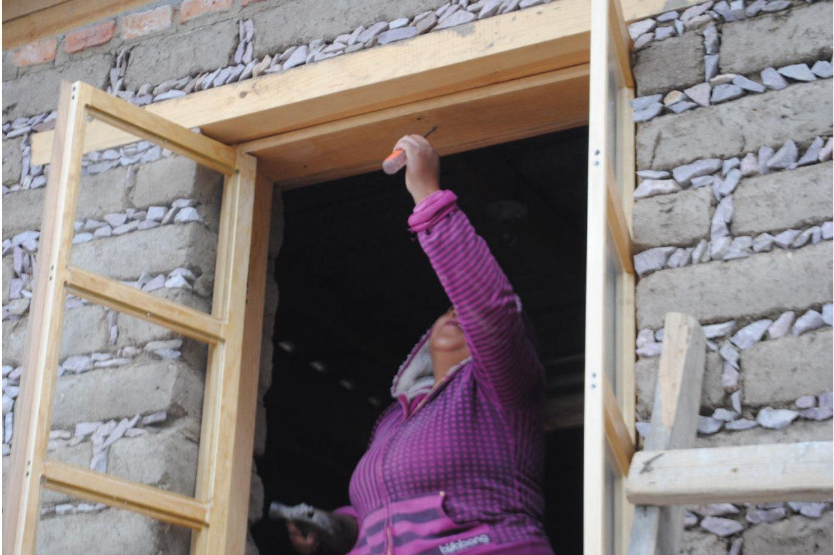
Figura 9. Construcción de vivienda de adobe en la localidad de Palo Colorado, San Miguel de Allende, Guanajuato México
