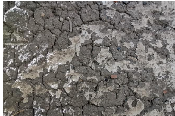
Figura 5. Detalle de aplanados de tierra, sobre muros de adobe en edificación localizada en la Región del Bajío, municipio de León, Guanajuato, México
