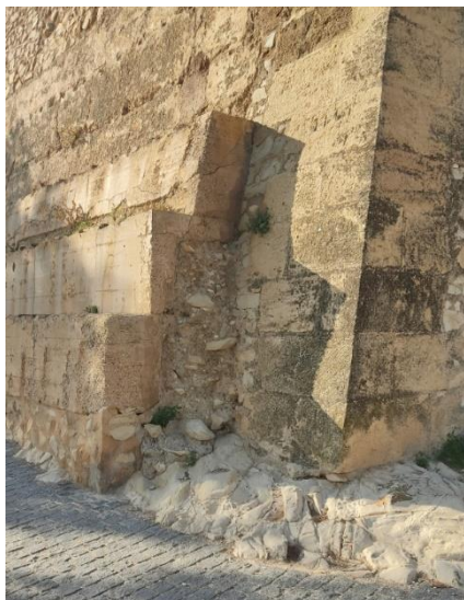
Figura 2. Rezarpa escalonada y esquina nordeste
