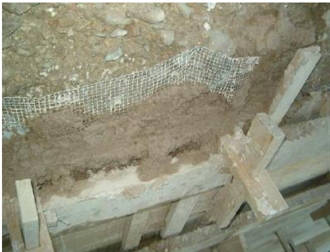
Figura 5. Proceso de reintegración con malla de fibra de vidrio en el alzado sur (crédito: Pedro Collado)
