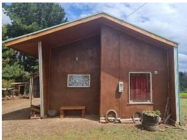
Figura 1. Conjunto habitacional Vivienda Origen
