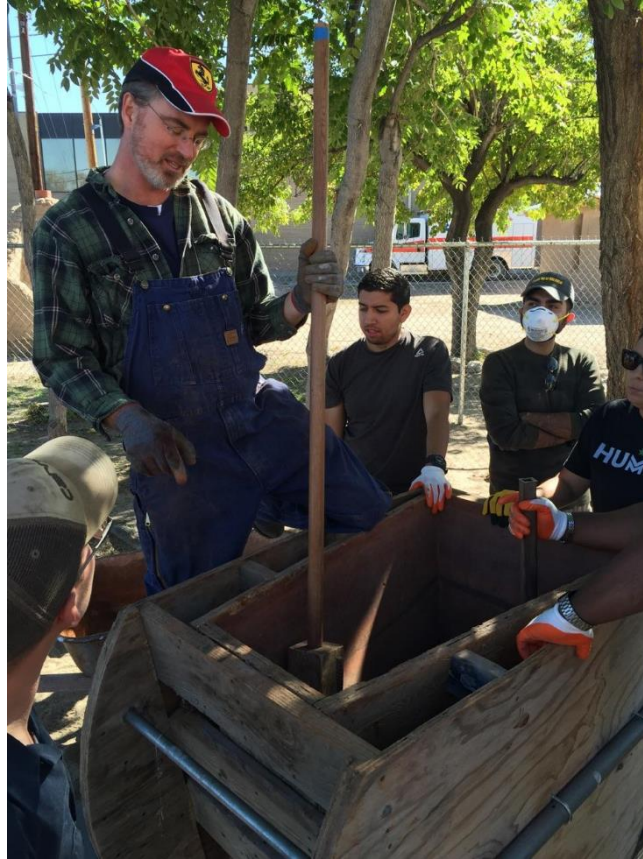
Figura 3. Arquitecto Eric Haskins demostrando la compactación de tierra húmeda en la forma de madera en la comunidad de Bernalillo, Nuevo México
