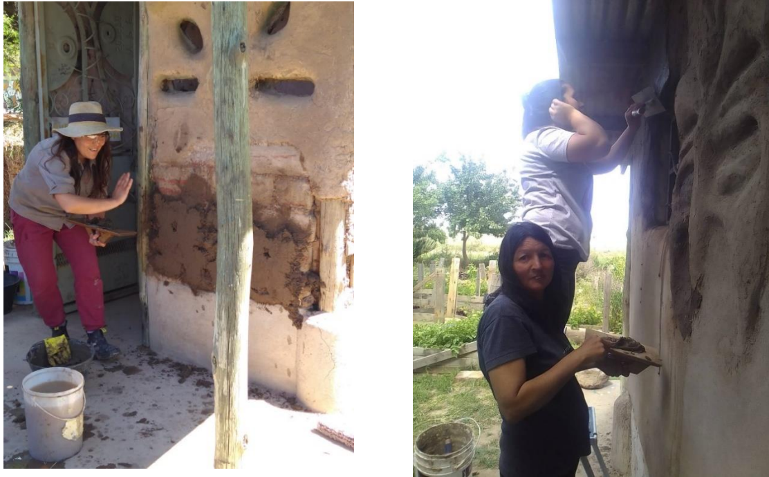
Figura 4. Aplicación de revoques gruesos y finos con herramientas
