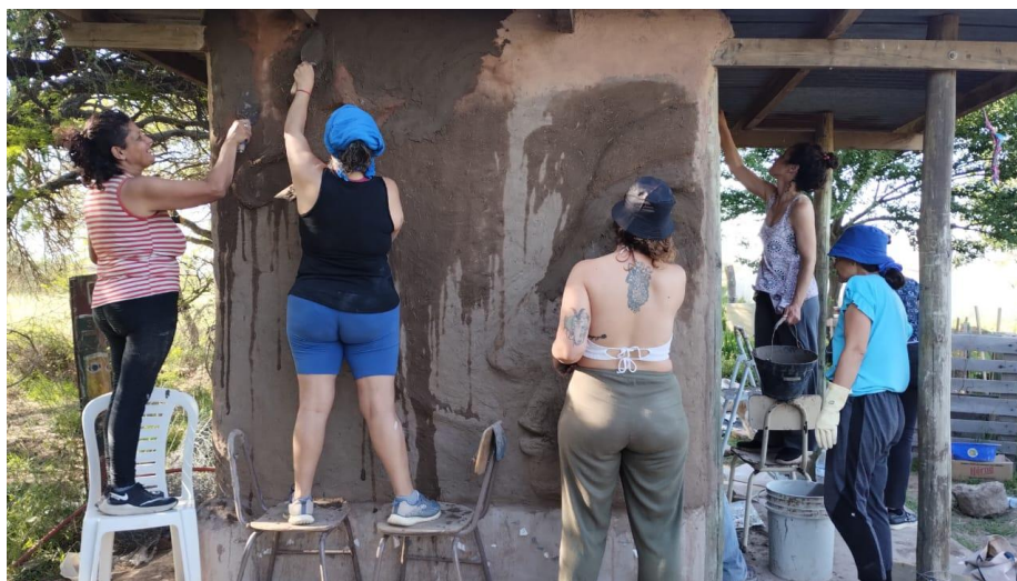
Figura 5. Aplicación de revoques finos y finos
