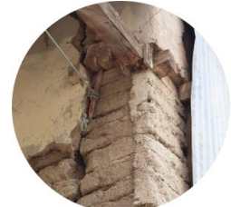
Detalle 2. Dispositivo sismo resistente.
