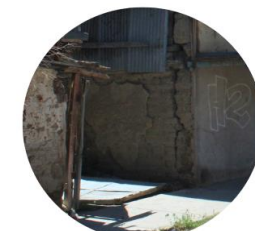
Detalle 5. Muros adobe
