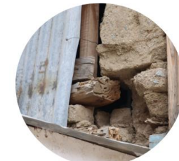
Detalle 4. Unión madera estructural.
