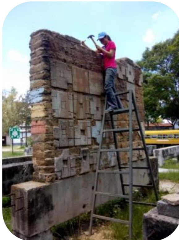
Figura 1: Muestra del muro a evaluar y la obtención de la materia prima para la realización de los prismas y los cubos ensayados
