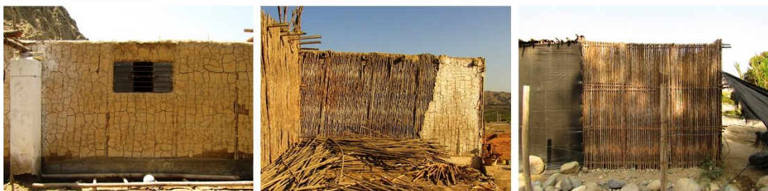
Figura 3. Viviendas de quincha de caña brava en Caltopilla y la clasificación de la técnica constructiva de quincha y su revestimiento (Luna, 2023)
