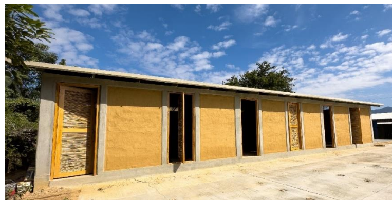
Figura 6. Aulas educativas con muros de bahareque o técnicas mixtas, Villa Corzo, Chiapas, 2023 (Crédito: A. Cortes)
