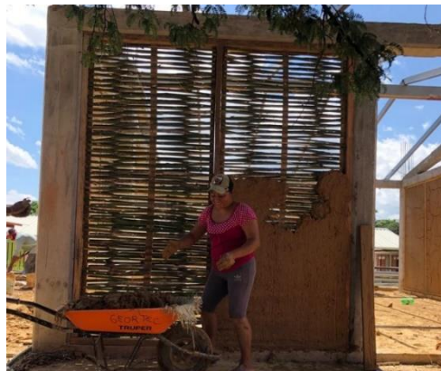
Figura 5. Elaboración de muros de bahareque o técnicas mixtas para la construcción de aulas educativas, Villa Corzo; Chiapas. 2023.
