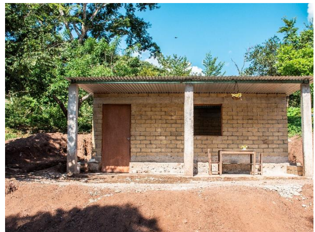
Figura 4. Vivienda de BTC en el municipio de La Concordia, Chiapas, 2019
