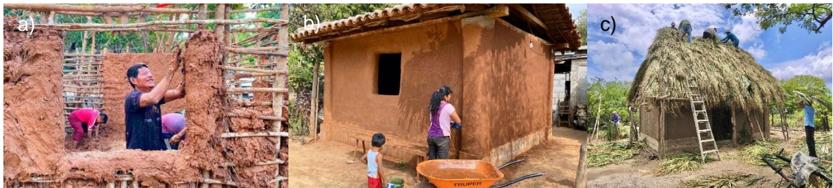
Figura 4. Ejemplos de adaptaciones en cocinas: a) Construcción de muros con estructura de copachín ; b) Cocina con techo de teja; c) Cocina con techo de palma (Fuente: Cooperación Comunitaria A. C.)
