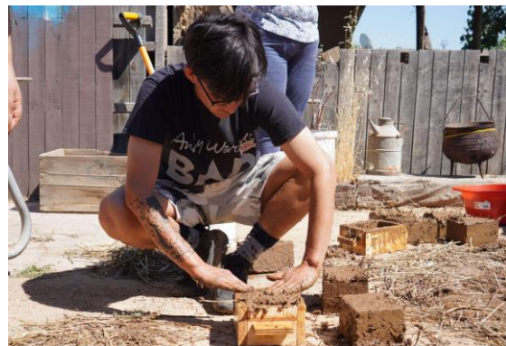
Figura 5. Elaboración de adobes a escala, por parte de los participantes
