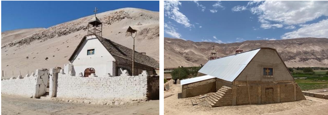
Figura 7. A la izquierda, mojinete con totora, y a la derecha, mojinete con calamina
