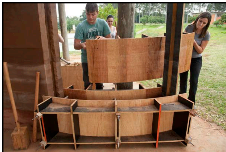
Figura 1: Alumnos del quinto semestre construyendo una pared curva en tapia. Campus Santa Bárbara D' Oeste-FEAU-Maio/2012.
