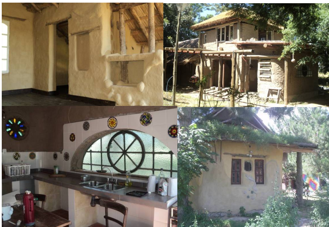
Figura 4: Obras con intervención de profesionales
