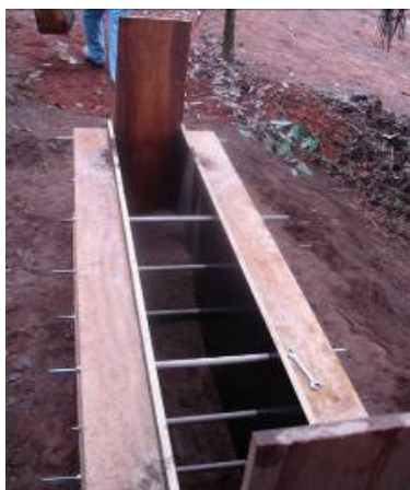
Figura 3: Montagem da forma
