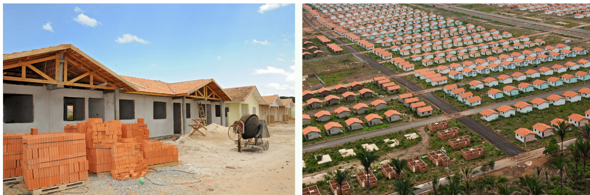
Figura 1. Construções em bloco cerâmico, no Paraná (01/12) e no Piauí (12/11). Fonte: Divulgação do Programa [brasileiro] de Aceleração do Crescimento (PAC) pelo Governo Federal.
