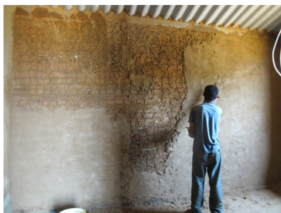
Figura 2. Oficina de reboco com terra e areia
